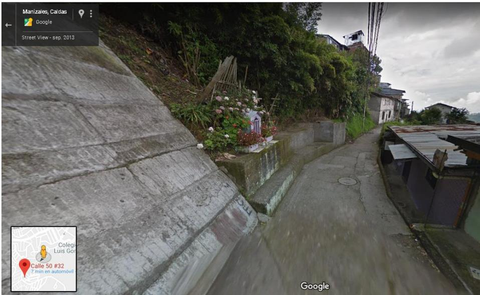
Carrera 29B Calle 49C: Conforme a lo indicado en el POT se tienen labores geotécnicas que incluyen muro en concreto reforzado, perfilado y tratamiento vegetal – ATG 61.
