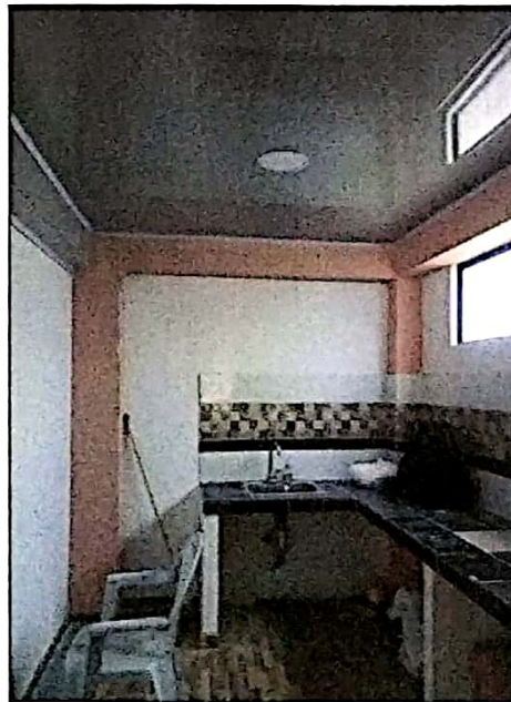
Fotografía 6. Enchape de paredes de Cocina con cerámica.
