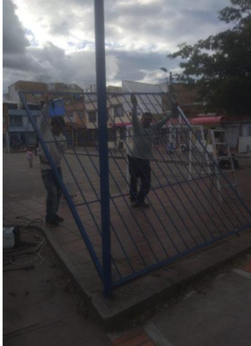
Imagen 4. Instalación de Cerramiento de protección e impacto sobre carrera 2 Este
