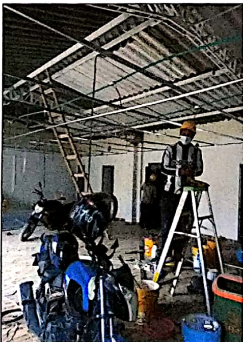
Fotografía 9. Instalación de Tubería Condut para red Eléctrica según parámetros de la Norma RETIE.
