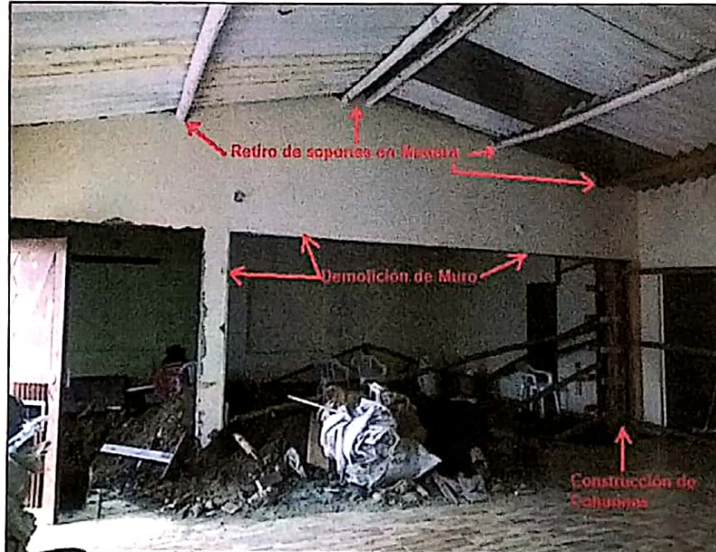
Fotografía 1. Muro y soportes en madera deteriorados que sostienen el techo de hojas de fibrocemento.
