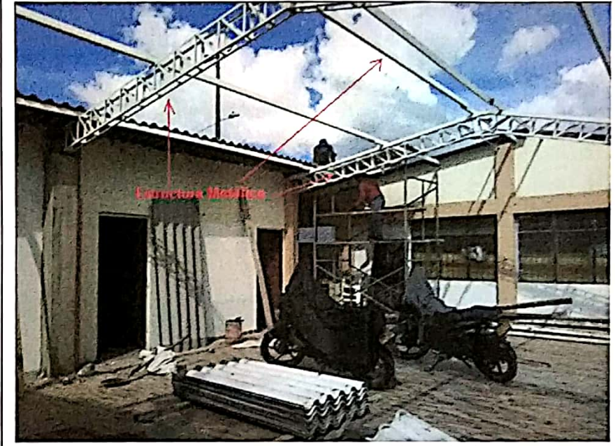
Fotografía 2. Instalación de Estructura Metálica con soportes en Tubo Cuadrado a lo largo de la estructura.
