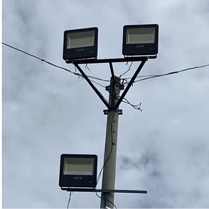
Imagen 3. Reflectores LED de 400W instalados en la Cancha de Fútbol del barrio El Tejar.
