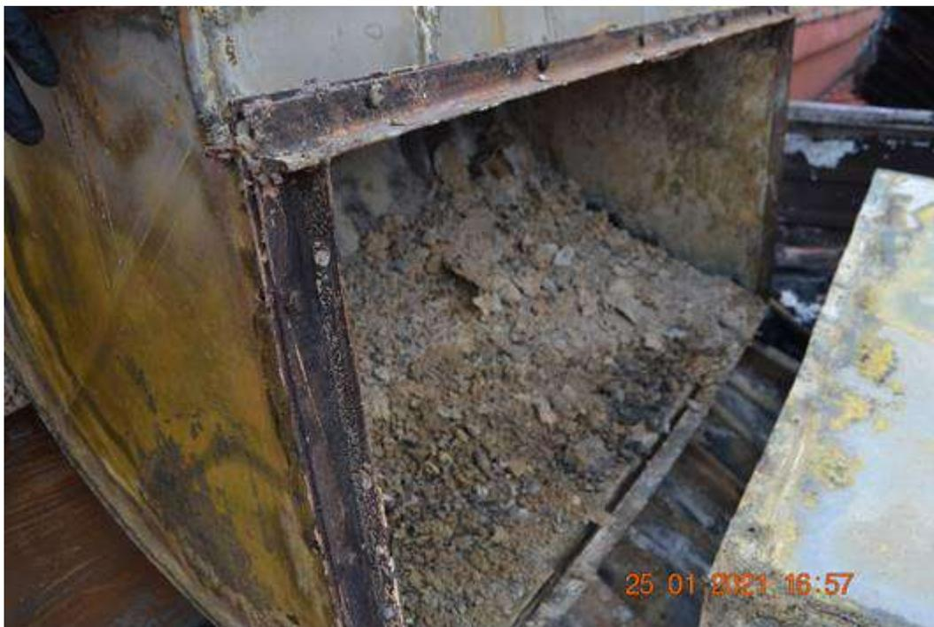
**Se observa los residuos de grasa quemada en el codo superior del sistema.**
