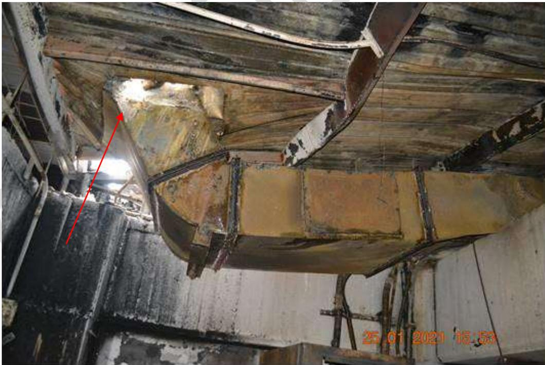
**Se señala la salida del ducto a la cubierta superior del centro comercial.**
