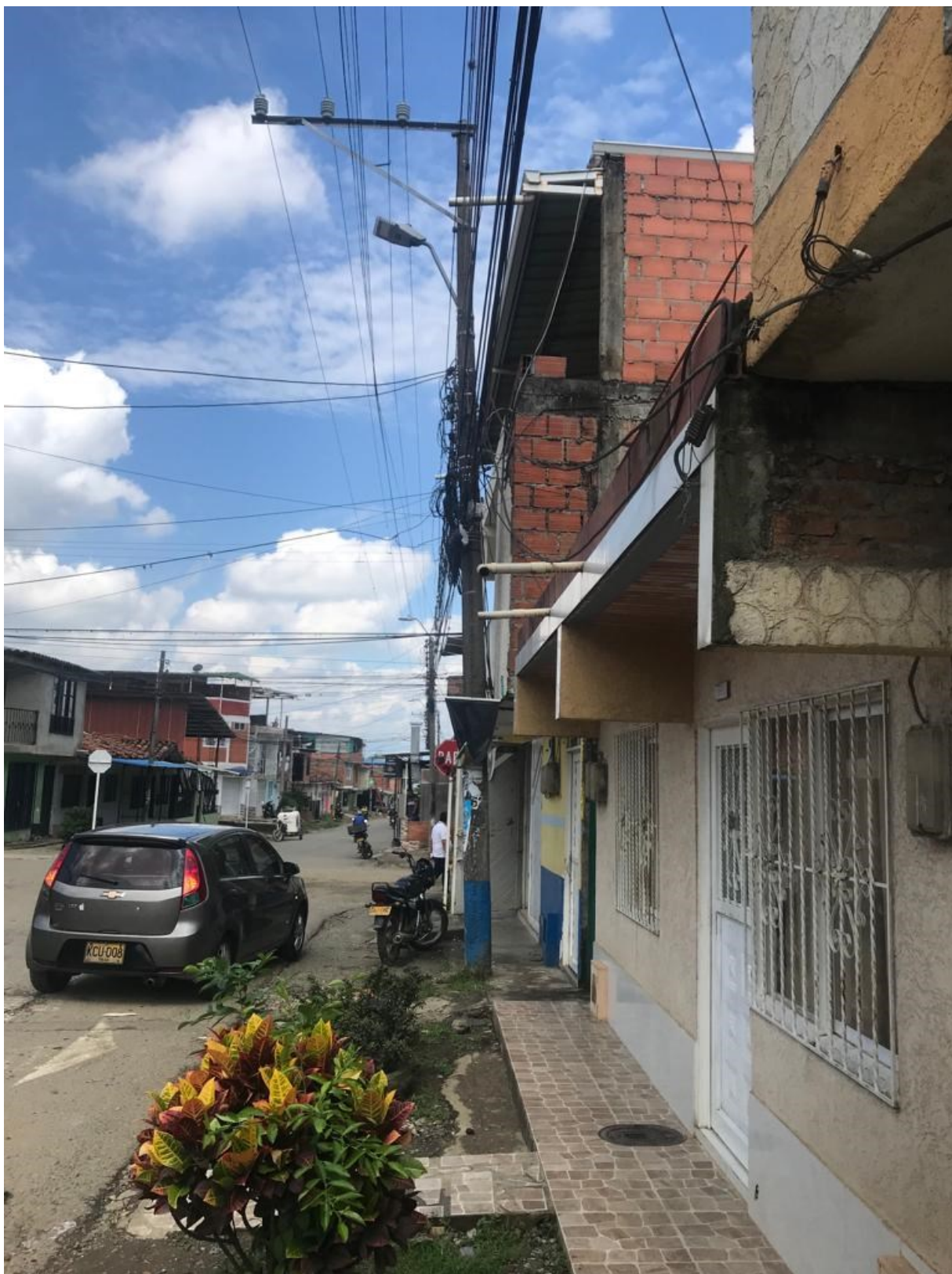
Fotografía No 4 – Vista lateral desde la calle 4- edificación y red MT actual
