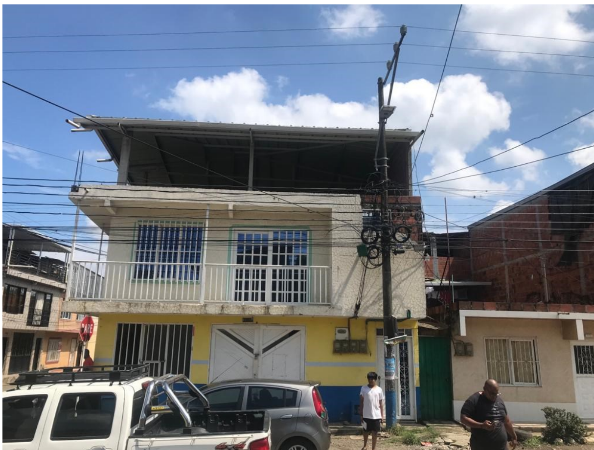
Fotografía No 3. Edificación fachada sobre calle 4 y red MT actual
