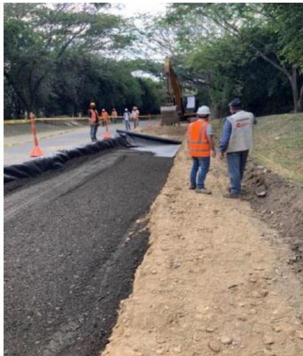
**Figura 9.** Extensión de material tipo subbase sobre geotextil. Se emplea material reciclado para las bermas.
