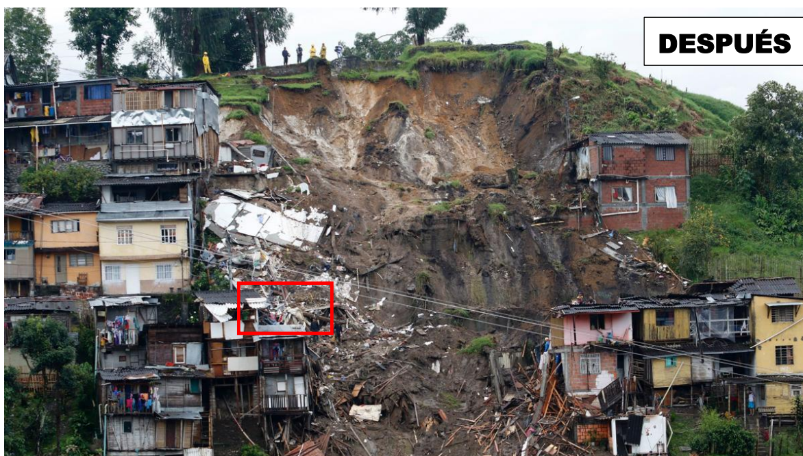
IMAGEN BARRIO PERSIA DESPUÉS DEL DESLIZAMIENTO DE 19/ABR/2017 (El polígono representa punto de referencia común en ambas imágenes)
