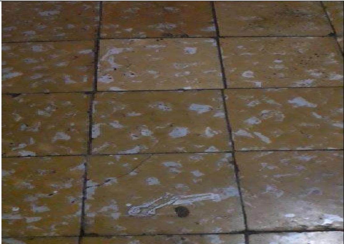
**PISO EN BALDOSA LEVANTADO, AGRIETADO Y DESNIVELADO.
