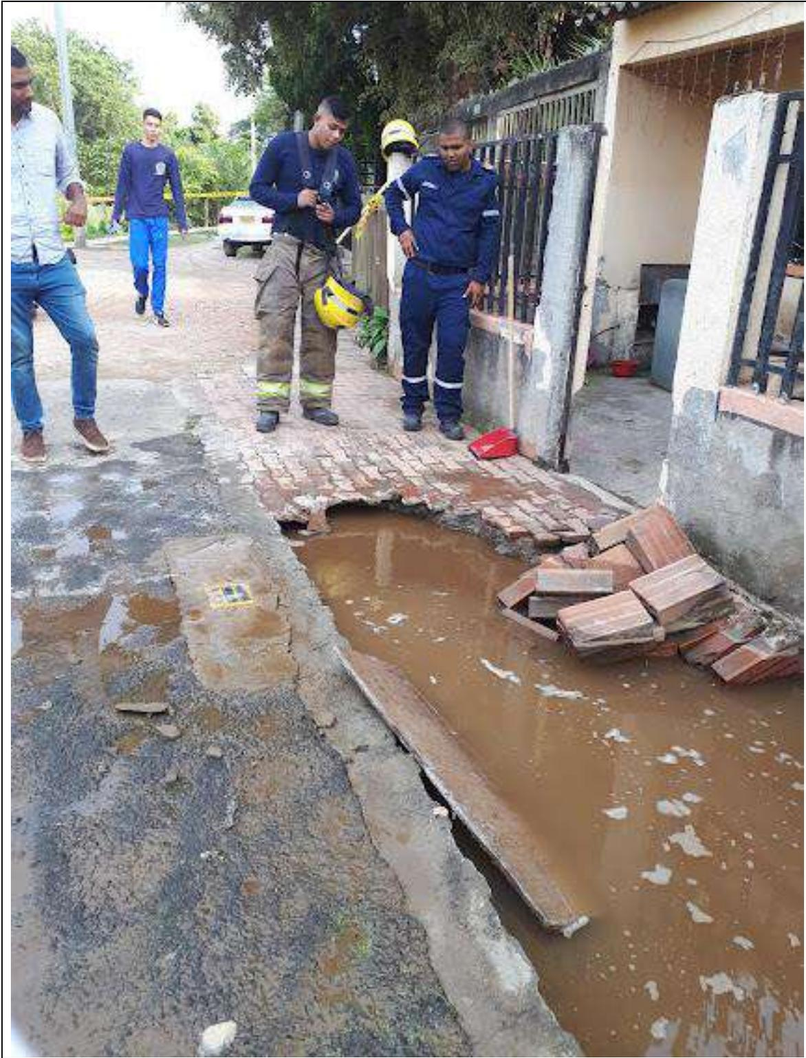
**DAÑO FUGA DE AGUA PROVOCA SOCAVACIÓN**
