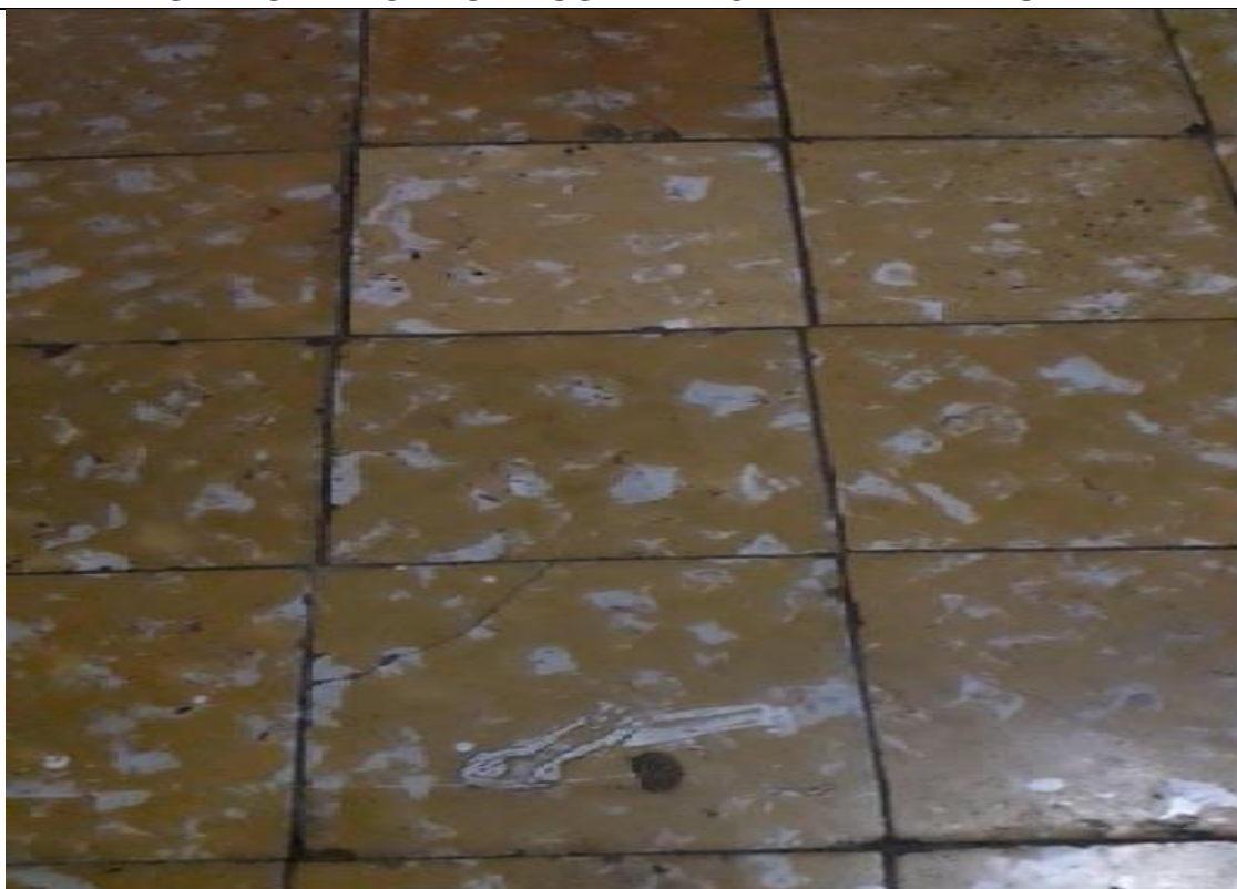
PISO EN BALDOSA LEVANTADO, AGRIETADO Y DESNIVELADO. HABITACION 2
