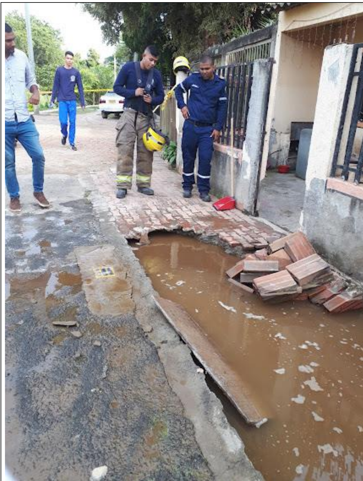
DAÑO FUGA DE AGUA PROVOCA SOCAVACIÓN
