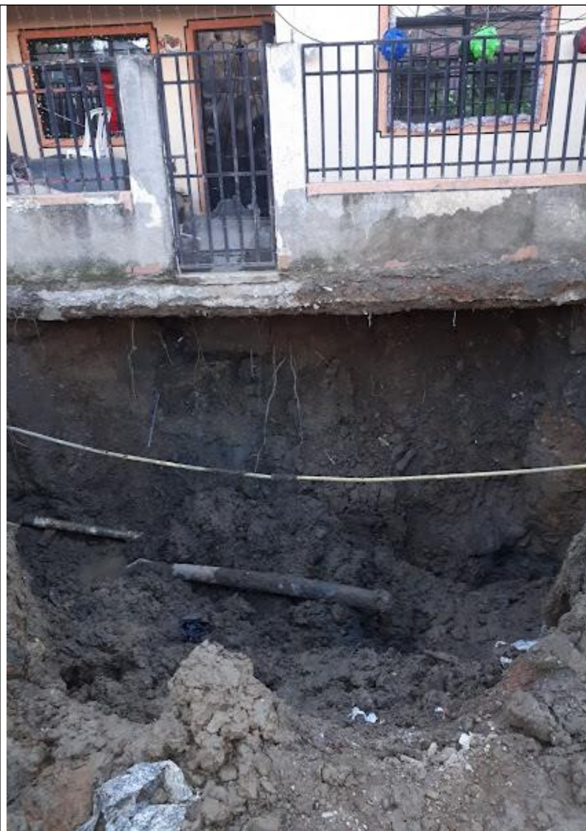
SE OBSERVA COMO SE EXPONE LA ESTRUCTURA DE LA VIVIENDA
