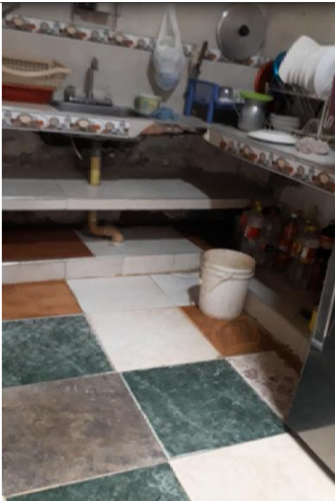
ESTADO ACTUAL DE LA COCINA, SE OBSERVA LA CERAMICA DEL PISO LEVANTADA Y FISURADA EL MESON DETERIORADO Y LA HUMEDAD QUE SE ENCUENTRA SOBRE TODA LA VIVIENDA
