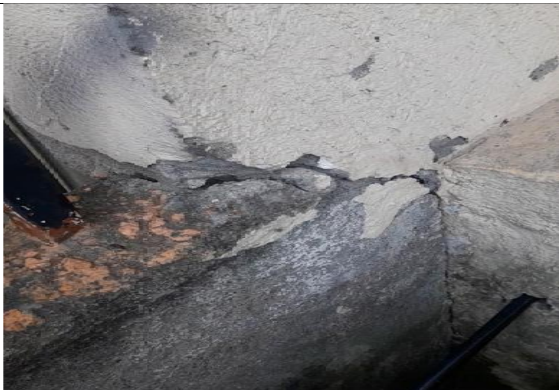
SE OBSERVA COMO SE DESPRENDE EL MURO DEL ANTEJARDIN DEL MURO DE LA FACHADA DE LA VIVIENDA
