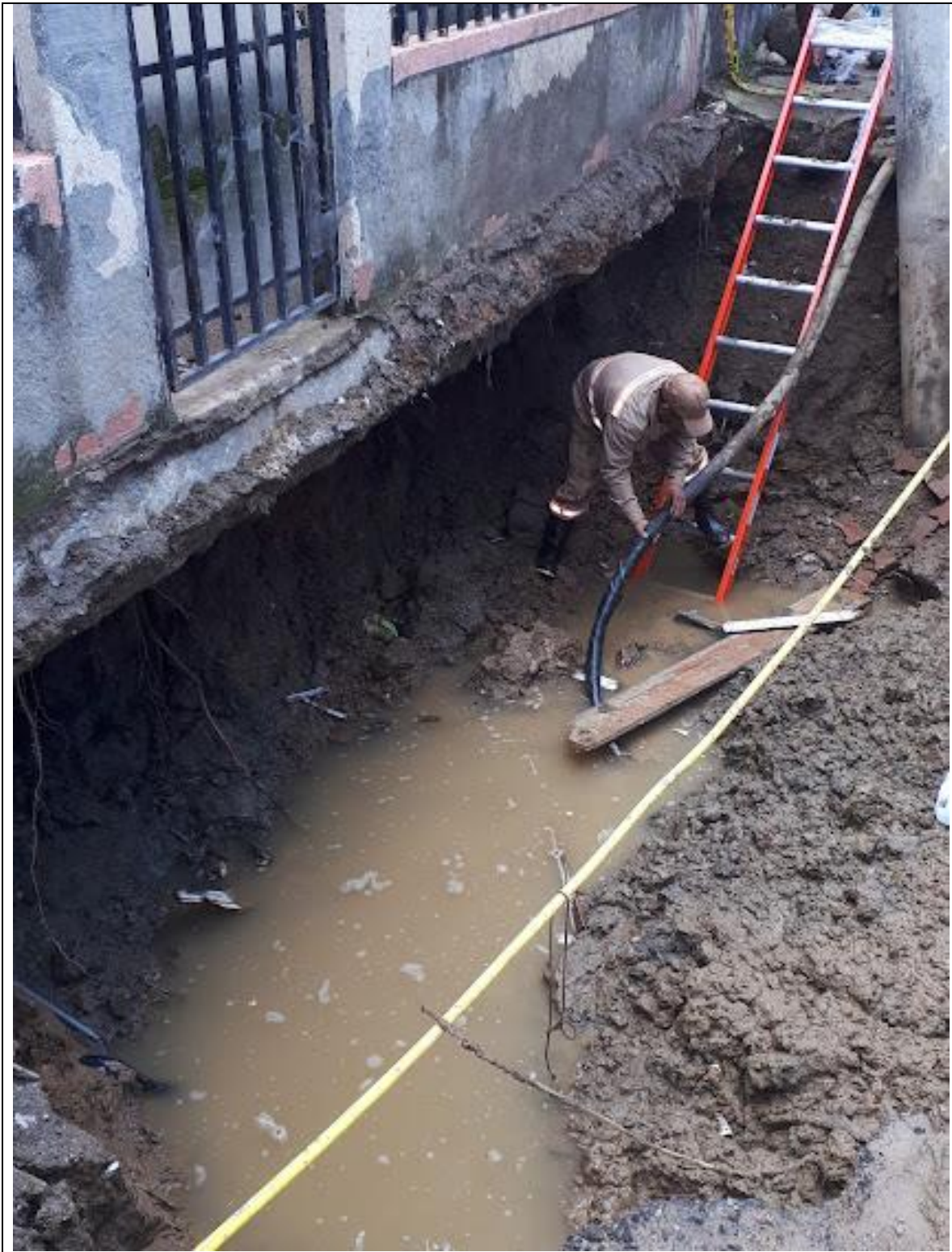
SOCAVACIÓN
