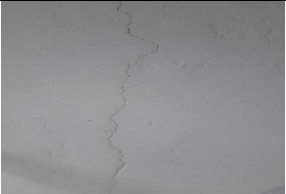
FISURA SE VUELVE A PRONUNCIAR AUNQUE YA HA SIDO ARREGLADO POR LA PROPIETARIA EN LA SALA
