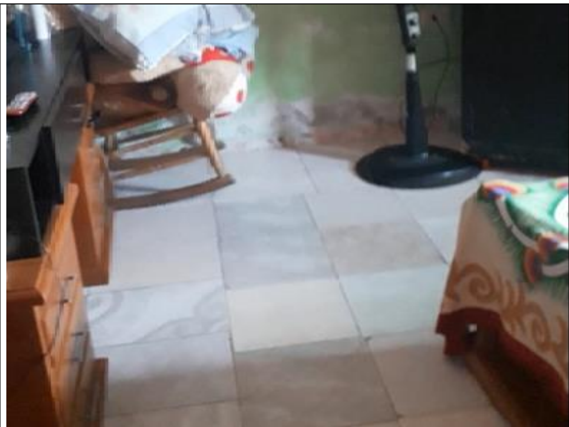
PISO DESNIVELADO Y CERÁMICA AGRIETADA HABITACIÓN N° 1
