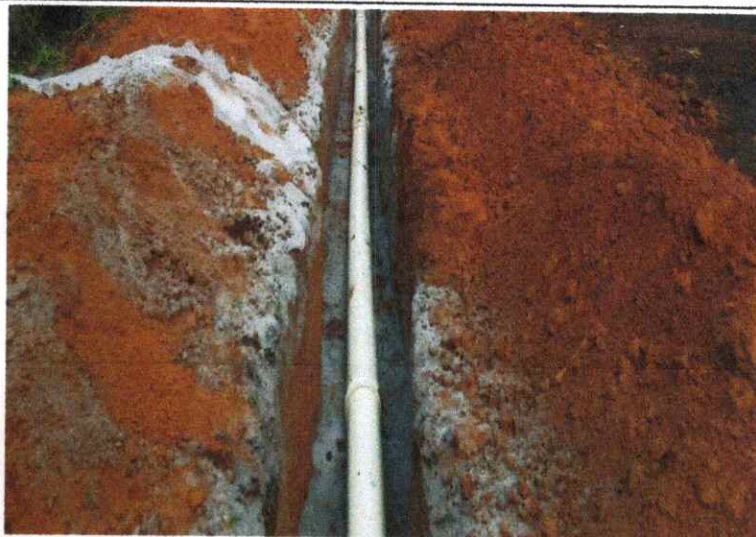
INSTALACION DE TUBERIA DE 8"
