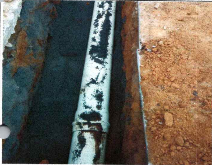
INSTALACION DE TUBERIA DE 6"
