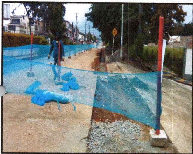
FOTOGRAFIA 5: CERRAMIENTO CON POLISOMBRA Y COLOMBINAS EN LA SALIDA DEL CONJUNTO TORRES DEL BOSQUE
