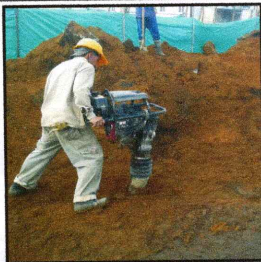
FOTOGRAFIA 6: COMPACTACION DEL RELLENO DE LA CAMARA DE INPECCION N°15 HASTA LA CAMARA 14
