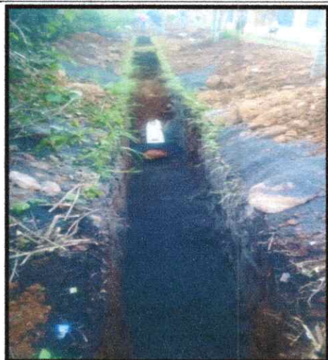
FOTOGRAFIA 1: CAMA DE ARENA PARA LA INSTALACION DE TUBERIA DE 8" EN EL TRAMO 1 DE LA RED DE DISTRIBUCION DE ACUEDUCTO. FRENTE AL CONJUNTO RESIDENCIAL ASTURIAS
