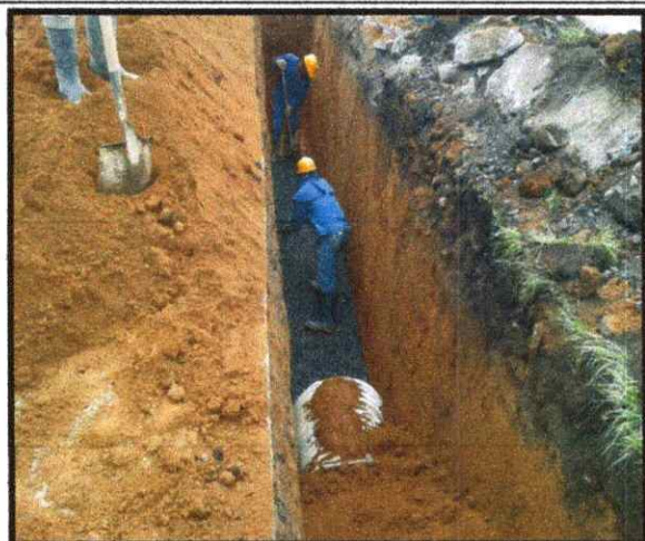
FOTOGRAFIA 3: COLOCACION DE COLCHON DE GRAVA TM 3/4" PARA INSTALACION DE TUBERIA DE ALCANTARILLADO PLUVIAL EN EL TRAMO 2 DESDE LA CAMARA 14 HASTA LA CAMARA 13
