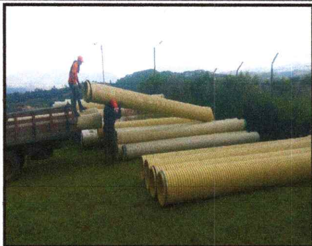
FOTOGRAFIA 1: CONTROL DE SUMINISTRO DE TUBERIA DE ALCANTARILLADO SANITARIO, PLUVIAL Y ACUEDUCTO
