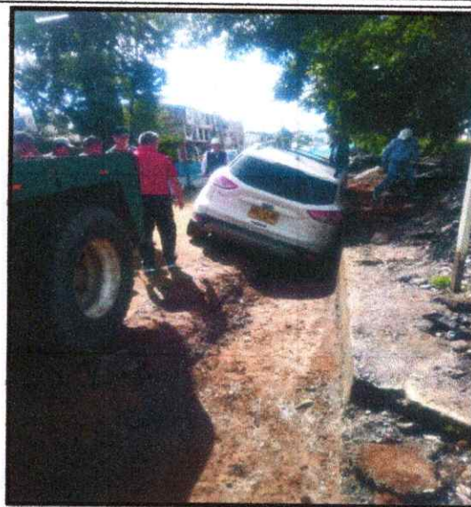
FOTOGRAFIA 10: FALTA DE PRECAUCION, INGRESANDO AL CARRIL QUE SE ENCUENTRA INHABILITADO PARA EL TRANSITO VEHICULAR QUE CUENTA CON SU RESPECTIVA SEÑALIZACION
