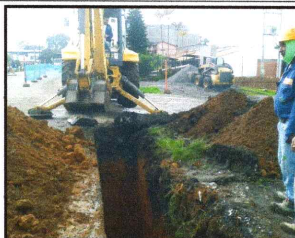
FOTOGRAFIA 2: EXCAVACION A MAQUINA PARA INSTALACION DE TUBERIA EN EL TRAMO DESDE LA CAMARA 14 A LA CAMARA 13
