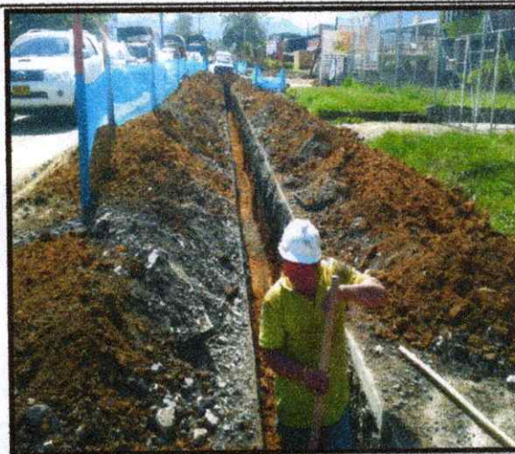
FOTOGRAFIA 2: EXCAVACION A MANO PARA INSTALACION DE TUBERIA DE 6" DE LA RED DE DISTRIBUCION DE ACUEDUCTO EN EL TRAMO 2
