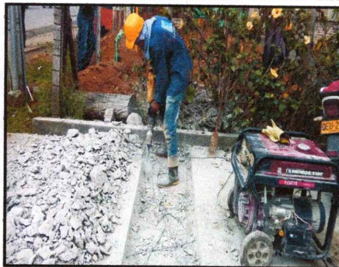
FOTOGRAFIA 6: DEMOLICION DE CONCRETO PARA INSTALACION DE TUBERIA DE 8" DE LA RED DE DISTRIBUCION DE ACUEDUCTO
