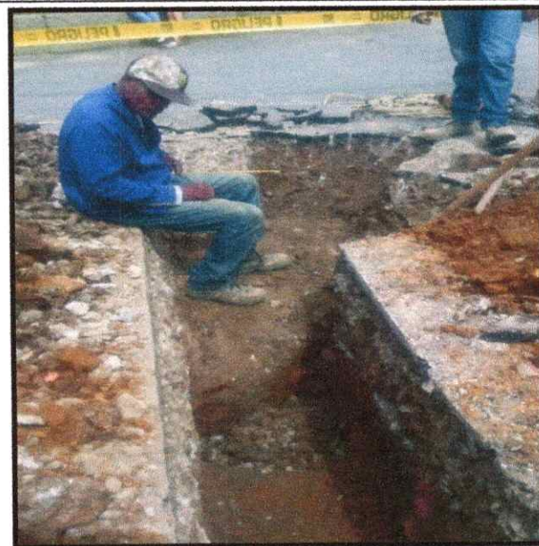
FOTOGRAFIA 6: EXTENSION DE MATERIAL DE ROCA MUERTA PARA MEJORAMIENTO DE LA CALLE 53N
