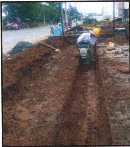
FOTOGRAFIA 9: COMPACTACION DE RELLENO EN DONDE SE INSTALO TUBERIA DE 8" DE LA RED DE DISTRIBUCION DEL ACUEDUCTO
