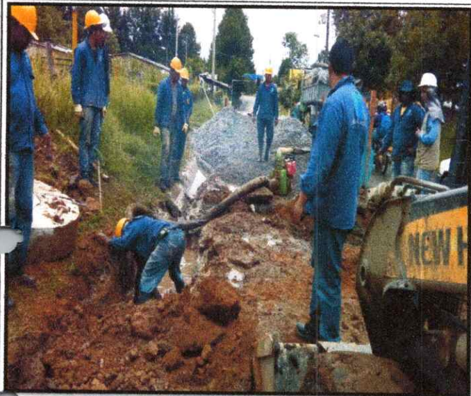
FOTOGRAFIA 9: ACHIQUE DE AGUAS POR BOMBEO
