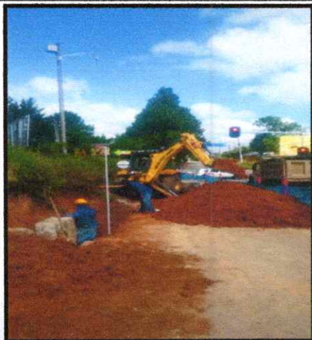
FOTOGRAFIA 3: EXCAVACION A MAQUINA PARA INSTALACION DE TUBERIA DE 24" EN EL TRAMO DESDE LA CAMARA 20 A LA CAMARA 19 DEL ALCANTARILLADO PLUVIAL
