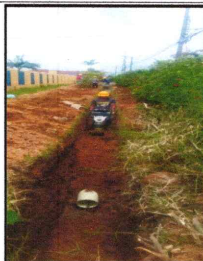
FOTOGRAFIA 2: COMPACTACION DEL RELLENO DONDE SE INSTALO TUBERIA DE 8" TRAMO 1 DE LA RED DE DISTRIBUCION DE ACUEDUCTO. FRENTE AL CONJUNTO RESIDENCIAL ASTURIAS
