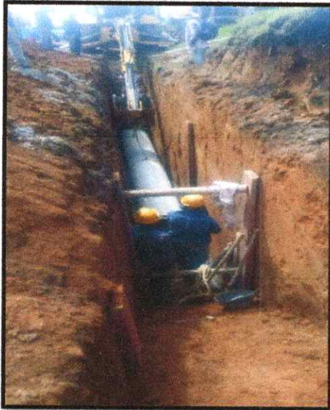
FOTOGRAFIA 5: INSTALACION DE TUBERIA DE 24" DESDE LA CAMARA 20 A LA CAMARA 19 EN EL TRAMO 2 DEL ALCANTARILLADO PLUVIAL
