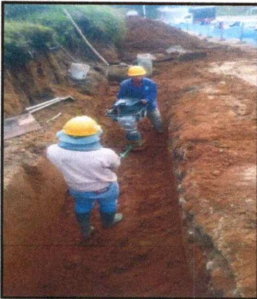
FOTOGRAFIA 7: COMPACTACION DE RELLENO POR CAPAS EN EL TRAMO DESDE LA CAMARA 20 A LA CAMARA 19 DEL ALCANTARILLADO PLUVIAL
