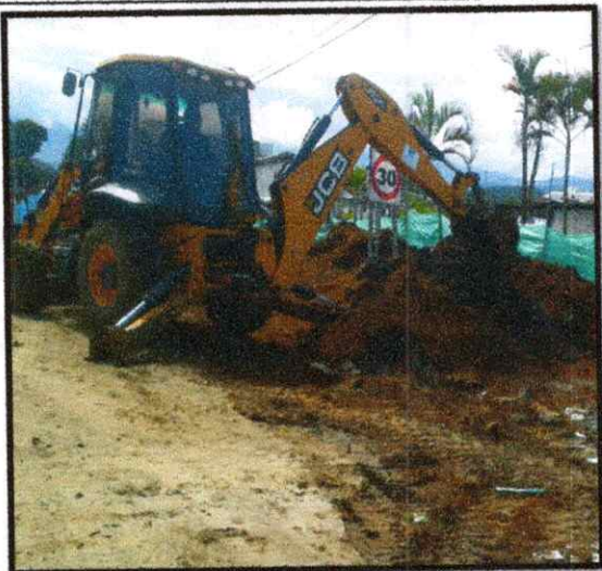
FOTOGRAFIA 5: EXCAVACION A MAQUINA EN EL TRAMO DESDE LA CAMARA 15 HASTA LA CAMARA 14
