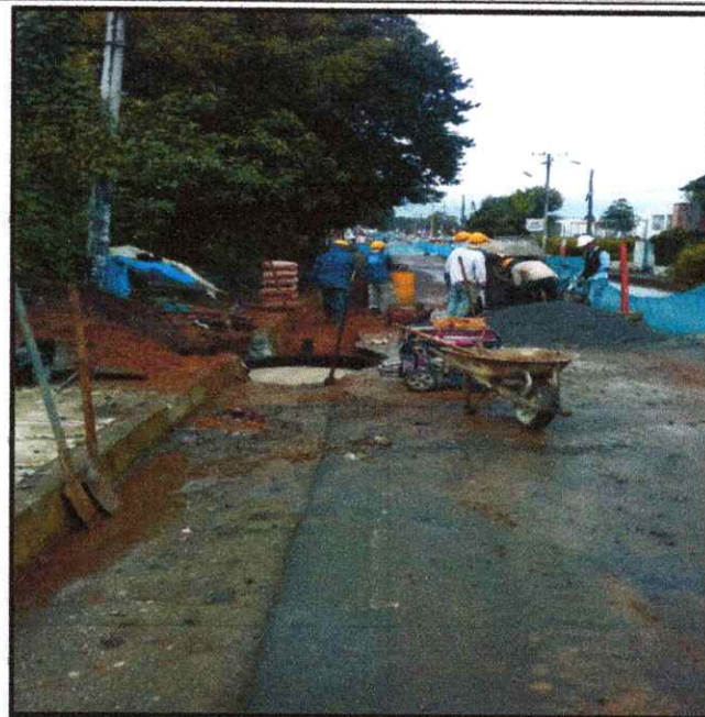
FOTOGRAFIA 8: CONSTRUCCION DE LA CAMARA 11 DEL ALCANTARILLADO PLUVIAL EN EL TRAMO 2
