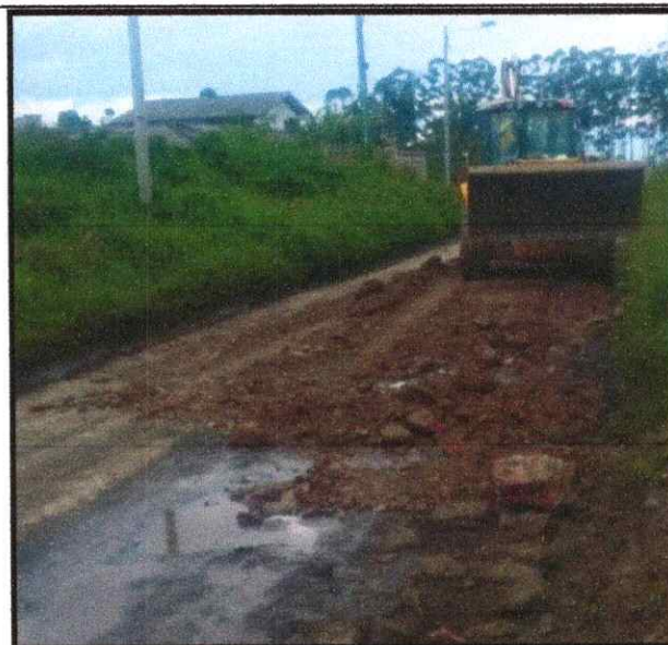
FOTOGRAFIA 6: EXTENSION DE MATERIAL DE ROCA MUERTA PARA MEJORAMIENTO DE LA CALLE 53N
