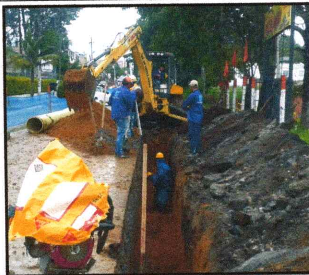
FOTOGRAFIA 10: EXCAVACION A MAQUINA PARA INSTALACION DE TUBERIA EN EL TRAMO DESDE LA CAMARA 13 A LA CAMARA 12 DEL ALCANTARILLADO PLUVIAL
