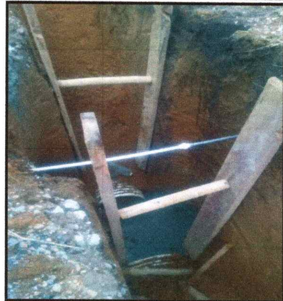
FOTOGRAFIA 8: SOLADO PARA CONSTRUCCION DE LA CAMARA DE INSPECCION 19 DEL ALCANTARILLADO PLUVIAL
