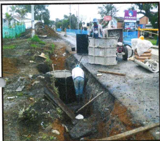
FOTOGRAFIA 9: COLOCACION DE FORMALETA PARA FUNDIR EL SEGUNDO CUERPO DE LA CAMARA DE INSPECCION 14
