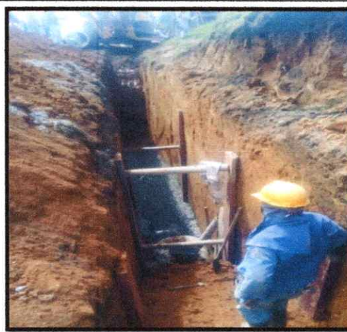
FOTOGRAFIA 4: COLCHON DE GRAVA TM 3/4" PARA INSTALACION DE TUBERIA DE 24" EN EL TRAMO DESDE LA CAMARA 20 A LA CAMARA 19 EN EL TRAMO 2 DEL ALCANTARILLADO PLUVIAL
