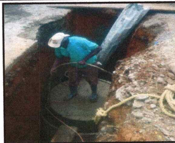
FOTOGRAFIA 4: VIBRACION DEL CONCRETO EN LA CAMARA DE INSPECCION N° 19 DEL ALCANTARILLADO PLUVIAL
