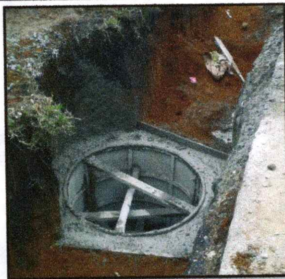
FOTOGRAFIA 6: COMPACTACION DEL RELLENO DE LA CAMARA DE INPECCION N°15 HASTA LA CAMARA 14
