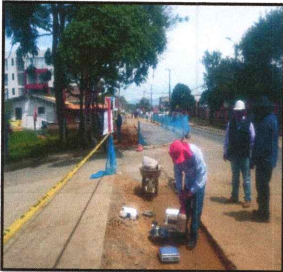
FOTOGRAFIA 9: TOMA DE DENSIDADES EN EL TRAMO DE LA CAMARA 12 A LA CAMARA 11 DEL ALCANTARILLADO PLUVIAL
