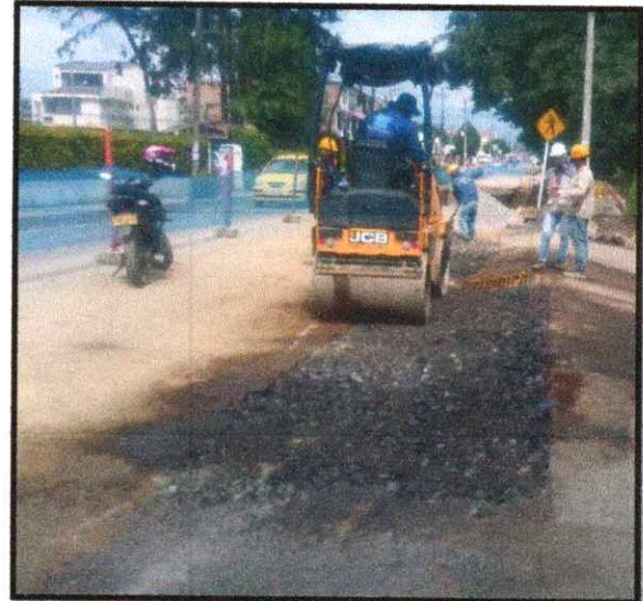
FOTOGRAFIA 10: COMPACTACION DE LA SUBBASE DEL ALCANTARILLADO PLUVIAL EN FRENTE DE TORRES DEL BOSQUE
