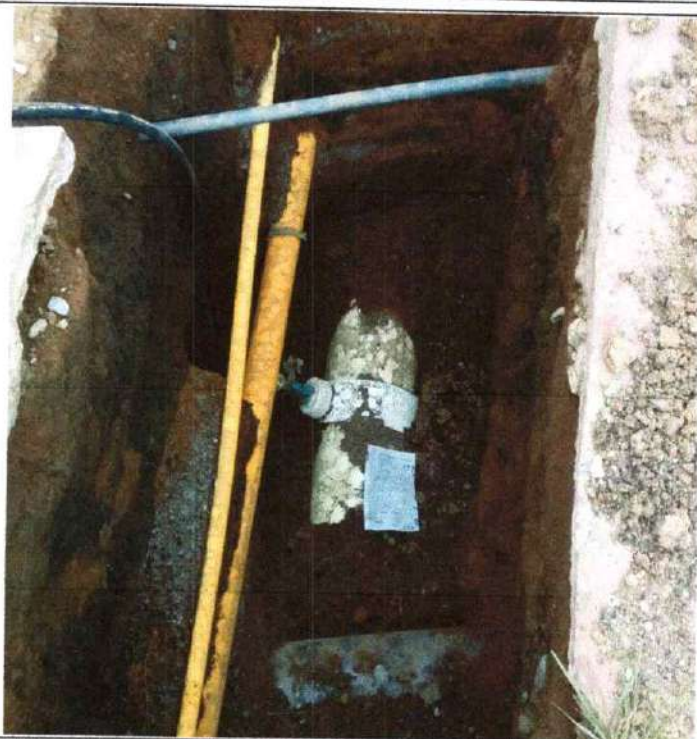
INSTALACION DE COLLARIN DE 8", REGISTRO DE INCORPORACION Y MANGUERA PF 1/2"
