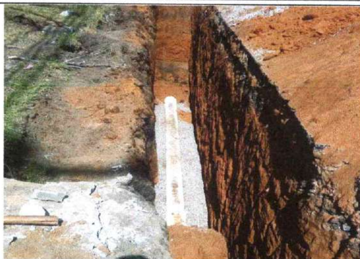
INSTALACION DE TUBERIA PARA ALCANTARILLADO SANITARIO DE 18" Y DE 10"
