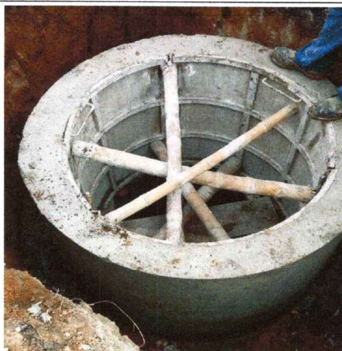
CONSTRUCCION DE CAMARAS EN CONCRETO DE 3000 PSI
