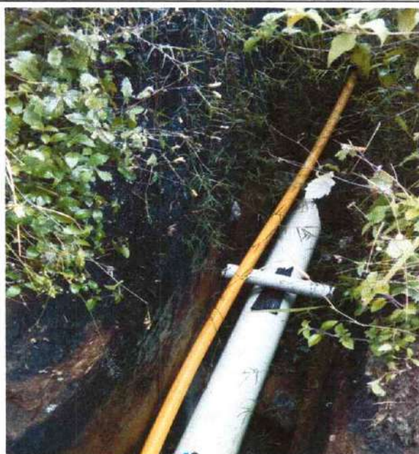
INSTALACION DE TUBERIA BIAIXIAL DE 8" DE LA RED DE DISTRIBUCION DE ACUEDUCTO TRAMO I
