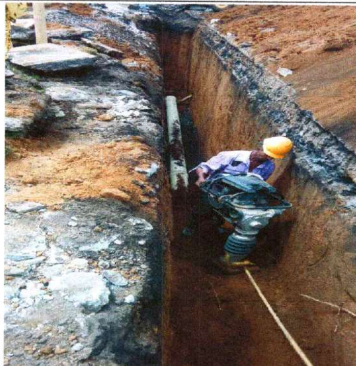
RELLENOS COMPACTADOS MATERIAL DE LIMO AMARILLO IMPORTADO
