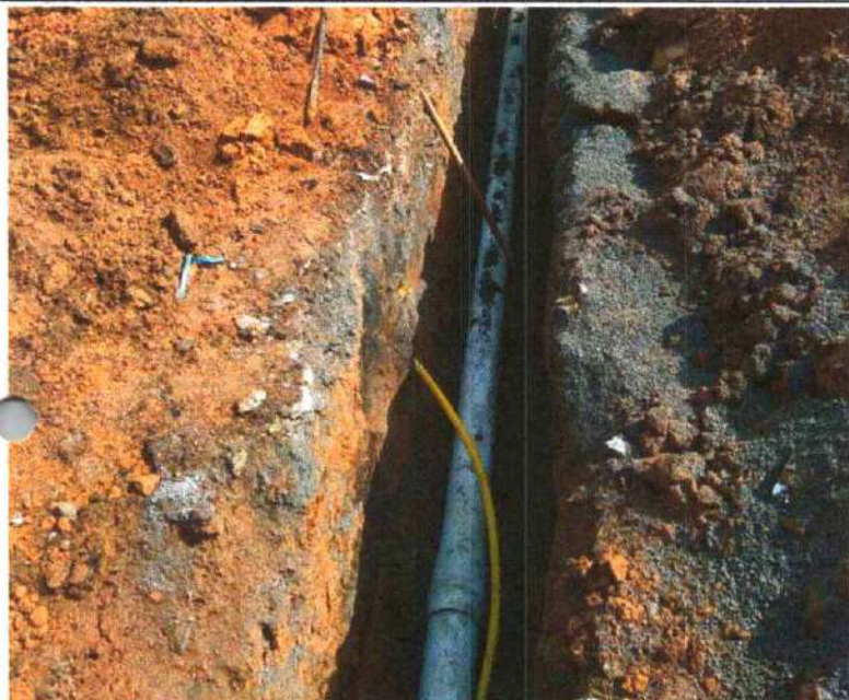
INSTALACION DE TUBERIA BIAIXIAL DE 8" DE LA RED DE DISTRIBUCION DE ACUEDUCTO TRAMO I
