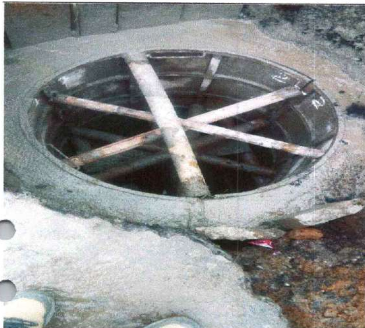
CONSTRUCCION DE CAMARAS EN CONCRETO DE 3000 PSI
