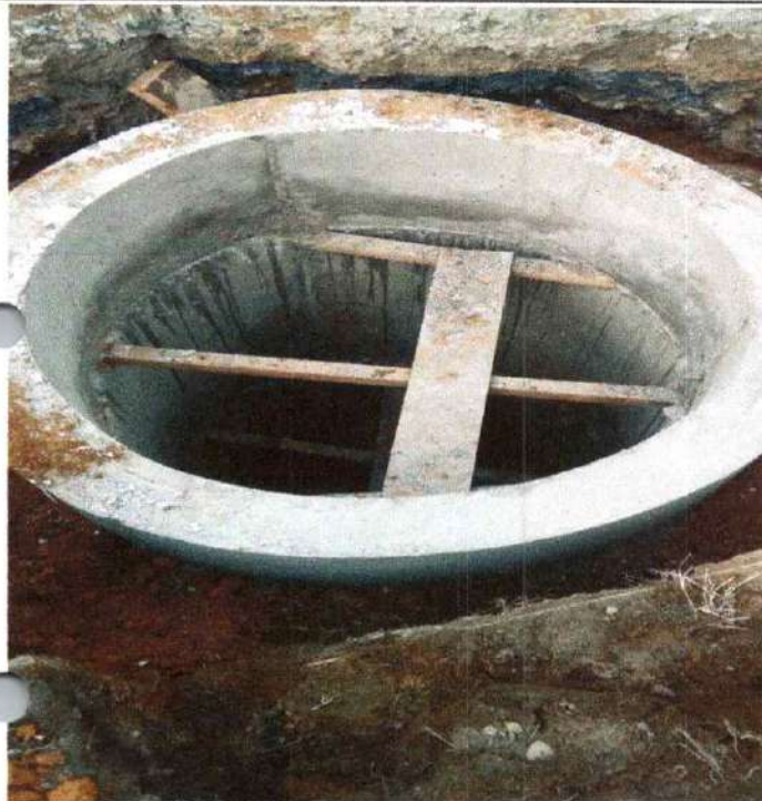
CONSTRUCCION DE CAMARAS EN CONCRETO DE 3000 PSI
