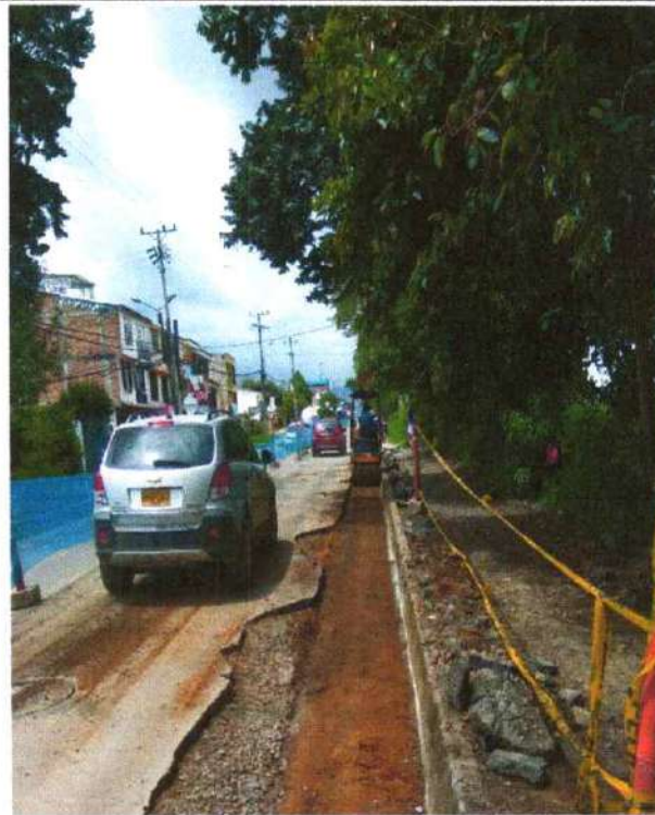
RELLENOS COMPACTADOS MATERIAL DE LIMO AMARILLO IMPORTADO
