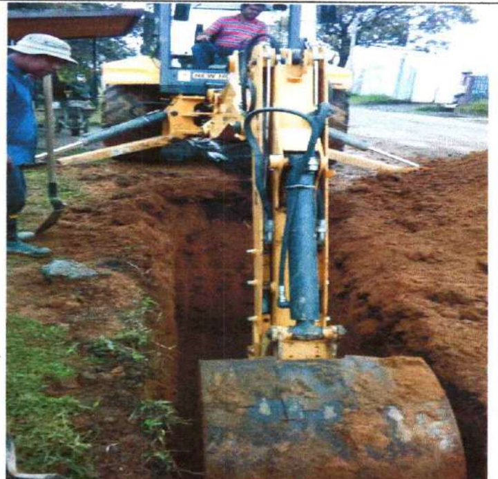
EXCAVACION A MAQUINA PARA RED SANITARIA TRAMO II
