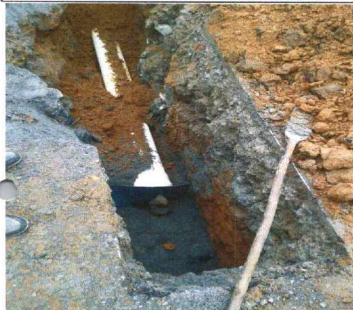
INSTALACION DE TUBERIA BIAXIAL DE 8" PARA TRAOM I RED DE DISTRIBUCION DE ACUEDUCTO
