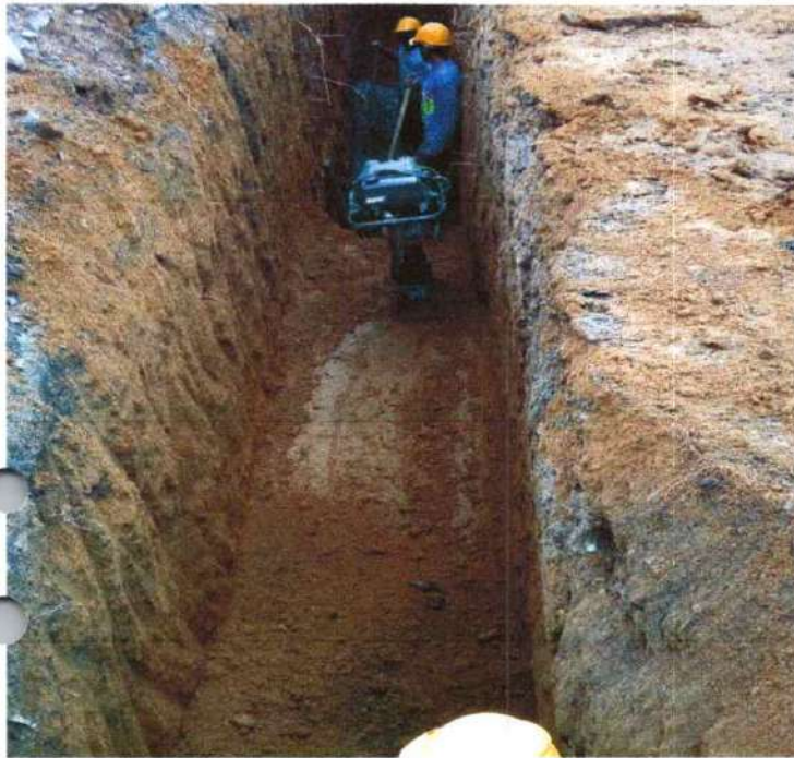
RELLENOS COMPACTADOS MATERIAL DE LIMO AMARILLO IMPORTADO
