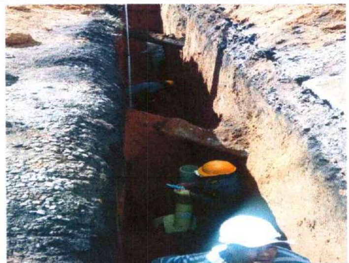
INSTALACION DE SILLA DE 18" X 6"
