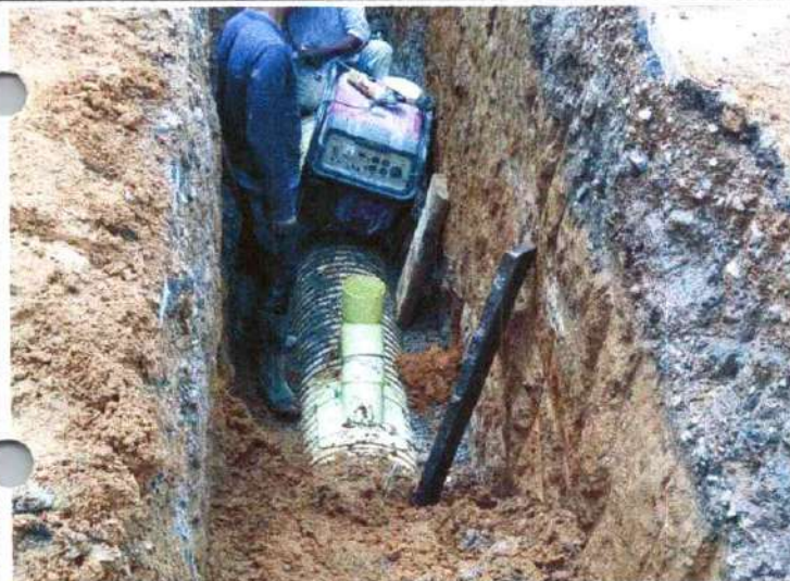
INSTALACION DE SILLA DE 20" X 6"
