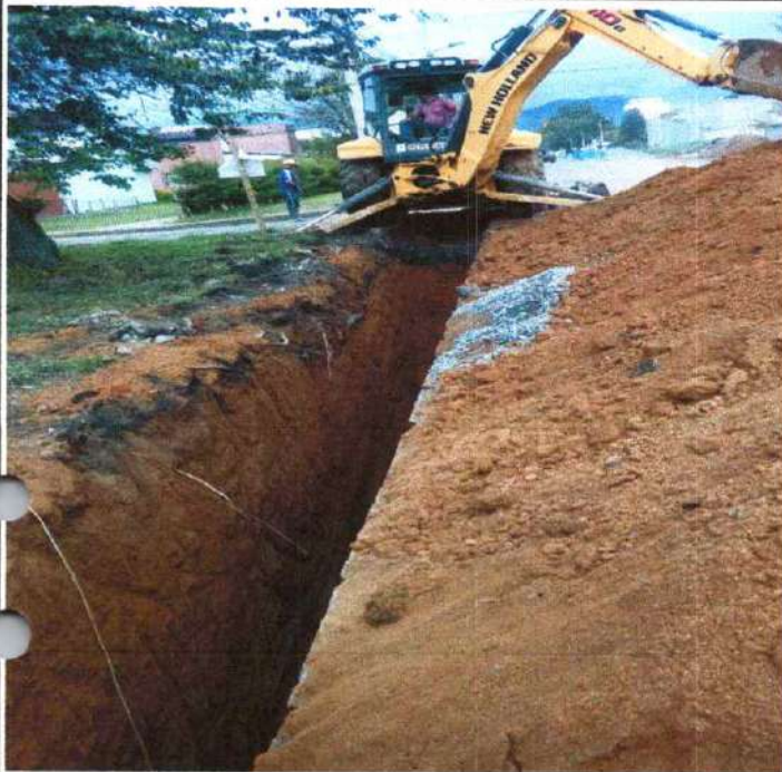
EXCAVACION A MAQUINA PARA RED SANITARIA TRAMO II
