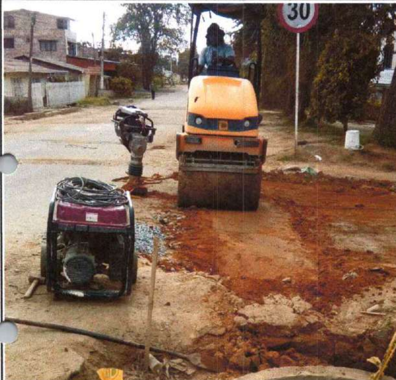
RELLENOS COMPACTADOS MATERIAL DE LIMO AMARILLO IMPORTADO
