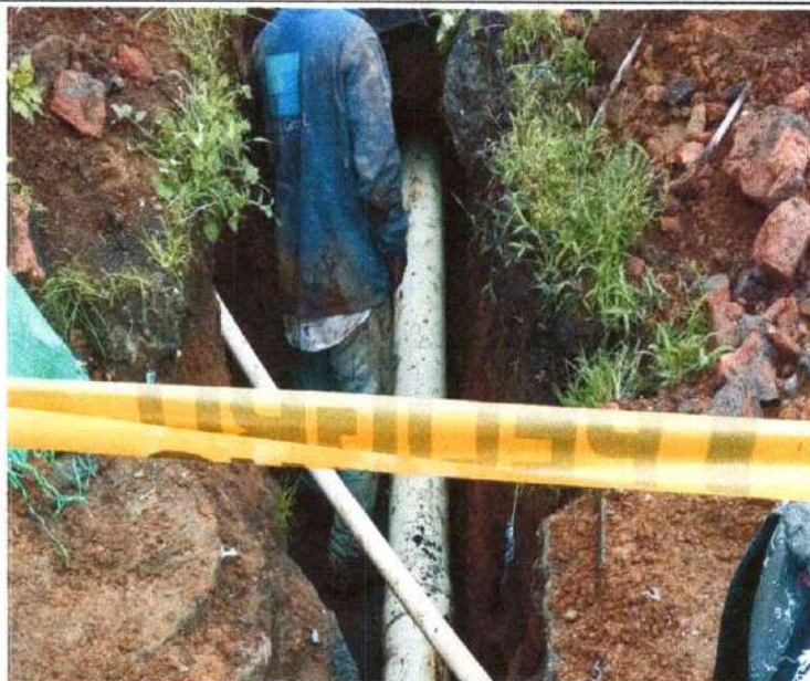
INSTALACION DE TUBERIA BIAXIAL DE 8" PARA TRAOM I RED DE DISTRIBUCION DE ACUEDUCTO
