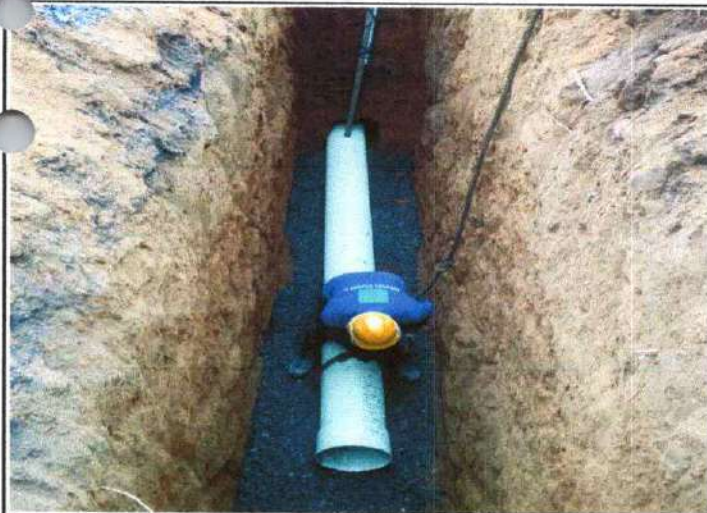
INSTALACION DE TUBERIA PARA ALCANTARILLADO SANITARIO DE 18" Y DE 10"
