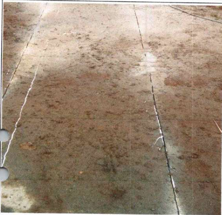
Corte de pavimento para domiciliarias sanitarias
