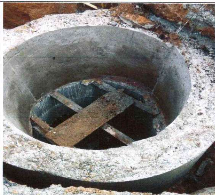
CONSTRUCCION DE CAMARAS EN CONCRETO DE 3000 PSI
