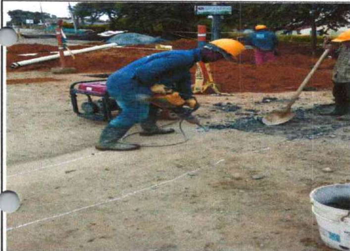
DEMOLICION DE PAVIMENTO HIDRAULICO
