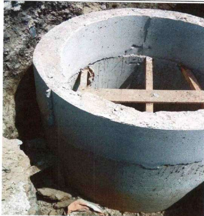
CONSTRUCCION DE CAMARAS EN CONCRETO DE 3000 PSI
