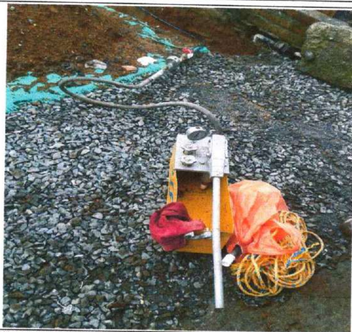
REALIZACION DE PRUEBA HIDROSTATICA RED DE ACUEDUCTO TRAMO I DESDE LA VARIANTE HASTA LA LICORERIA SAN DIEGO
