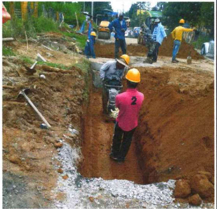
RELLENOS COMPACTADOS MATERIAL DE LIMO AMARILLO IMPORTADO
