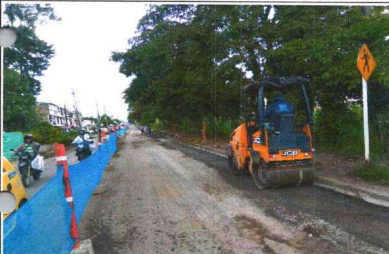
INSTALACION DE SUB BASE COMPACTADA
