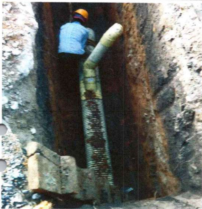
INSTALACION DE SILLA DE 12" X 6"
