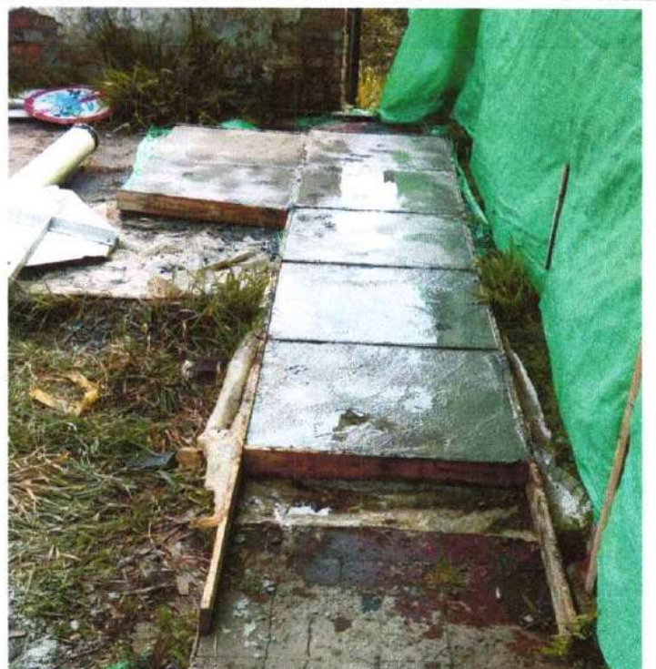
CONSTRUCCION DE TAPAS DE CONCRETO PARA CAJILLAS
