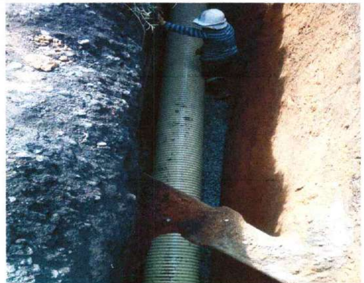
INSTALACION DE TUBERIA PARA ALCANTARILLADO SANITARIO DE 18"
