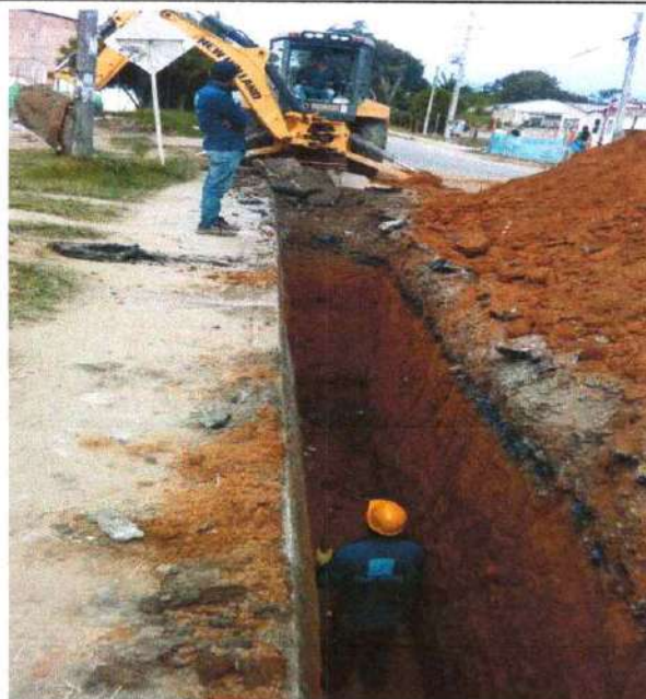
EXCAVACION A MAQUINA PARA RED PLUVIAL TRAMO I
