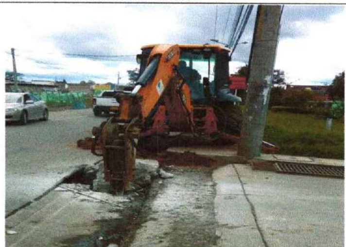
DEMOLICION DE PAVIMENTO HIDRAULICO
