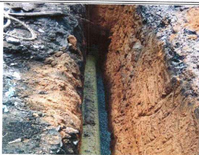
INSTALACION DE TUBERIA PARA ALCANTARILLADO SANITARIO DE 18"
