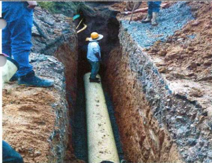
INSTALACION DE TUBERIA PARA ALCANTARILLADO SANITARIO DE 18"
