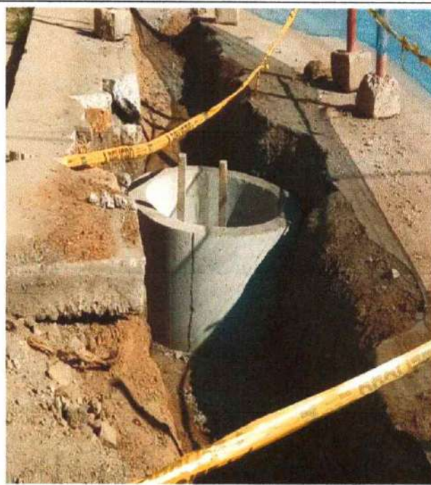
CONSTRUCCION DE CAMARAS EN CONCRETO DE 3000 PSI
