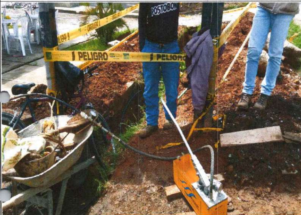
REALIZACION DE PRUEBA HIDROSTATICA RED DE ACUEDUCTO TRAMO I DESDE LA LICORERA SAN DIEGO HASTA LA PLACITA CAMPESINA
