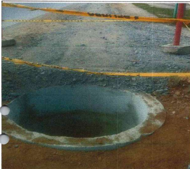
CONSTRUCCION DE CAMARAS EN CONCRETO DE 3000 PSI
