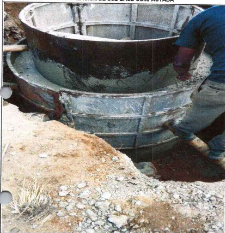
CONSTRUCCION DE CAMARAS EN CONCRETO DE 3000 PSI
