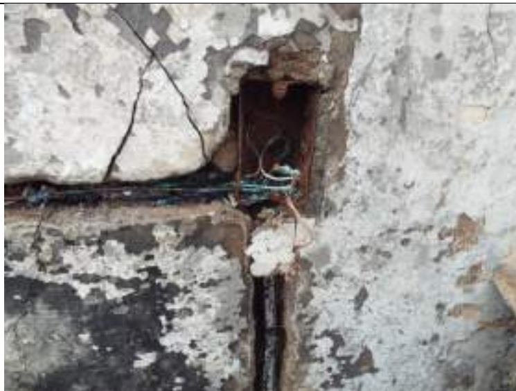
Ilustración 161 – Afectación al sistema eléctrico debido al incendio Todo a Mil - EDOC - 25/09/2020
