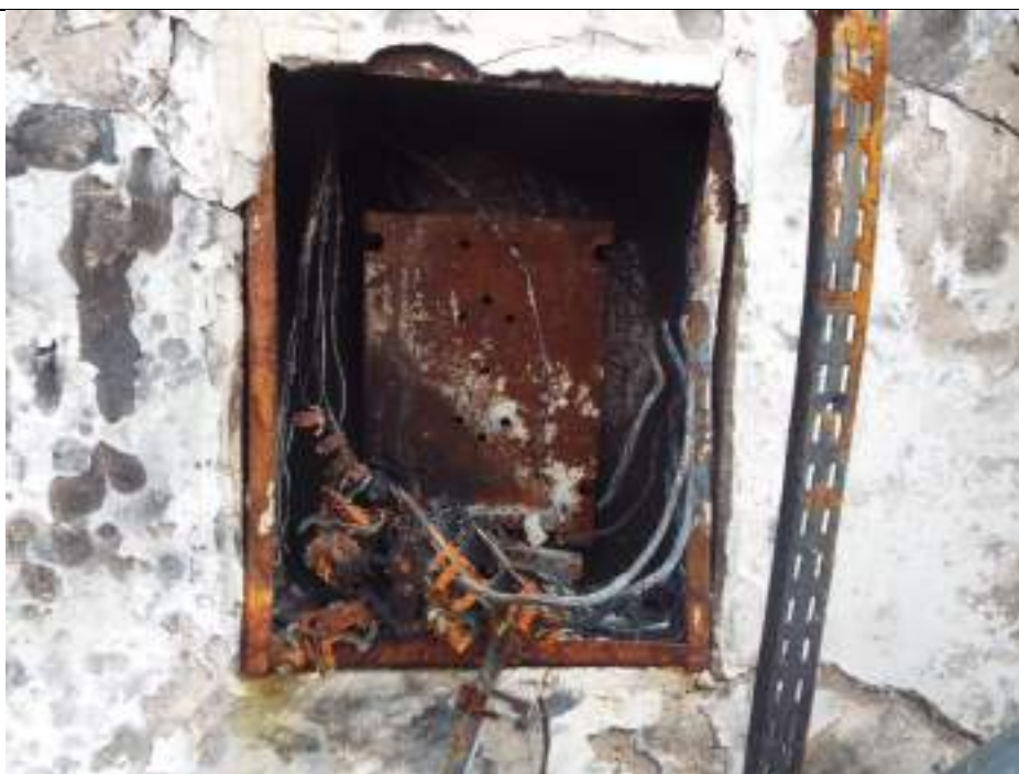
Ilustración 158 - Caja de tacos o disyuntores totalmente destruida por el incendio - BCBVF 108 - 05/08/2020
