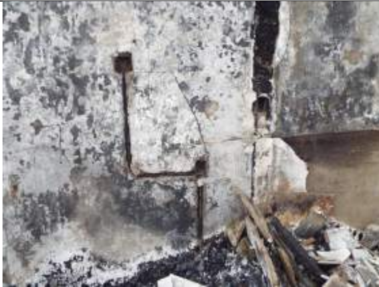
Ilustración 160 – Afectación al sistema eléctrico debido al incendio Todo a Mil - EDOC 110 - 25/09/2020
