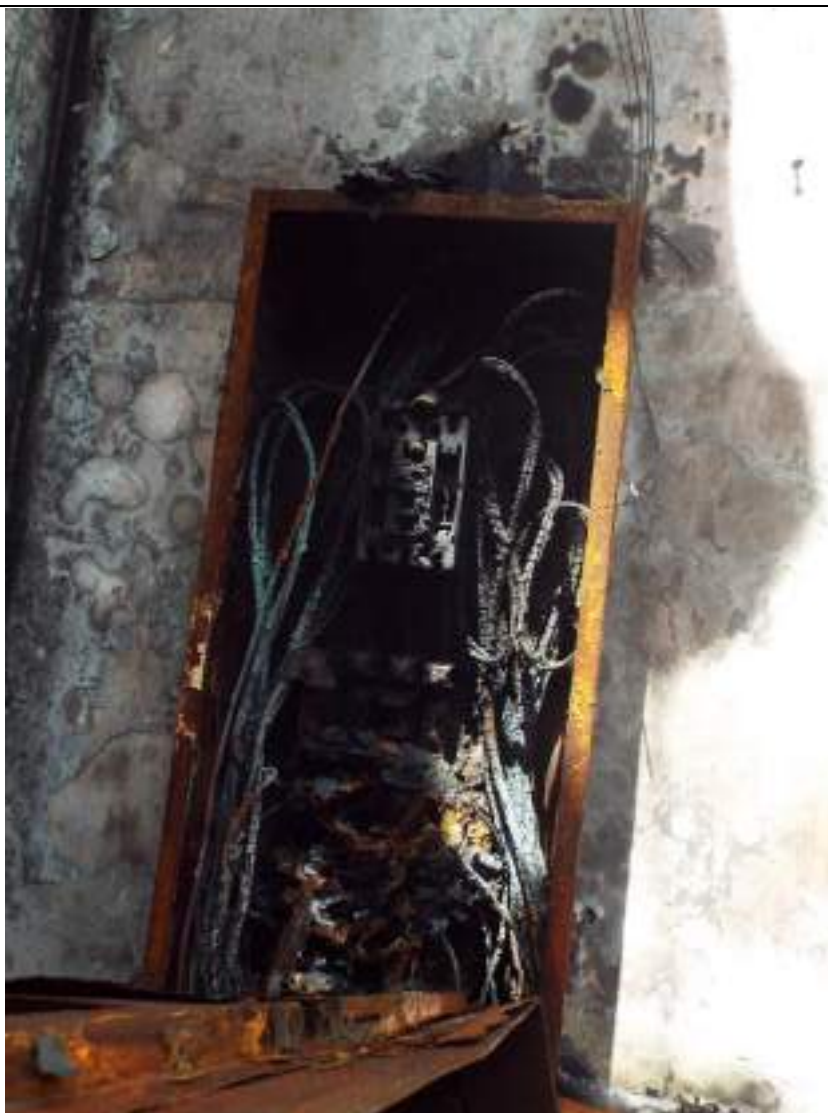
Ilustración 133 – Destrucción total de los tacos o disyuntores - EDOC 93 - 25/09/2020
