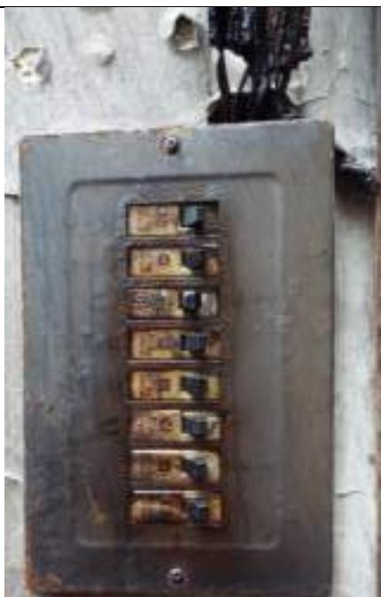
Ilustración 110 – Caja de tacos y posición y prácticas indebidas de la electrotecnia EDOC - 5/08/2020
