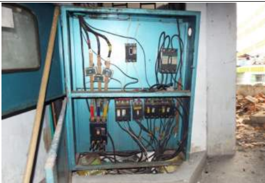
Ilustración 101 - Prácticas indevidas en la energía Eléctrica SERVAF SA ESP - EDOC - 5/08/2020
