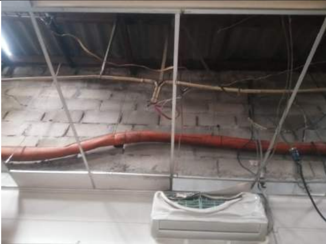
Ilustración 96 Sistema Eléctrico fuera de las tuberías de protección – Deficiencia en las instalaciones Electricas - SERVAF SA ESP – EDOC 60 - 5/08/202
