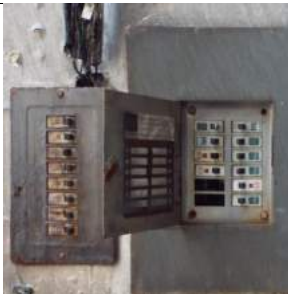
Ilustración 106 – Manipulación de la Caja de control eléctrico donde se aprecia fue retirado un taco o disyuntor - EDOC - 25/09/2020
