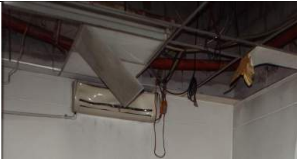
Ilustración 93 - Sistema Eléctrico fuera de las tuberías de protección – Deficiencia en las instalaciones Electricas - SERVAF SA ESP – EDOC 58 - 5/08/2020
