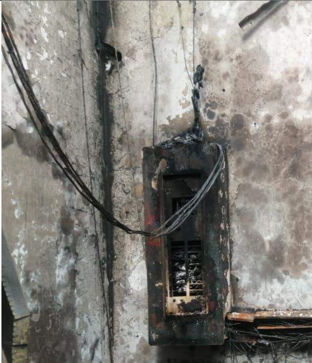
Ilustración 123 – Cables o conductores electricos que fueron retirados de la escena - BCBVF 83 - 16/05/2020
