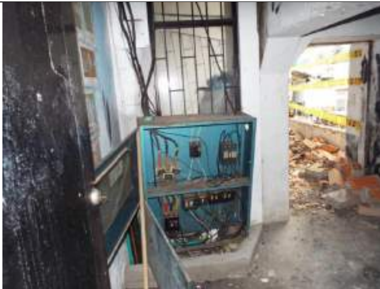
Ilustración 100 - Prácticas indevidas en la energía Eléctrica SERVAF SA ESP - EDOC 65 - 5/08/2020
