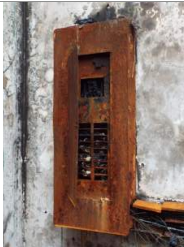
Ilustración 125 Ausencia de cables o conductores eléctricos que fueron retirados de la escena – Alteración de la escena - EDOC 05/08/2020
