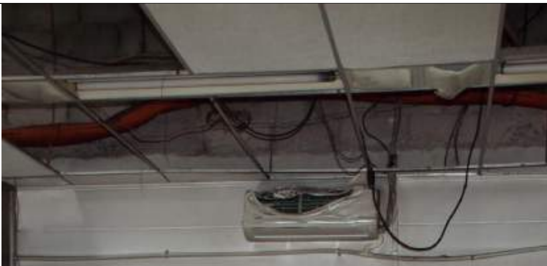
Ilustración 95 Sistema Eléctrico fuera de las tuberías de protección – Deficiencia en las instalaciones Electricas - SERVAF SA ESP – EDOC 59 - 5/08/202
