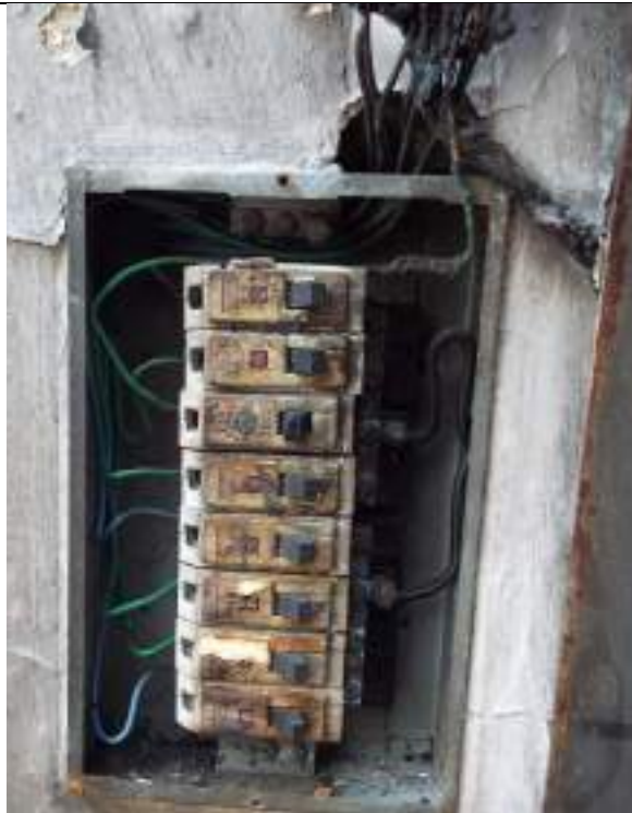
Ilustración 114 - Deficiencias en la instalación eléctrica - Prácticas indebidas de la electrotecnia EDOC 75 - 25/09/2020
