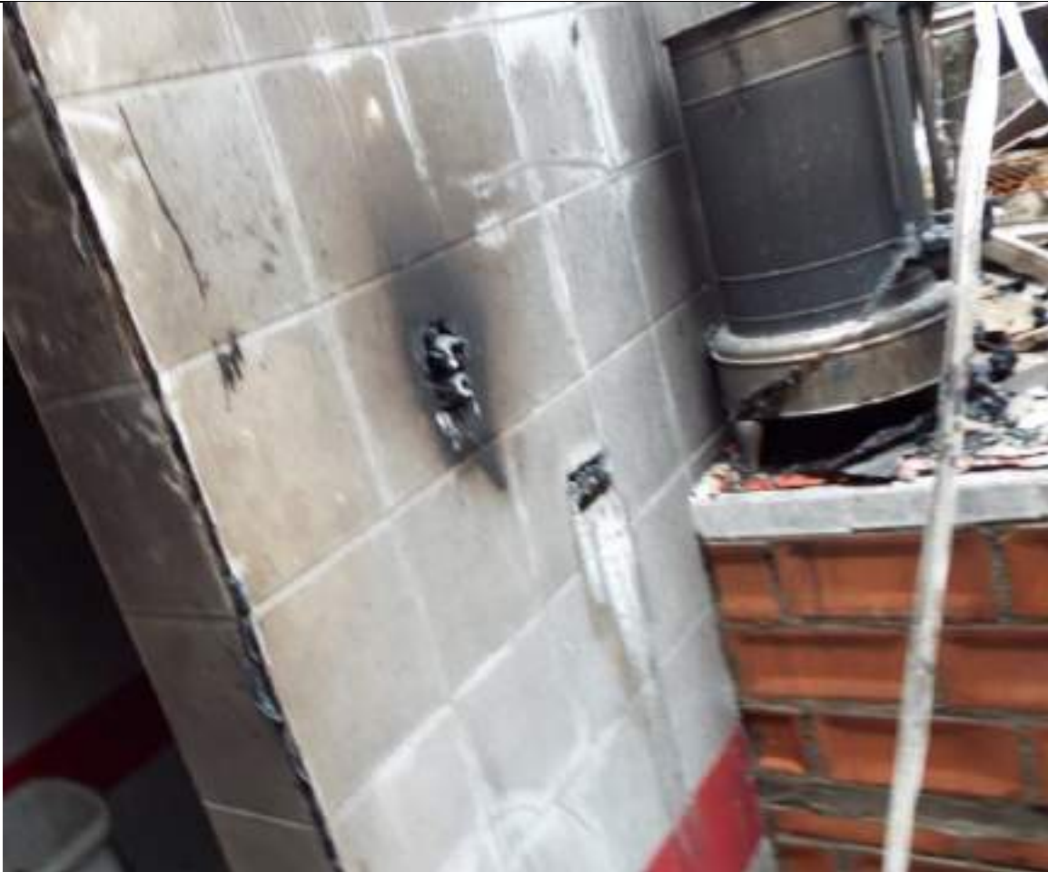
Ilustración 91 Foto de la greca que permite confirmar que no se encontraba energizada el día del incendio - EDOC 57 - 5/08/2020
