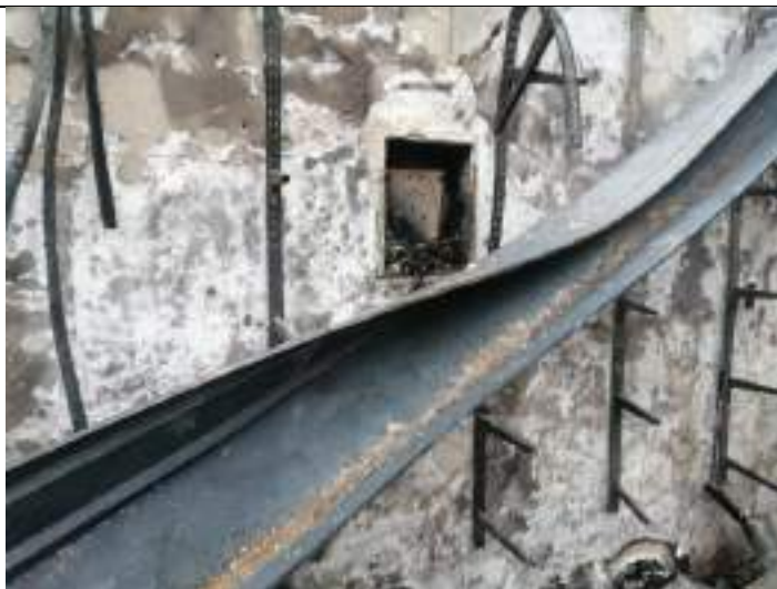
Ilustración 157 - Caja de tacos o disyuntores totalmente destruida por el incendio - EDOC 107 - 05/08/2020
