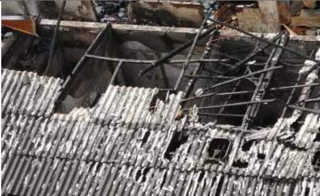
Ilustración 51 – Cubierta Zona mayor intensidad del fuego - BCBVF 32 - 16/06/2020 – Acercamiento EDOC 33
