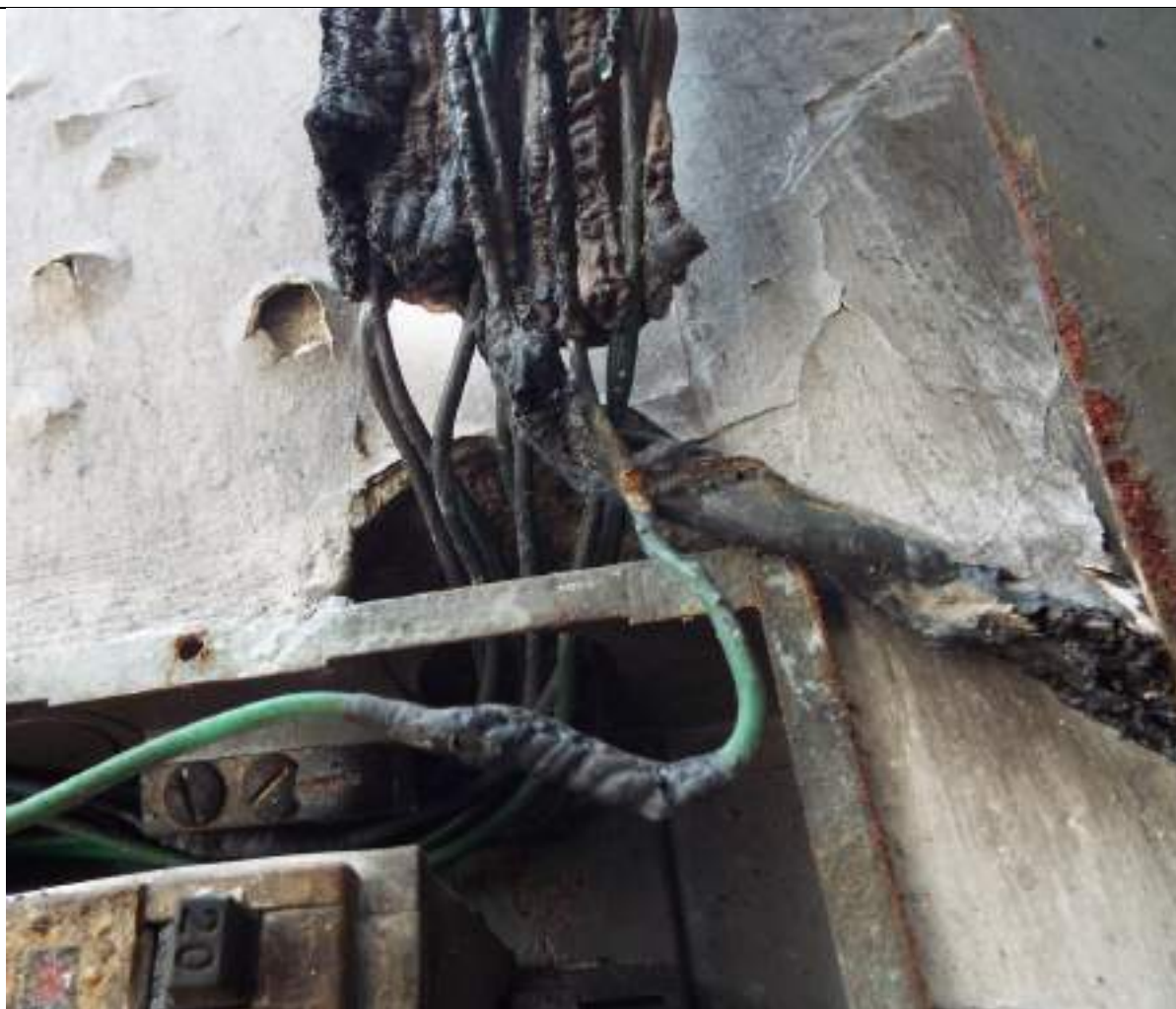
Ilustración 116 - Deficiencias en la instalación eléctrica - Prácticas indebidas de la electrotecnia EDOC 76 - 25/09/2020
