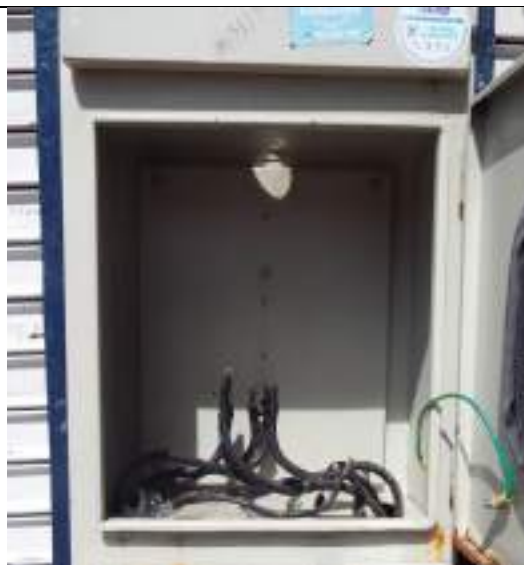
Ilustración 155 – Contador eléctrico retirado - EDOC - 25/09/2020
