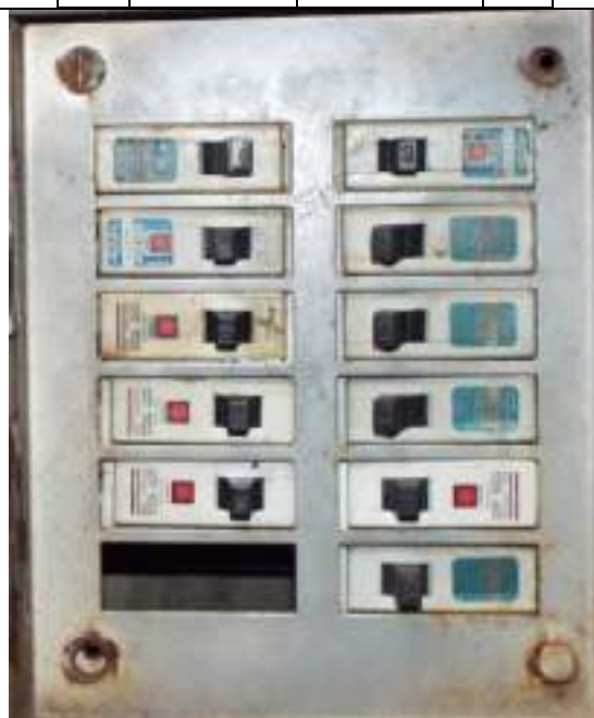
Ilustración 107 - Caja de control eléctrico con once (11) Tacos o disyuntores - EDOC 71 - 5/08/2020
