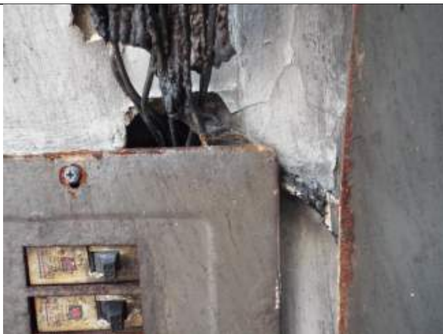
Ilustración 113 - Deficiencias en la instalación eléctrica - Prácticas indebidas de la electrotecnia EDOC - 25/09/2020
