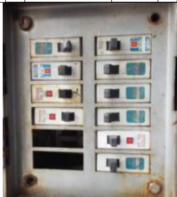
Ilustración 108 – Manipulación de la Caja de control eléctrico donde se aprecia fue retirado un taco o disyuntor - EDOC - 25/09/2020
