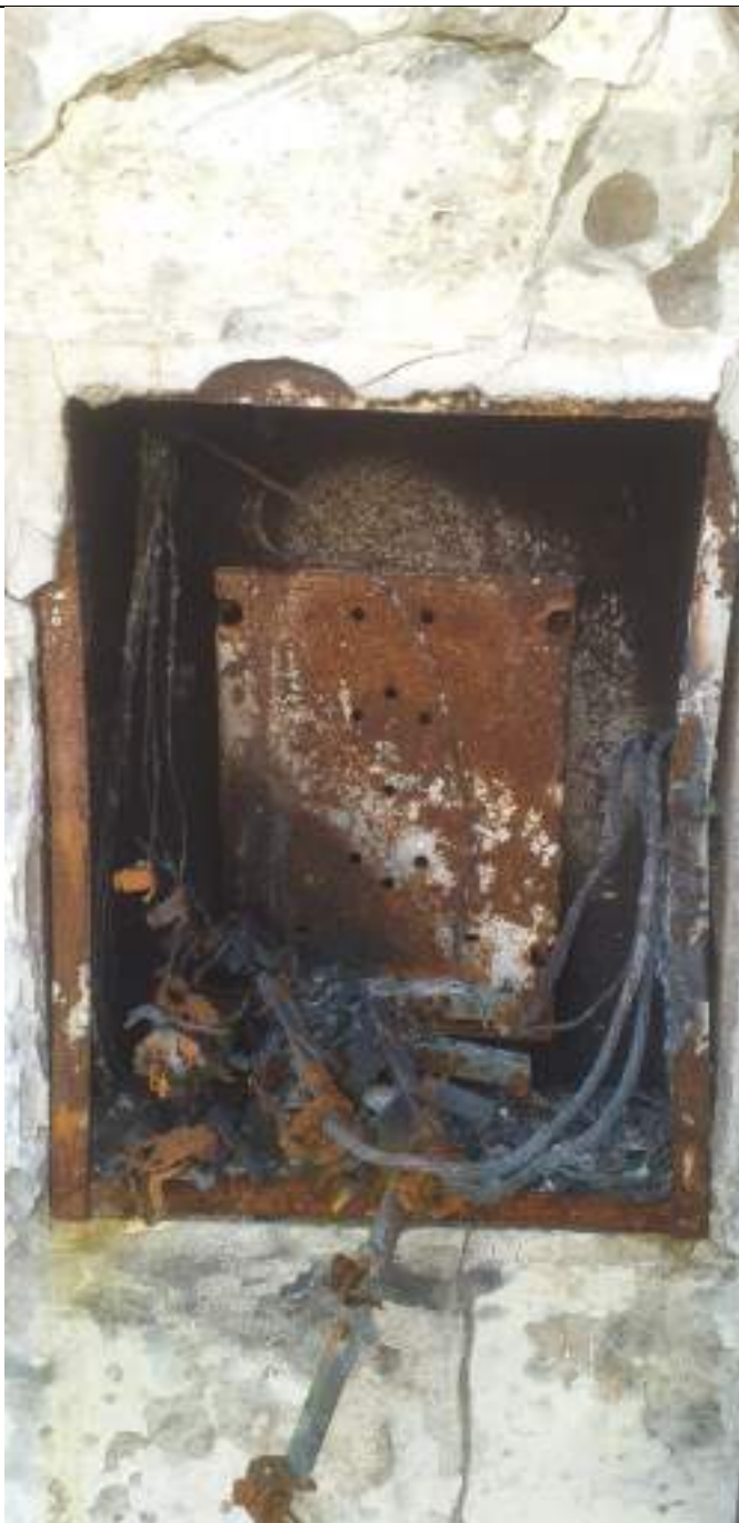
Ilustración 159 - Caja de tacos o disyuntores totalmente destruida por el incendio -EDOC 109 - 05/08/2020
