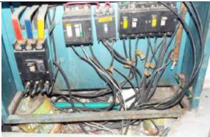
Ilustración 102 - Prácticas indevidas en la energía Eléctrica SERVAF SA ESP - EDOC 66 - 5/08/2020
