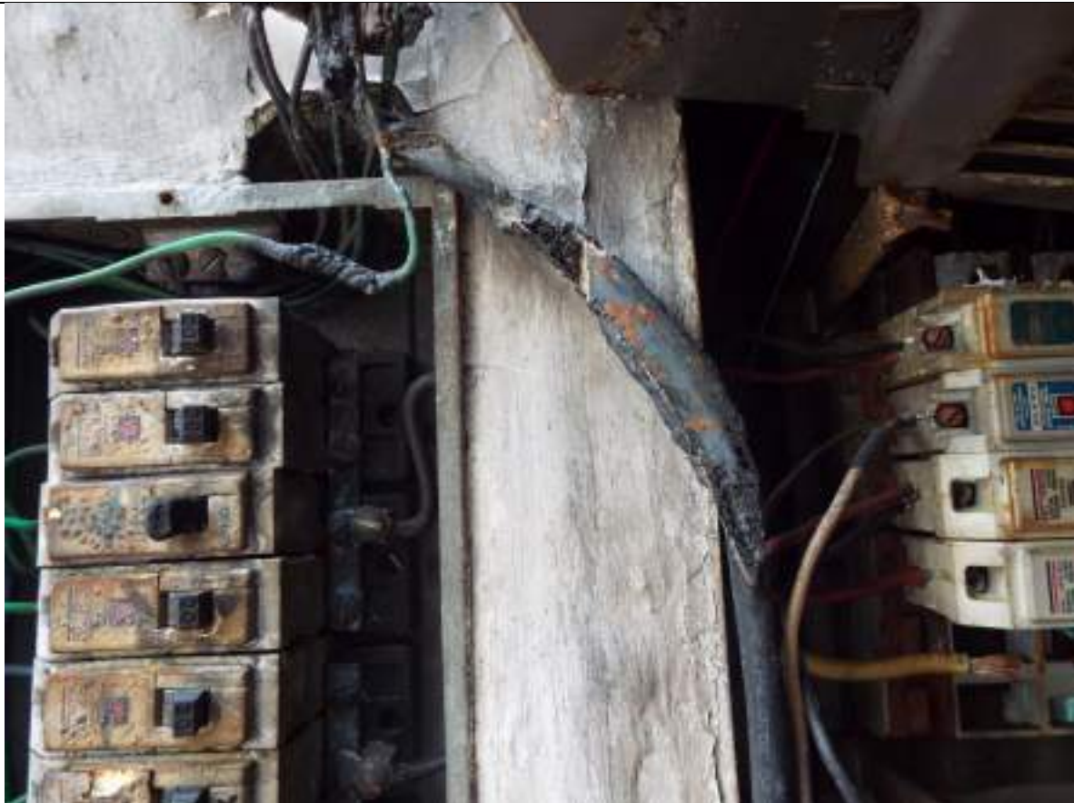
Ilustración 121 - Cables o conductores eléctricos que se encontraban aprisionados - EDOC 81 - 25/09/202
