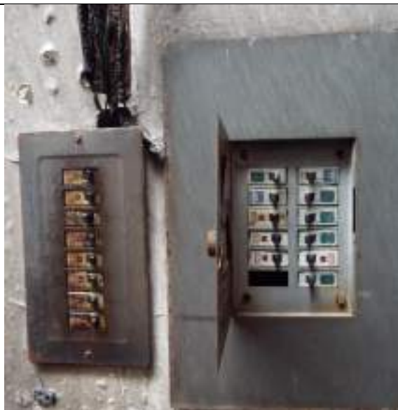
Ilustración 105 - Caja de control eléctrico con once (11) Tacos o disyuntores - EDOC 70 - 5/08/2020
