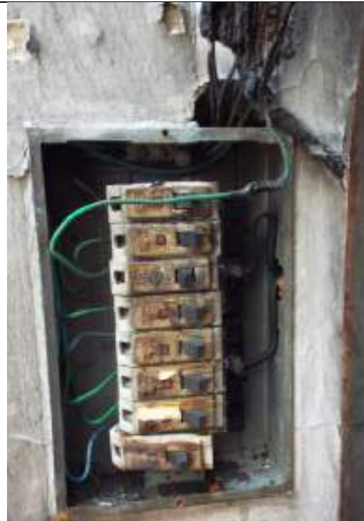
Ilustración 115 - Deficiencias en la instalación eléctrica - Prácticas indebidas de la electrotecnia EDOC - 25/09/2020
