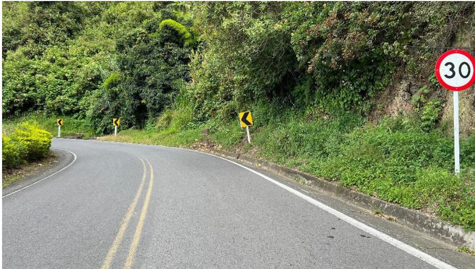
La imagen permite apreciar las características generales de la vía en el punto donde fue tomada, curva previa al lugar del evento de accidente de tránsito, incluyendo la demarcación horizontal, la presencia de una cuneta y la señalización vial.
