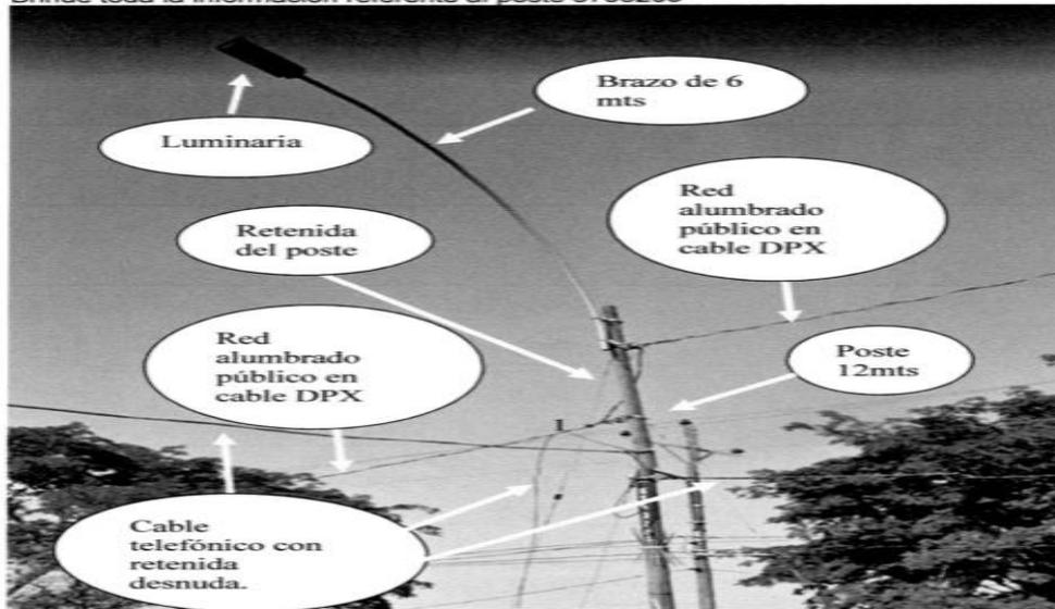
En la imagen se pueden observar las redes y diferentes componentes que tiene el poste instalado, entre ellas se encuentran redes telefónicas propiedad y responsabilidad de EMCALI EICE ESP y las redes de alumbrado público propiedad de MEGA SAS. Se aprecia en el número 1 en la imagen que la línea telefónica con su retenida desnuda, esta reventada y caída sobre la red de alumbrado público, sin que ello genere un daño en la prestación del servicio.
