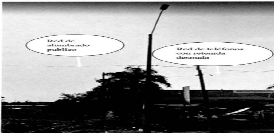
En la imagen 2 se observa la línea telefónica que pasa del poste con nodo 6793203 que se encuentra frente al Motel Rey de Corazones, hasta el otro lado de la vía panamericana a un poste telefónico. Dicha línea telefónica propiedad del operador EMCALI EICE ESP era la que se encontraba con la retenida desnuda, rota, caída y fue con la que tuvo contacto la yegua.
