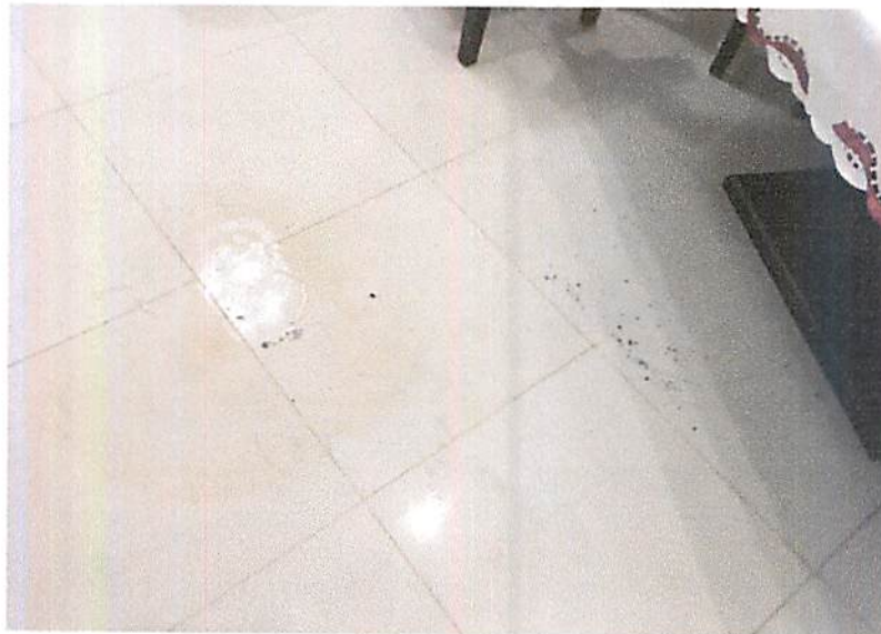
Manchas en los pisos Producto de las filtraciones
