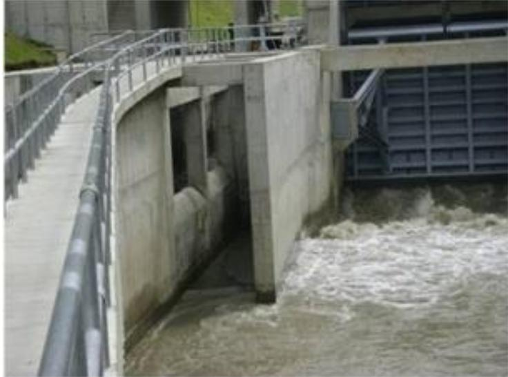
Vertedores de estas características sin un perfil hidrodinámico bien definido se calculan suponiendo un coeficiente de desagüe para condiciones de diseño de 1,85.
