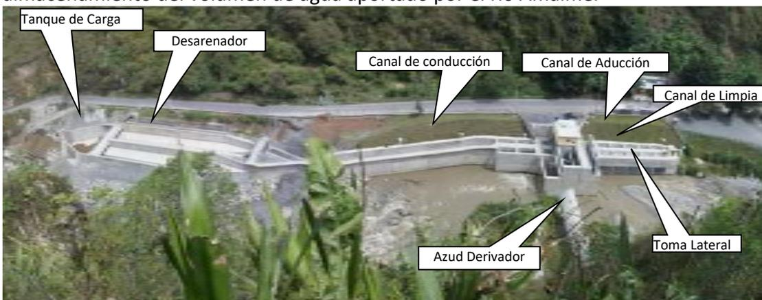
Las obras de captación constan de un azud derivador que eleva el nivel de agua lo suficiente para asegurar la derivación del caudal a turbinar. Este caudal se capta a través de una toma
