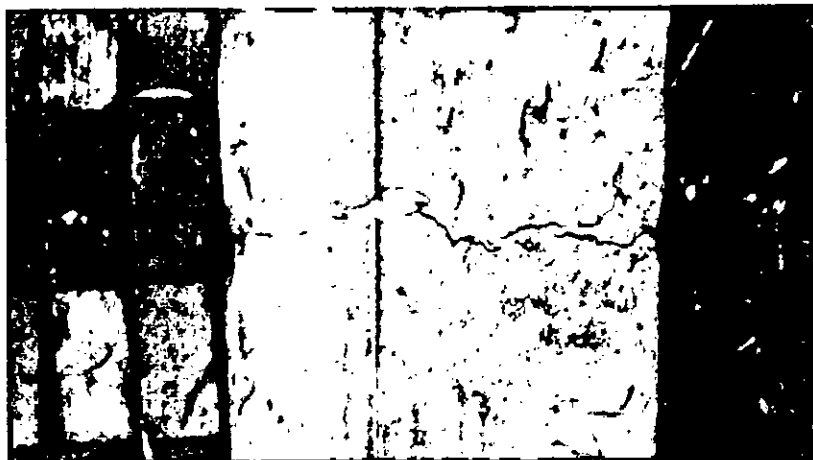
Figura 5. Agrietamiento del lecho de secado PTAR 1 Pance.
