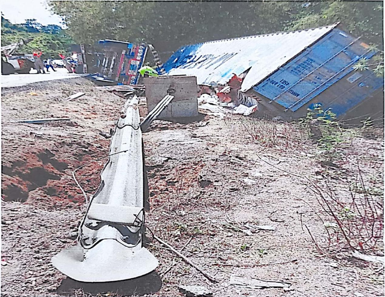
En esta imagen se observa la posición final de la parte posterior del vehículo siniestrado de placas SVD624, al igual que el tráiler de placas R73649 y el contenedor con parte de la mercancía salida, así mismo se observa los daños ocasionados a la vía en sus defensas metálicas, señales verticales, y en la caja, conducto y fibra óptica.
