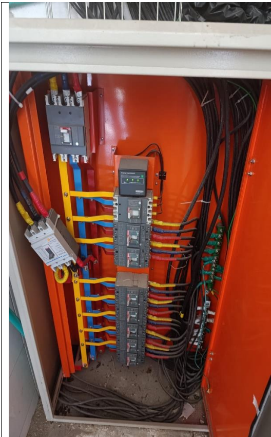
Ilustración 1: Tablero general red trifásica.
