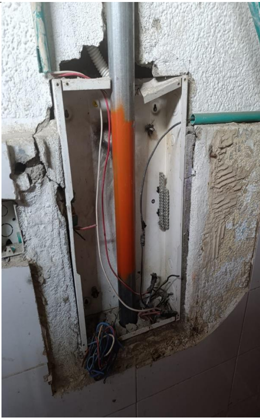
Ilustración 2: Evidencia de caleado expuesto sin sellamiento.
