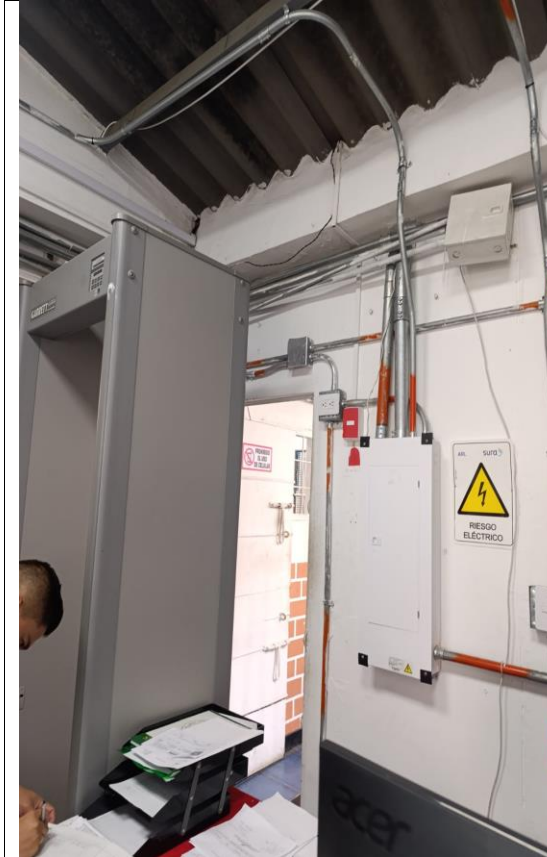
Ilustración 33: Falta de marcación de tomas de donde perteneces los circuitos.
