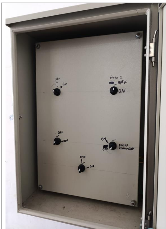
Ilustración 5: Caja de interruptores con mal marcado.
