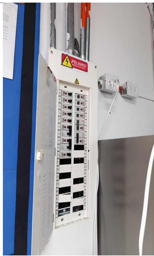
Ilustración 4: Tablero de distribución sin marcación adecuada, y sin sellamiento completo.
