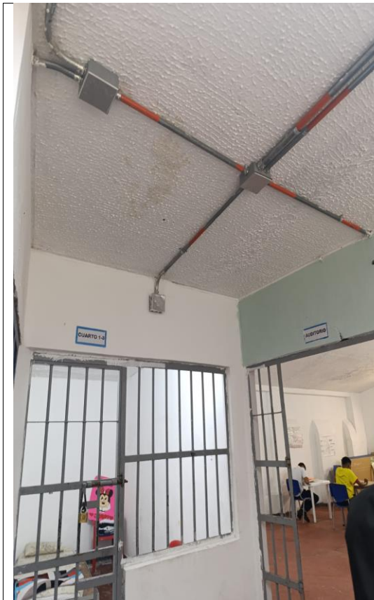
Ilustración 21: Marcación de tubería.
