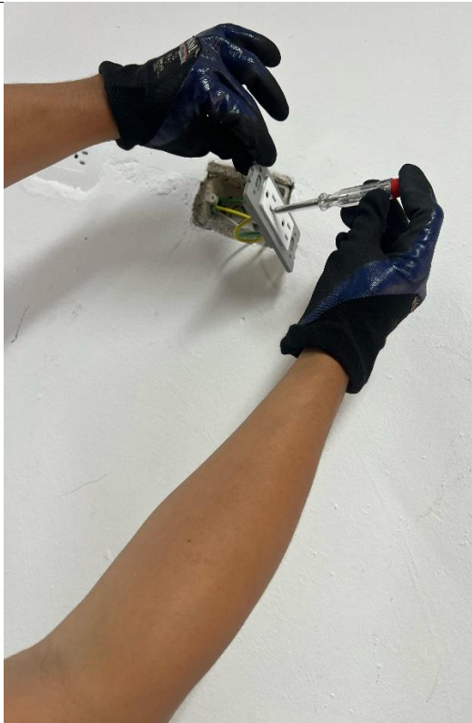
Ilustración 7: Verificación de correcta conexión y funcionamiento de tomas dobles.
