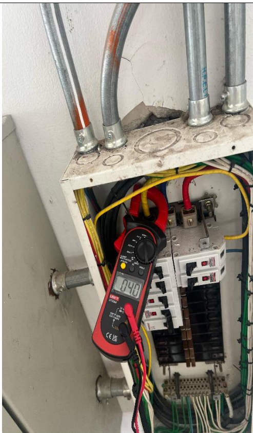
Ilustración 9: Medición de tableros.
