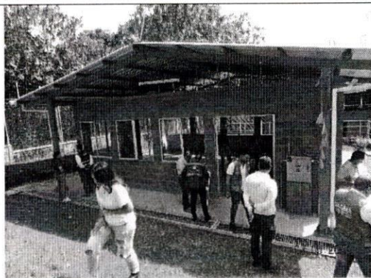
Construcción salón de reuniones. Explanación del terreno, zapatas en concreto reforzado, estructuras metálicas, cubierta metálica, instalaciones de ductería eléctrica; andenes en concreto, bajantes de aguas lluvias
