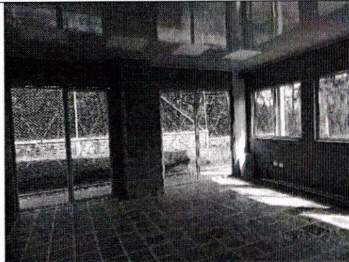
Salón de reuniones. Cielo en láminas de PVC, pisos en baldosas de gres.
