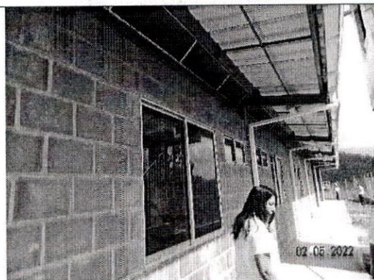
Cimientos en concreto reforzado, muros en mampostería, estructura metálica, cubierta en láminas metálicas, canales y bajantes en PVC, andenes perimetrales en concreto.
