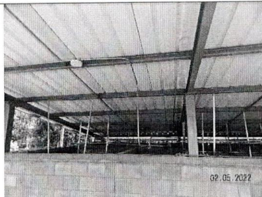
Salón DAGMA: Cubierta en lámina metálica, estructura de cubierta perlines metálicos, ductería eléctrica,
