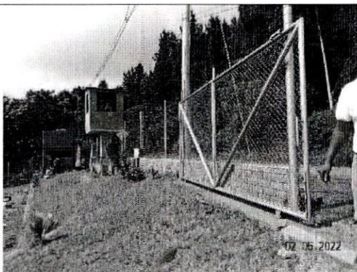
Construcción de cerramiento en mampostería sobre cimientos en concreto reforzado. Instalación de malla eslabonada y tubería galvanizada
