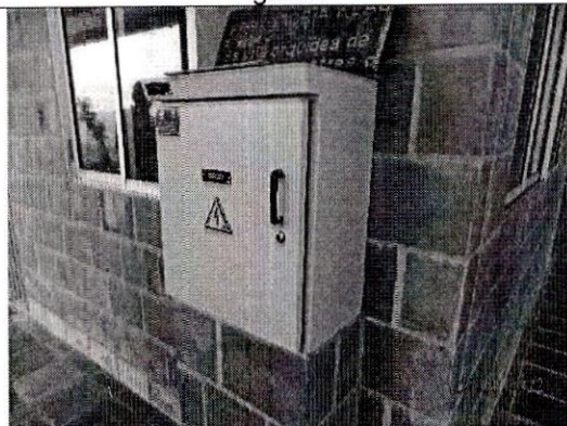
Instalación de tablero de circuitos eléctricos
