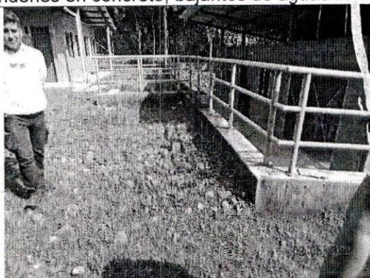
Salón DAGMA: Explanación del terreno, construcción de muros en concreto reforzado sobre pilotes en concreto reforzada, instalación de barandas metálicas
