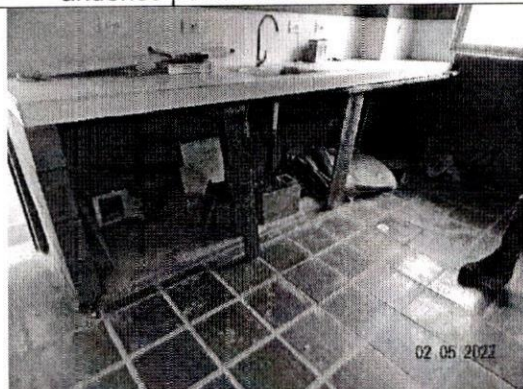
Construcción de mesón en granito, instalaciones hidráulicas y sanitarias, contrapiso en concreto, pisos en tablones de gress.
