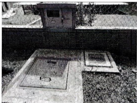
Cajas de inspección de la red hidráulica, caja del medidor de energía.
