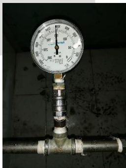
Imagen 3-4-5-6 Pruebas de presión en baños con resultados favorables piso 2.
