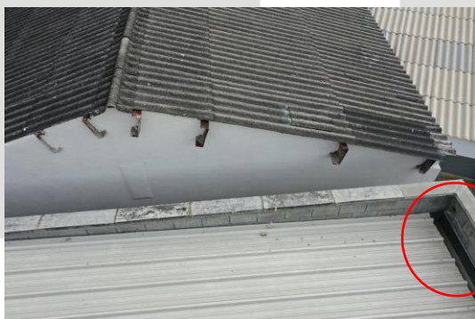
Imagen 5. Estado Actual Cubierta, Solapas y flanches, faltantes.
