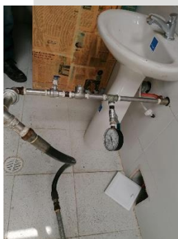
Imagen 3-4-5-6 Pruebas de presión en baños con resultados favorables piso 2.
