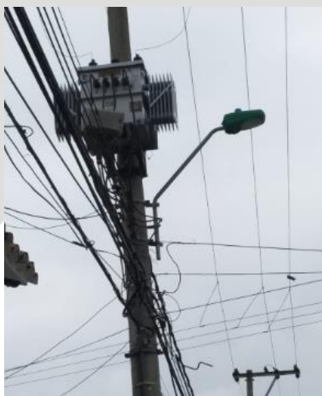
Figura 1. Transformador 150 KVA existente
