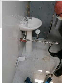
Imagen 3-4-5-6 Pruebas de presión en baños con resultados favorables piso 2.
