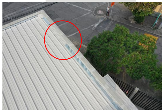
Imagen 4. Estado Actual Cubierta, Solapas y flanches, faltantes.
