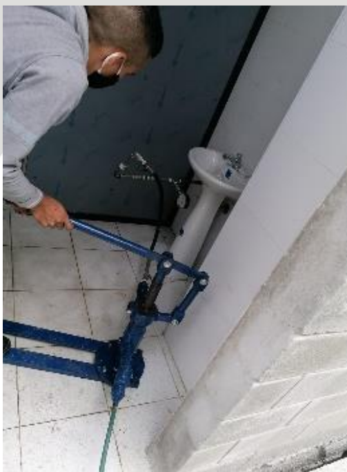
Imagen 7. Prueba hermeticidad Baños primer piso con fugas
