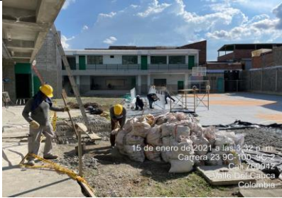
Descripción: DEMOLICIONES EN FOSO ELEVAPERSONAS - DESMONTE Y PINTURA DE BARANDAS.
