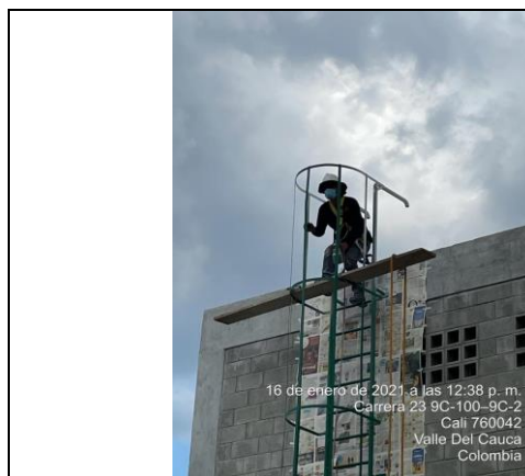
FOTO No 4 PINTURA ESCALERAS METÁLICAS EN ALTURAS
