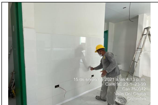
FOTO No 3 EMBOQUILLADO DE ENCHAPES EN COCINA
