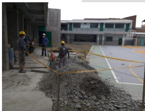
Ilustración 1 Demolición Pozo Ascensor
