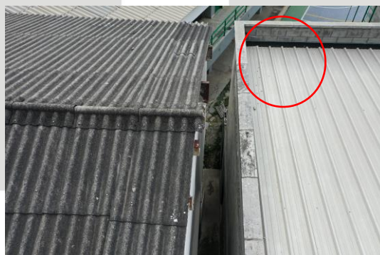
Imagen 6. Estado Actual Cubierta, Solapas y flanches, faltantes.
