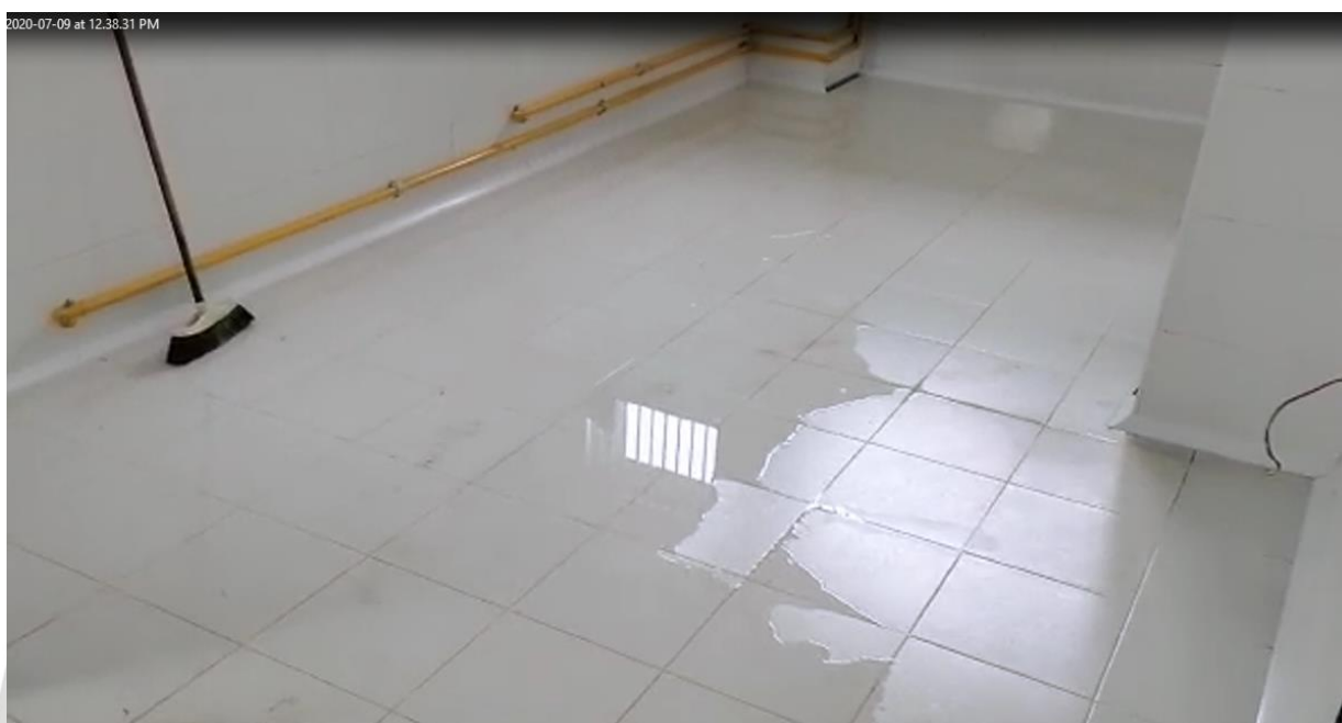
Imagen 8. Estanqueidad sector de la cocina, los cárcamos no hacen su función de desagüe manifestándose una lámina de agua de 2 cm aproximadamente.
