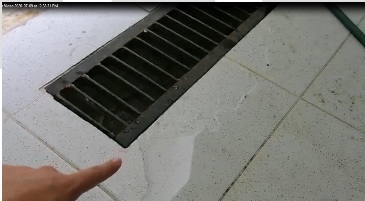
Imagen 9. Funcionamiento deficiente de Cárcamo zona posterior de Cocina
