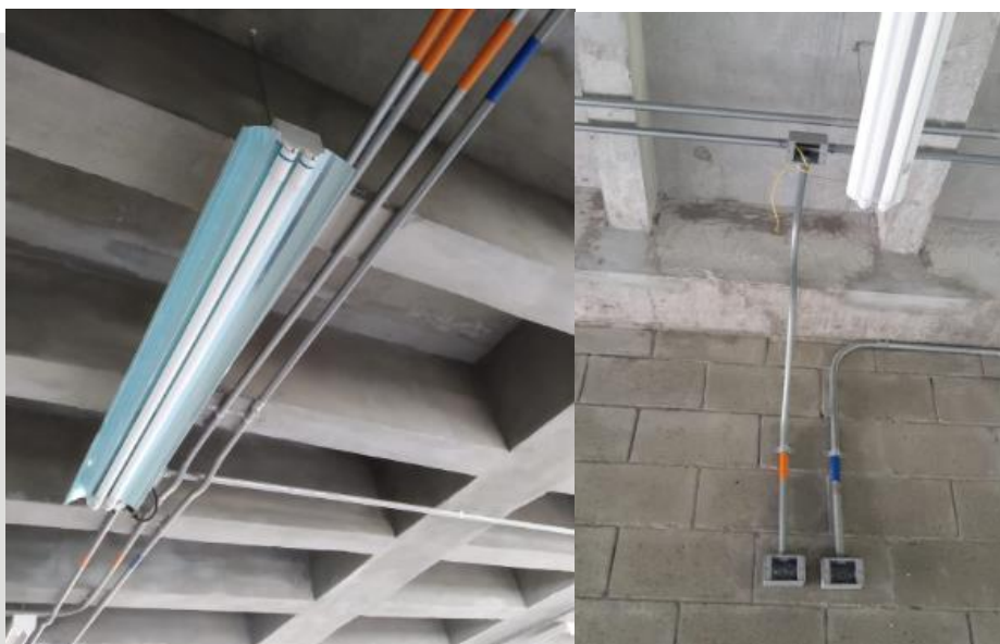
Figura 4 . Ausencia de cableado eléctrico y accesorios
