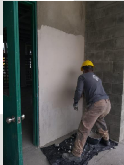
Ilustración 2 Pañete y estuco de Muros exteriores
