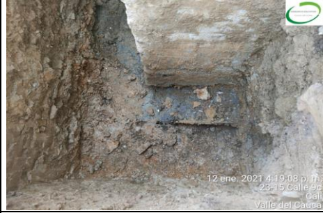
Descripción: DEFICIENCIAS EN CIMENTACIÓN EN PEDESTALES DE ESCALERA.
