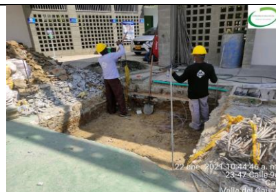
Descripción: DEMOLICIÓN DE FOSO DEL ELEVA PERSONAS.
