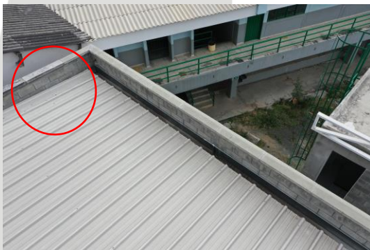
Imagen 3. Estado Actual Cubierta, Solapas y flanches, faltantes.
