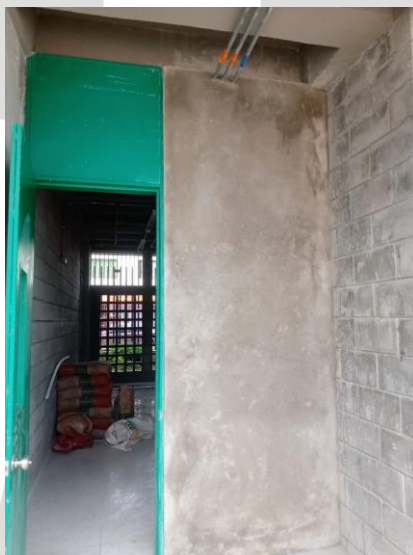
Ilustración 2 Pañete y estuco de Muros exteriores
