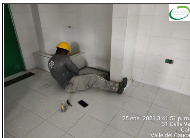
FOTO No 2 DESMONTE DE GUARDAESCOBA DE COCINA, NO CUMPLE NORMA SANITARIA.
