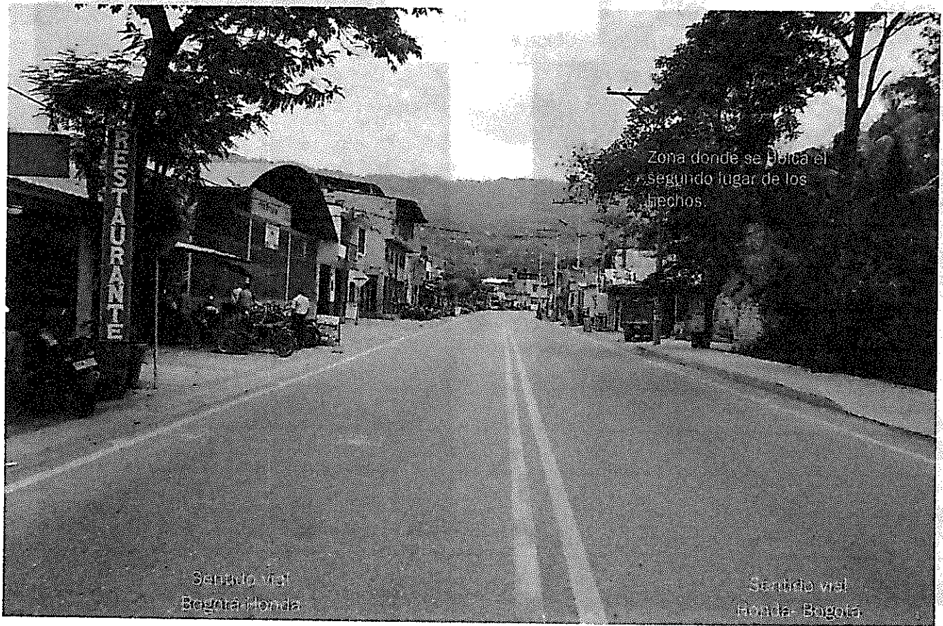
FOTOGRAFÍA No 7 Donde se observa la vía Honda-Bogotá, tramo de vía sentido vial Honda-Guaduas, observando el desplazamiento desde el sitio del accidente hasta llegar al segundo lugar de los hechos dónde se ubicó al vehículo tracto camión involucrado en el accidente de tránsito.
