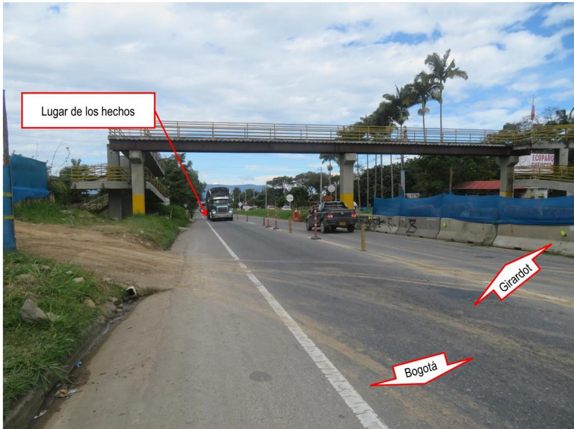
**Fotografía No.3 Plano General:** Fotografía tomada en sentido Bogotá Girardot km 60 + 200 m; donde se observan las características generales del tramo de vía, recta, plano, estado bueno, asfalto, doble sentido, en la cual se encuentra demarcación horizontal línea central segmentada y doble continua, líneas de borde blanca y amarillo.
