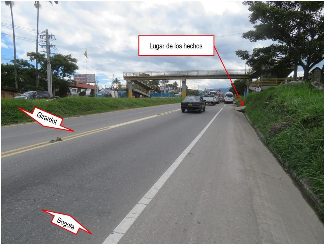
**Fotografía No.2 Plano General:** Fotografía tomada en sentido Girardot Bogotá km 60 + 200 m; donde se observan las características generales del tramo de vía, recta, plano, estado bueno, asfalto, doble sentido, en la cual se encuentra demarcación horizontal línea central segmentada y doble continua, líneas de borde blanca y amarillo. En este sentido se desplazaban los involucrados en los hechos.
