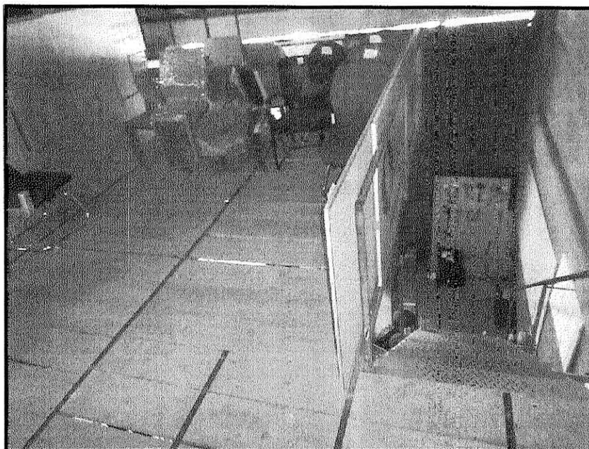
IMAGEN N°3 Ilustra al interior de la bodega las escaleras que dan acceso al mezanine, lugar de donde cayó la víctima del hecho; en el piso se aprecian platinas metálicas conque está asegurado el piso en tabla del mezanine.
