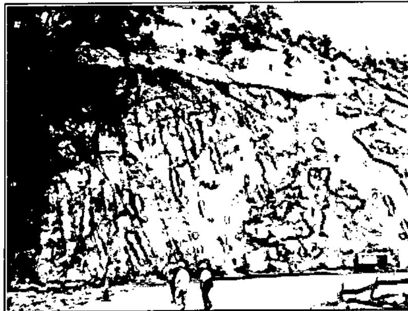
Fotografía 4. Tratamiento con malla y pernos de anclaje al inicio del tramo.
