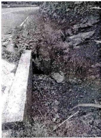
Fotografía No. 5. Caja recolectora obstruida con material
