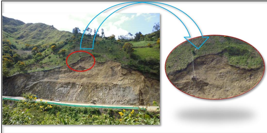
Fotografía 3. Tratamiento del talud. En el detalle se aprecia las obras del chaflán de corte.
