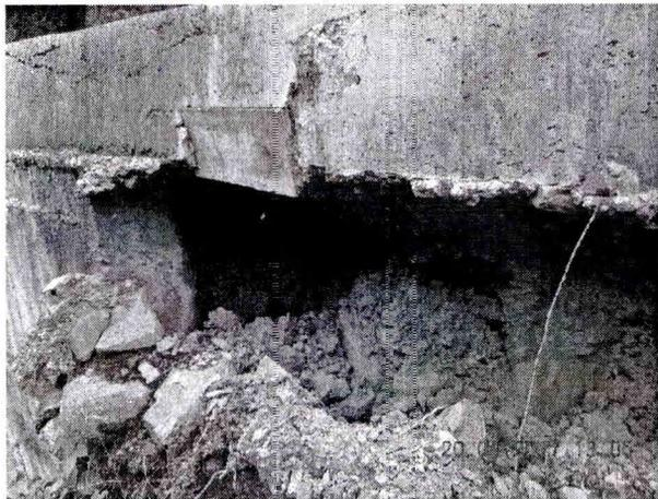
Fotografía No. 6. Saturación y Socavación material soporte de cuneta
