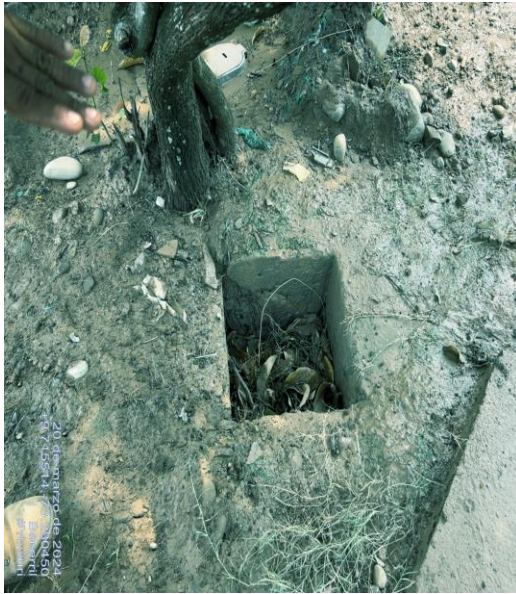
Foto 6 y 7. Cajas domiciliarias en mal estado y sin funcionamiento.
