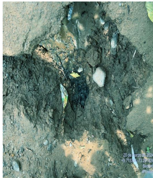
Foto 12 y 13. Muestran hundimiento y contaminación del terreno con aguas servidas provenientes de viviendas del sector.
