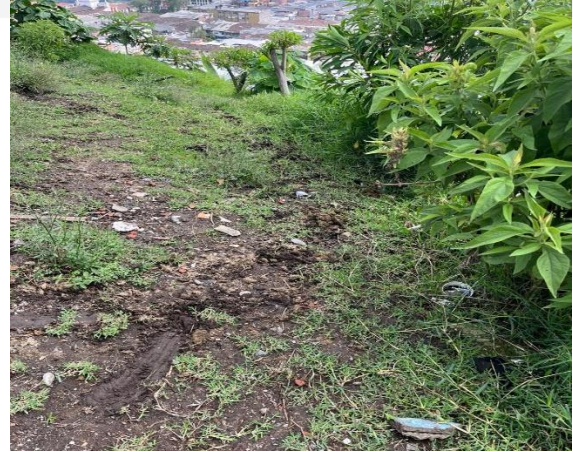
Foto 10. Las incidencias del caminar de los animales domésticos sobre el suelo desnudo en la corona del talud, es latente, que convierte la corona del talud en una zona de recarga.
