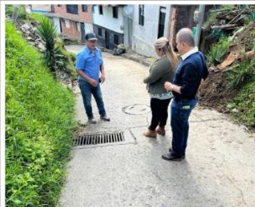
Foto 4. Vía calle 5C completamente pavimentada, con imbornales en perfecto estado.
