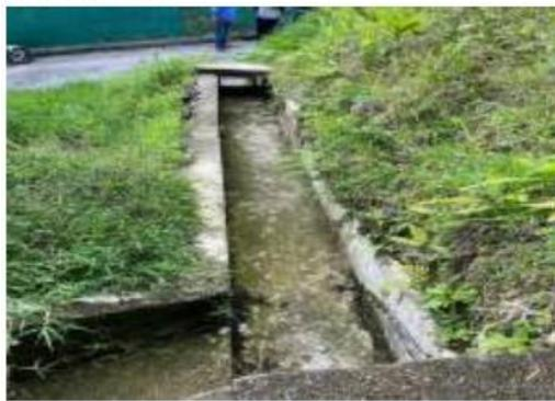
Foto 3. Entrega de las aguas del canal sobre la vía, calle 5C, que recibe a través del alcantarillado.
