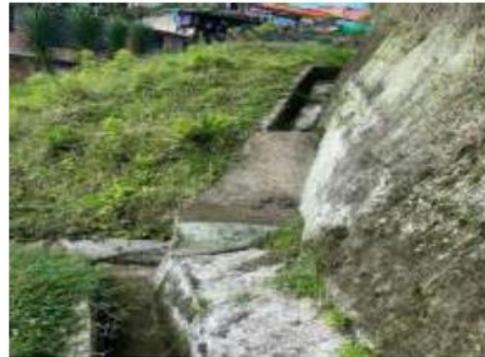
Foto 2. Talud estabilizado con pantalla en concreto, canal colector de aguas en su base.
