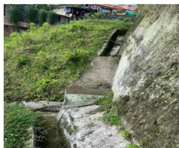
Foto 2. Talud estabilizado con pantalla en concreto, canal colector de aguas en su base.
