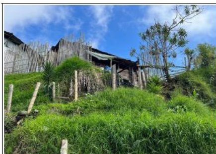
Foto 5. Parte superior del talud con existencia de construcciones habitadas.
