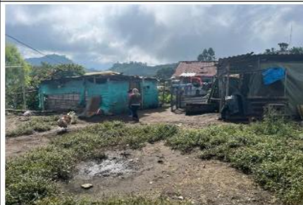
Foto 7. Terrenos de la corona del talud, contruidos y habitados, con patios descubiertos.
