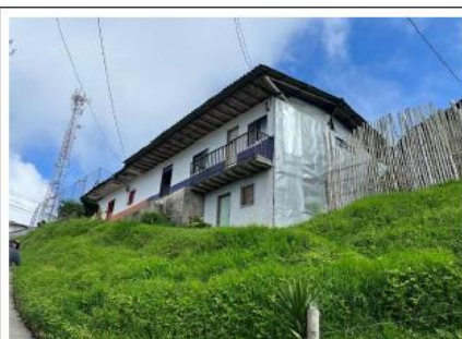
Foto 6. Parte superior del talud con construcciones tipo viviendas, habitadas.
