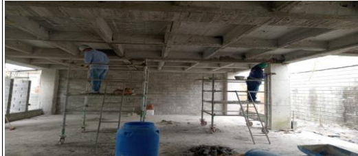
Capítulo: ESTRUCTURAS Ubicación: Bloque 2 Descripción: MAQUILLAJE PLACAS ENTREPISO
