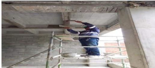
Capítulo: ESTRUCTURAS Ubicación: Bloque 2 Descripción: MAQUILLAJE PLACAS ENTREPISO
