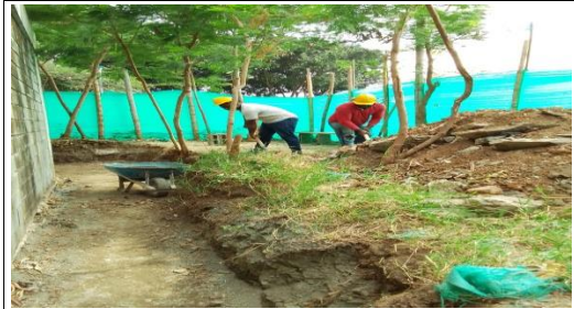
Capítulo: CIMENTACIÓN Ubicación: BLOQUE 1A Descripción: EXCAVACIÓN MANUAL EN MATERIAL COMÚN (incluye cargue, retiro y disposición final)
