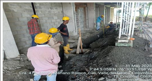
Capítulo: INSTALACIÓN HIDRAULICA Ubicación: Bloque 1A Descripción: EXCAVACION MANUAL EN MATERIAL COMUN
