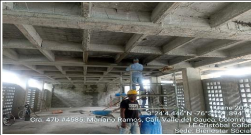
Capítulo: ESTRUCTURAS Ubicación: Bloque 2 Descripción: MAQUILLAJE PLACAS ENTREPISO
