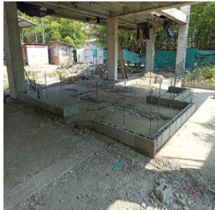
DOVELA EN CONCRETO GROUTING. INCLUYE ACERO DE REFUERZO
