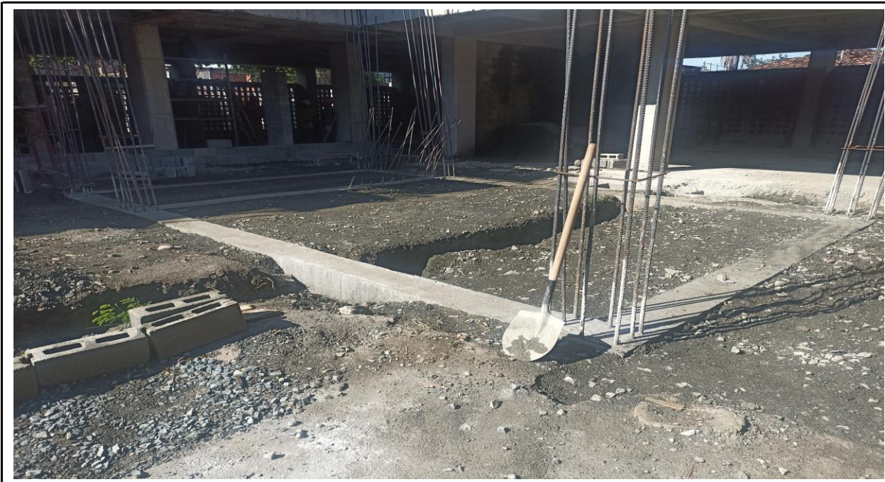
Capitulo: CONCRETOS PARA Ubicación: BLOQUE 2 Descripción: CONCRETO PARA VIGAS DE CIMENTACIÓN 3000 PSI
