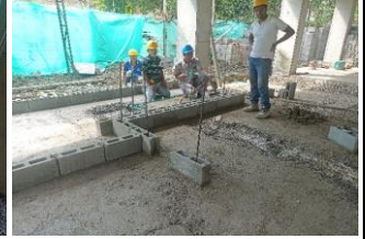
ANCLAJE PARA REFORZAMIENTO EN CONCRETO Y EPOXICO PARA Ø 1/2" (PERFORACIÓN - LIMPIEZA - EPÓXICO)
