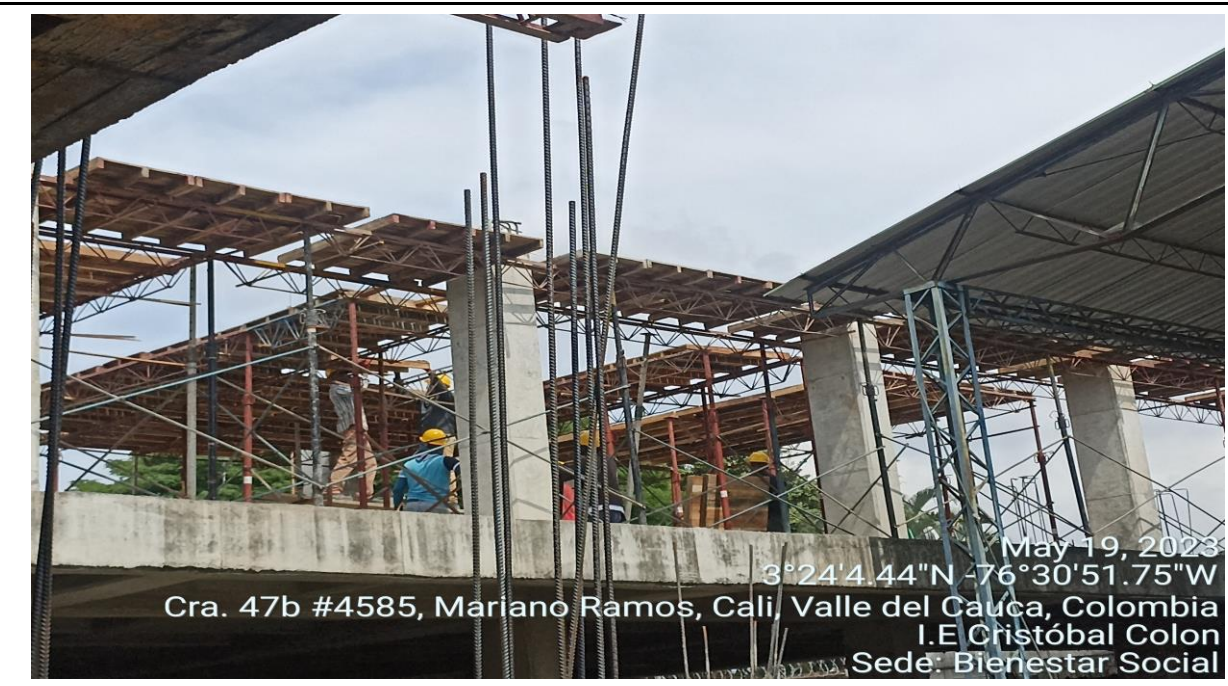
Capitulo: ESTRUCTURAS Ubicación: BLOQUE 1B Descripción: INSTALACION DE FORMALETA PARA VIGAS Y LOSA
