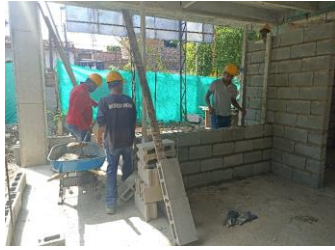
MURO EN BLOQUE CONCRETO - E = 10 cm
