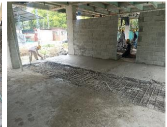
PLACA CONTRAPISO DE 10 cm - CONCRETO 3000 PSI. INCLUYE CORTE Y DILATACION
