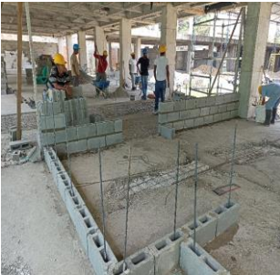
MURO EN BLOQUE CONCRETO - E = 10 cm
