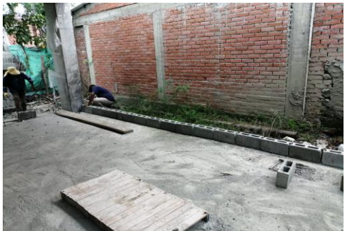
Replanteo de muros estructurales
