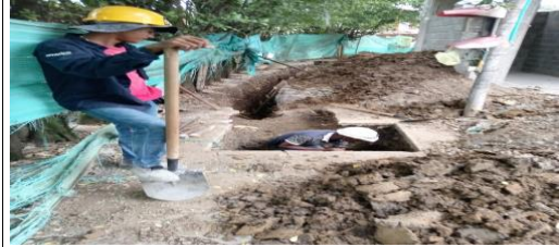
Capítulo: CIMENTACIÓN Ubicación: Bloque 2 Descripción: EXCAVACIÓN MANUAL EN MATERIAL COMÚN (incluye cargue, retiro y disposición final)
