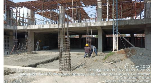
Capítulo: ACERO DE REFUERZO PARA Ubicación: Bloque 2 Descripción: ACERO DE REFUERZO 60000 PSI
