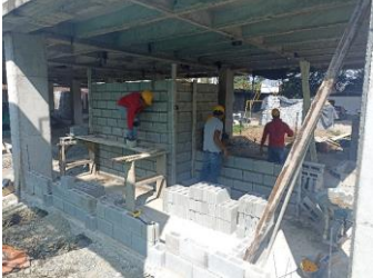
MURO EN BLOQUE CONCRETO - E = 10 cm
