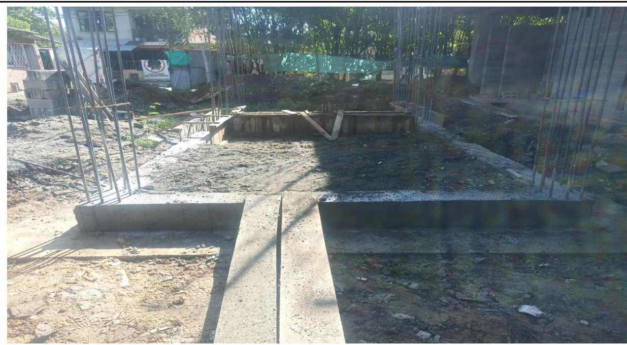
Capitulo: CONCRETOS PARA CIMENTACION Ubicación: BLOQUE 2 Descripción: CONCRETO PARA VIGAS DE CIMENTACIÓN 3000 PSI
