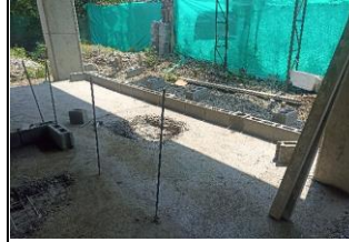
ANCLAJE PARA REFORZAMIENTO EN CONCRETO Y EPOXICO PARA Ø 1/2" (PERFORACIÓN - LIMPIEZA - EPÓXICO)
