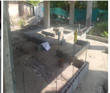
PLACA CONTRAPISO DE 10 cm - CONCRETO 3000 PSI. INCLUYE CORTE Y DILATACION
