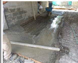
PLACA CONTRAPISO DE 10 cm - CONCRETO 3000 PSI. INCLUYE CORTE Y DILATACION
