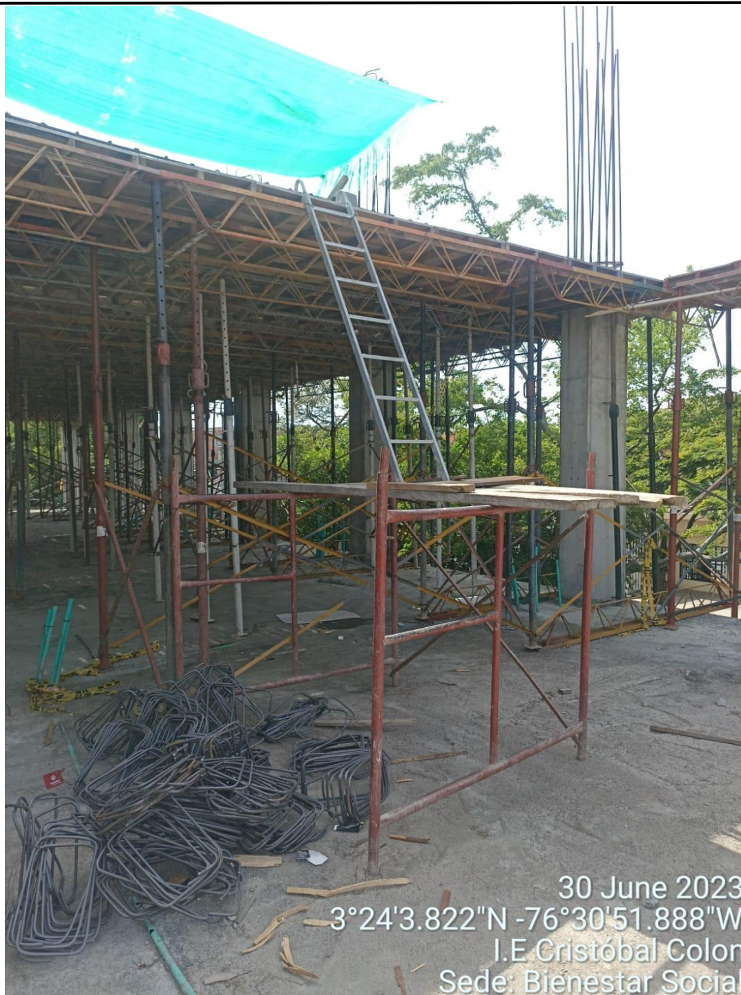
Acceso vertical inseguro sin parales laterales y salida al vacío
