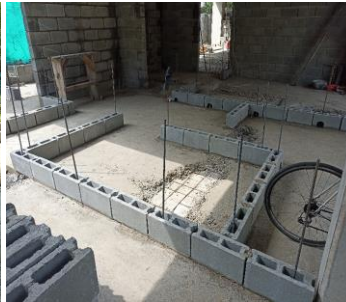
DOVELA EN CONCRETO GROUTING. INCLUYE ACERO DE REFUERZO
