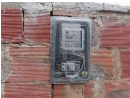
Medidor trifilar y caja de circuitos
