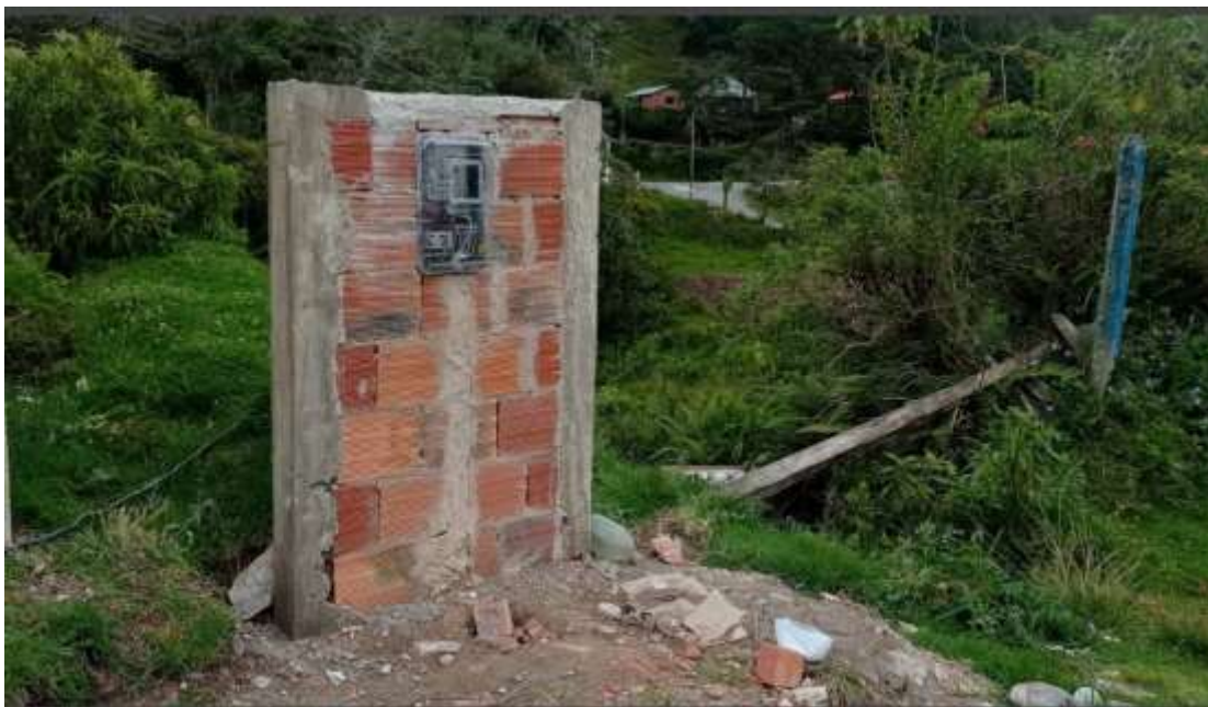
El medido esta ubicado en el mismo terreno sobre la carrera 5.
