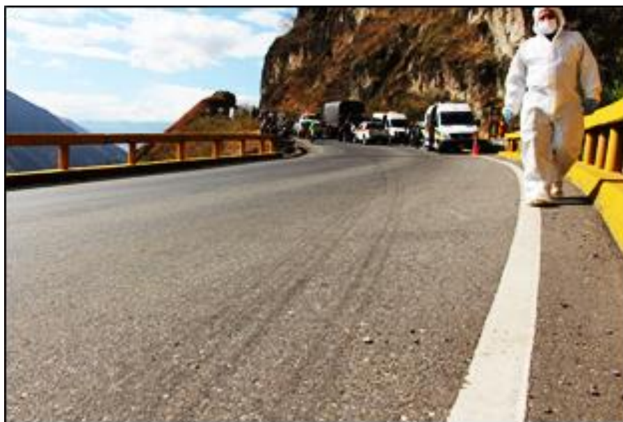
IMAGEN 04 PLANO MEDIO: En esta fotografía tomada en sentido vial Mojarras hacia Pasto se aprecia con más claridad las huellas dejadas por el vehículo bus en carril izquierdo en sentido vial Pasto hacia Mojarras.
