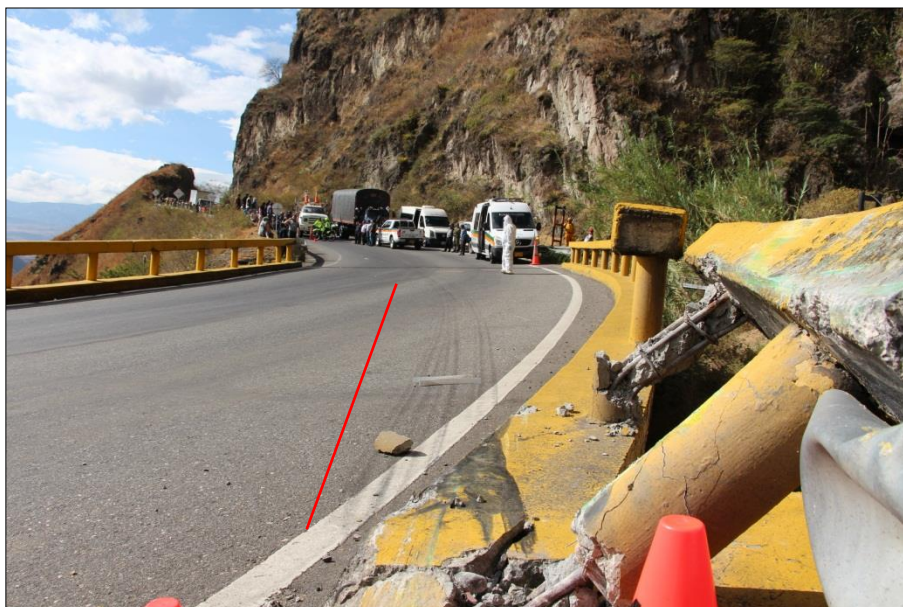
IMAGEN 03 PLANO MEDIO: En esta fotografía tomada en sentido vial Mojarras hacia Pasto se aprecia el primer punto de impacto dejado y las huellas de trayectoria como lo indica la línea de color rojo y que son dejadas por el vehículo tipo bus antes del siniestro.
