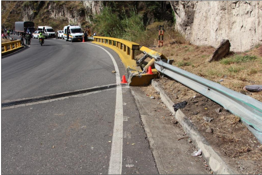
IMAGEN 07 PLANO MEDIO: En esta fotografía tomada en sentido vial Mojarras hacia Pasto se parecía al costado derecho de la imagen los daños ocasionados al muro de contención y baranda de protección metálica dejados por el bus.
