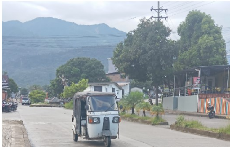
Foto No. 14- losas contorno glorieta sin afectación de pulimento (PU).
