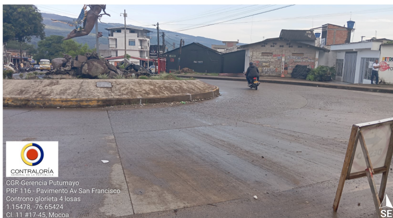
Foto No. 9 –losas No. 4-5 Y 6 K0+113.2 a K120,9 – Contorno Glorieta
