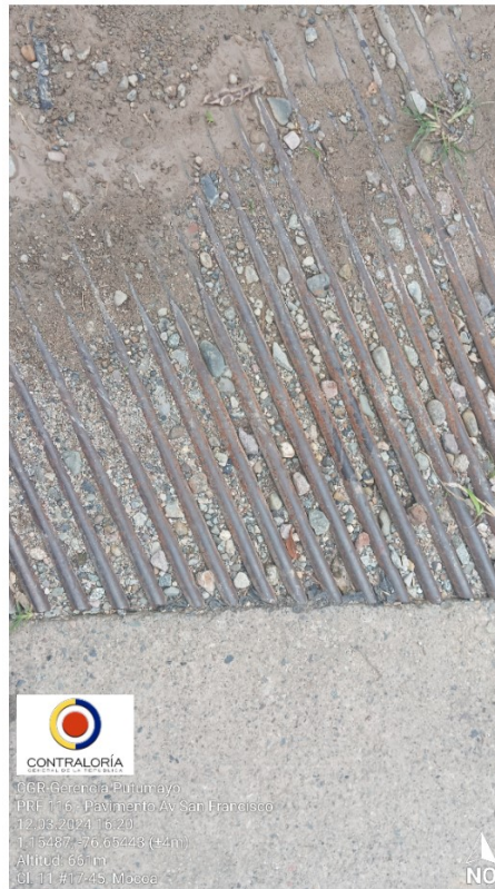
Foto No. 13 – taponamiento de los sumideros.
