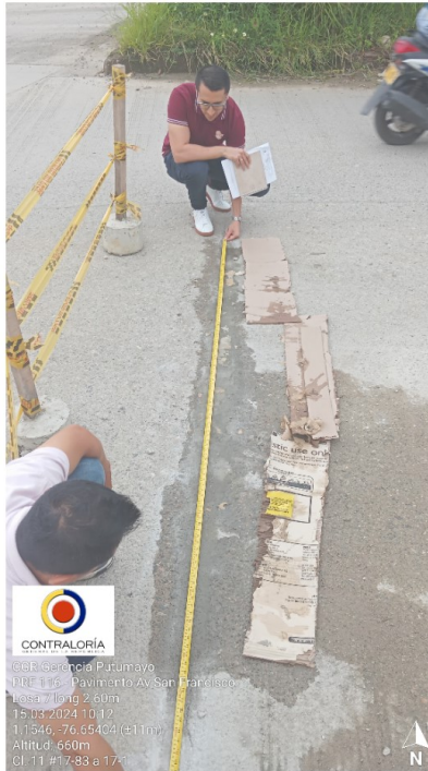
Foto No. 5 – Fisura losa No. 7- K0+148,2 – Reparada con Mapegrout Hi-E- Mortero en Polvo
