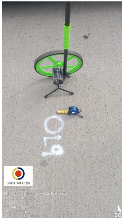
Foto No. 7 – Fisura losa No. 9- K0+195,00 – sellada con SikaFlex 401 Pavement SL- Sellador Elástico
