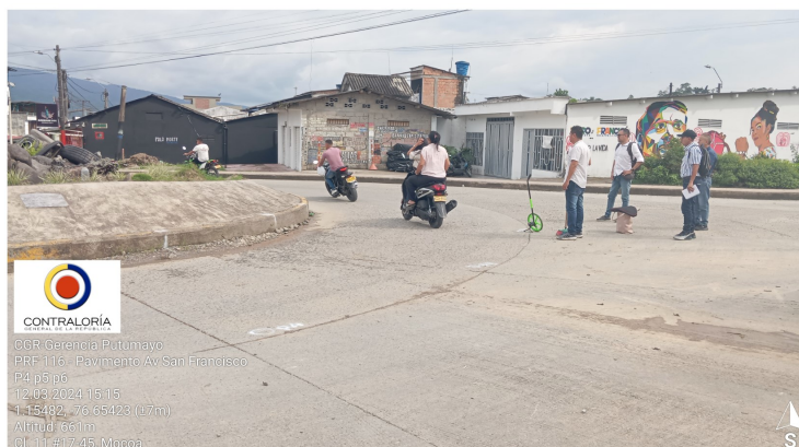
Foto No. 8 –losa No. 4-5 Y 6 K0+113.2 – a K120,9 – Contorno Glorieta
