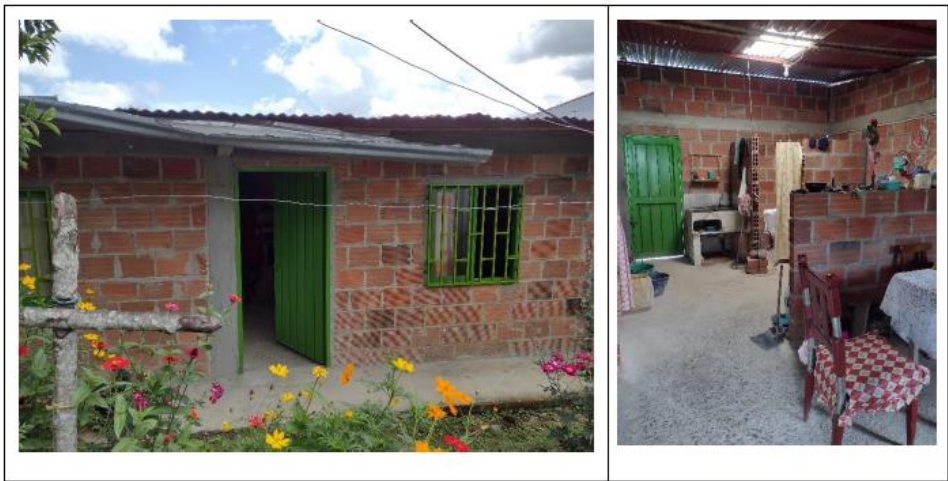
Predio de la Señora Martha Fernández, al cual ya se le adicionó un segundo piso.
