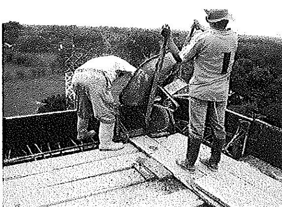
FUNDIDA MUROS TANQUE DE ALMACENAMIENTO
