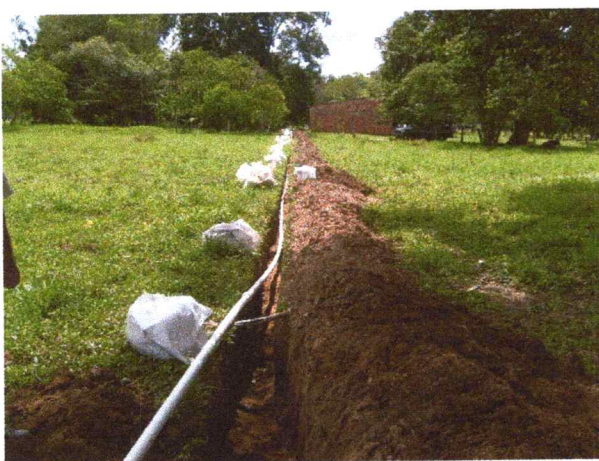
Imagen 07. Detalle etapa de tendido de tubería redes de distribución, Vereda Agualinda.
