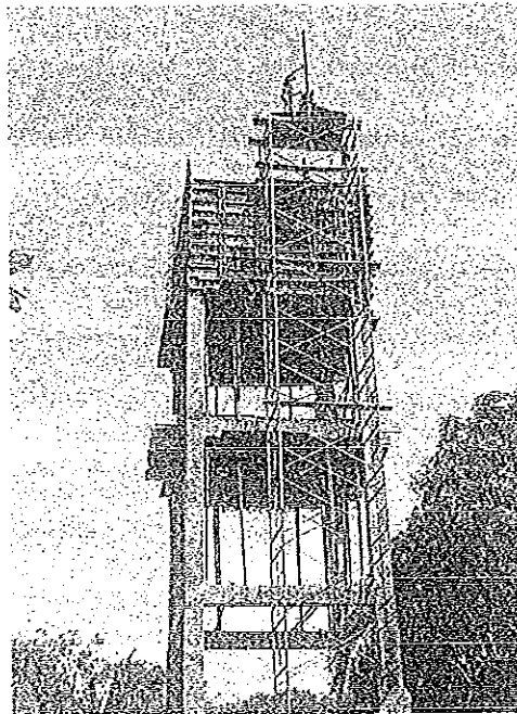
Foto 91: fundida de los muros y la tapa superior del tanque de matalarga.
