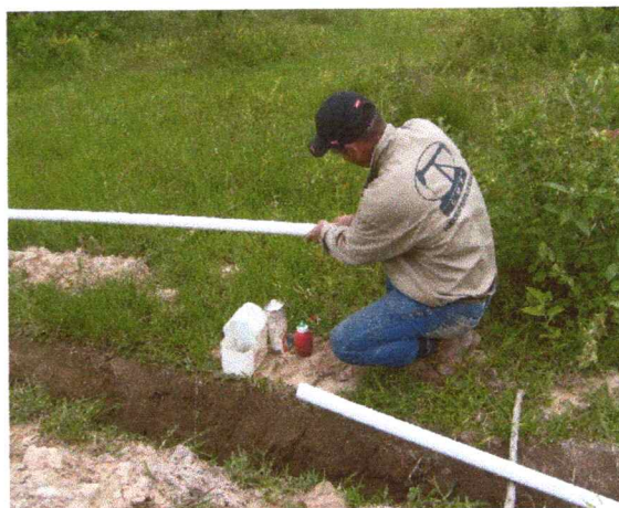
Imagen 12. Detalle empalme de tuberías redes de 2". Vereda Agualinda.
