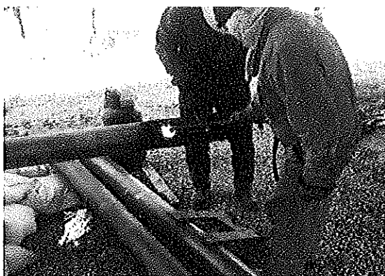
SOLDADURA TUBERIA ACERO AL CARBON POZO PROFUNDO
