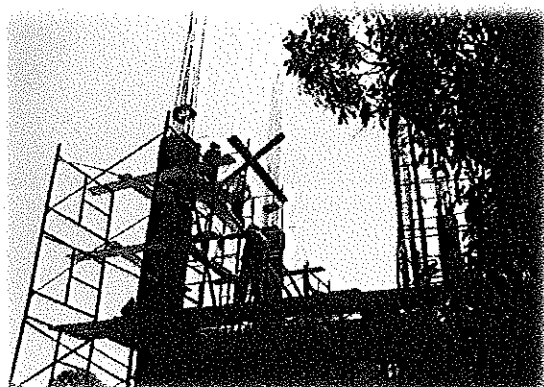
Armazon y encofrado columna segundo nivel vereda Matalarga
