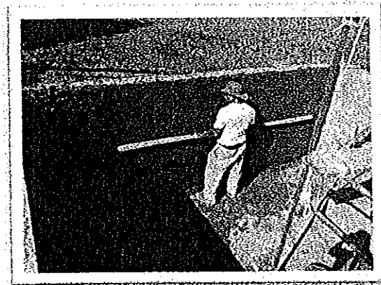
Foto 16: Aplicación del pañete impermeabilizado, aplicación a la mezcla producto sika-plastocrete para impermeabilizar la mezcla
