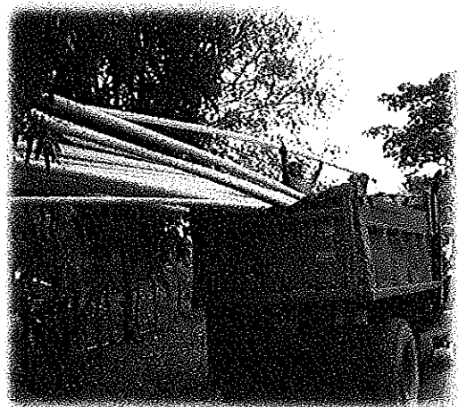
CARGUE DE TUBERIA PARA LA RED DE DISTRIBUCION (MATALARGA)
