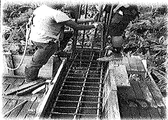
Armazon columna tercer nivel vereda San Isidro
