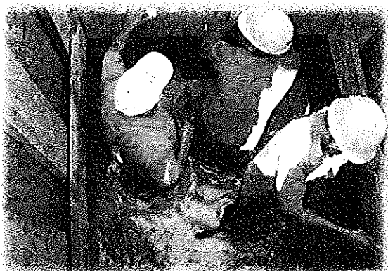
Colocacion entibado zapatas vereda Matalarga
