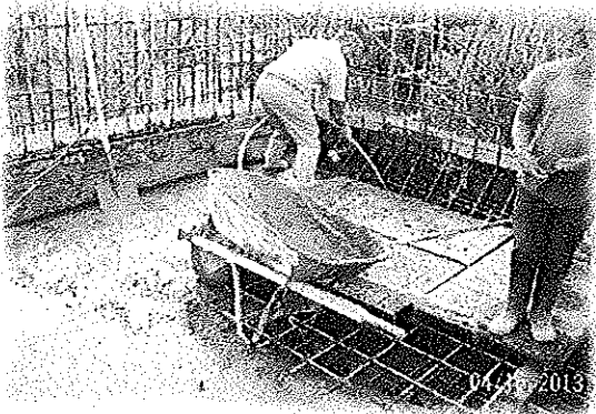
FUNDIDA VIGA, PISO TANQUE DE ALMACENAMIENTO
