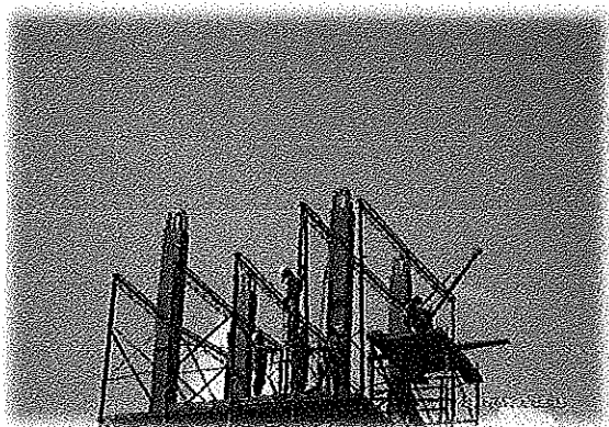
panoramica de armado plataforma soporte tanque de almacenamiento quinto nivel san isidro
