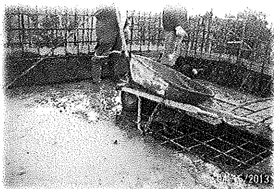
FUNDIDA VIGA, PISO TANQUE DE ALMACENAMIENTO
