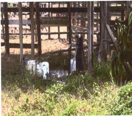
Imagen 17. Detalle cabezal de pozo profundo, sin mantenimiento en la Vereda Agualinda
