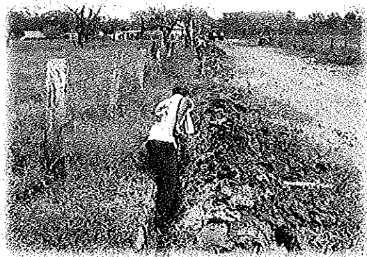
EXCAVACION PARA INSTALACION DE TUBERIA
