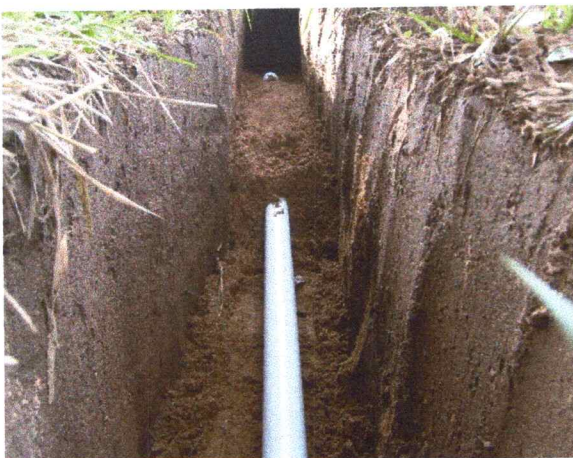
Imagen 09. Detalle etapa de relleno en arena, encamados y atraques de tubería. Vereda Agualinda.
