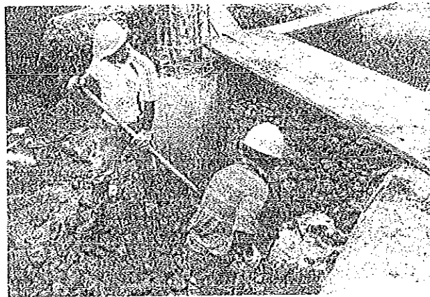
Foto No.110 Relleno con crudo de río
