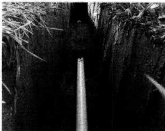
Imagen 09. Detalle etapa de relleno en arena, encamados y atraques de tubería. Vereda Agualinda.
