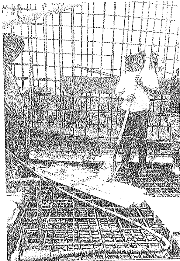
Foto 81: Proceso de fundida de la placa inferior tanque elevado de matalarga.
