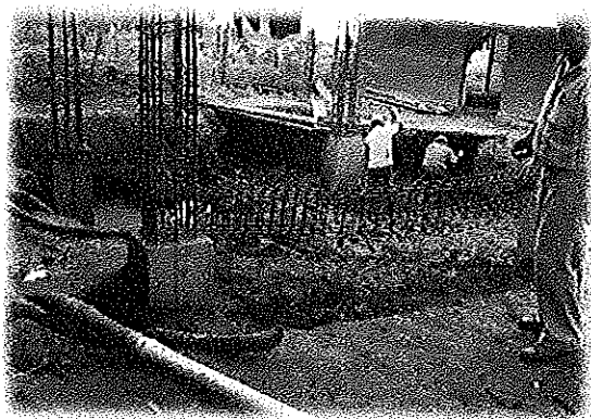
Relleno con crudo de rio cimentacion y pedestal vereda Matalarga
