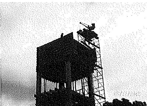
FUNDIDA MUROS TANQUE DE ALMACENAMIENTO
