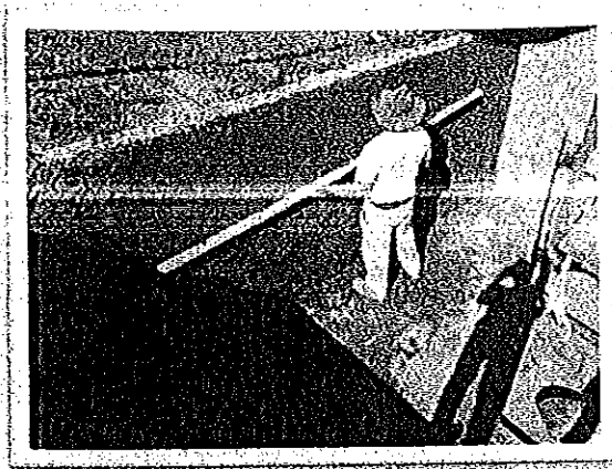
Foto 17: Aplicación del pañete impermeabilizado
