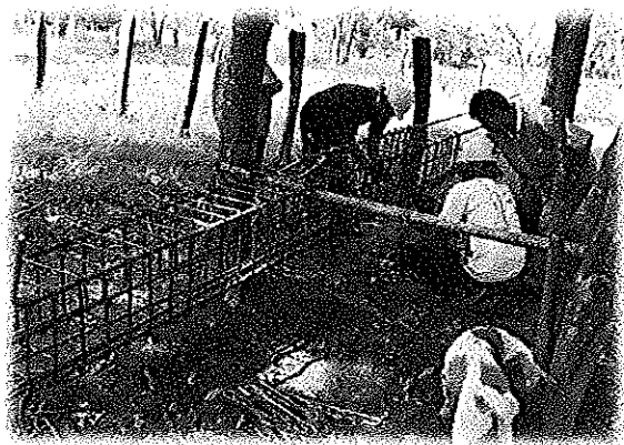
armazon columna vereda Matalarga
