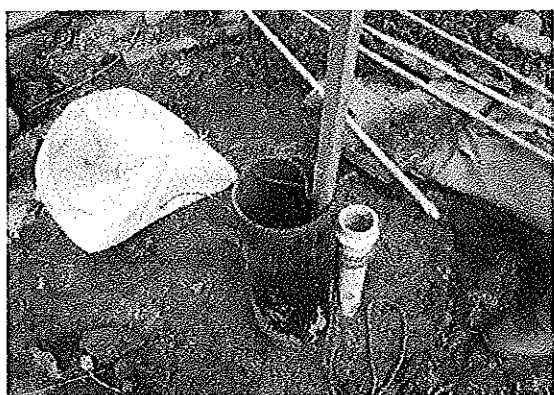
POZO PROFUNDO TUBERIA ACERO AL CARBON Y EN GRAVILLADOR
