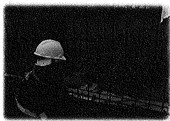
AMARRE REFUERZOS MURO TANQUE ALMACENAMIENTO (SAN ISIDRO)
