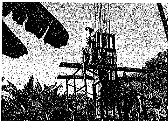
verificacion plomo ejes columnas segundo nivel vereda San Isidro
