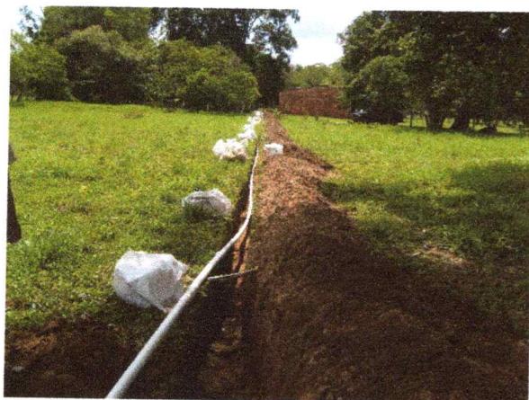
Imagen 07. Detalle etapa de tendido de tubería redes de distribución, Vereda Agualinda.
