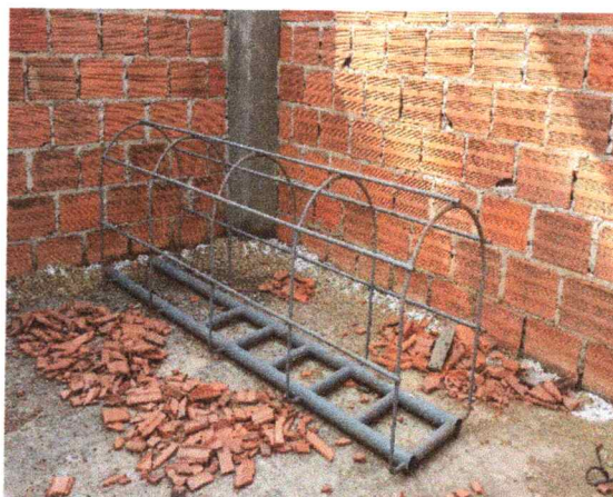
Imagen 32. Detalle escalera de acceso a tanque elevado sin instalar en vereda San isidro.
