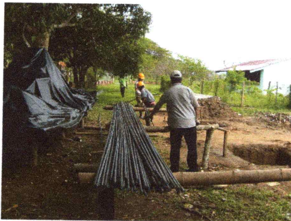
Imagen 07. Detalle etapa de acopio de materiales. Obsérvese acopio de aceros en vereda Matalarga.
