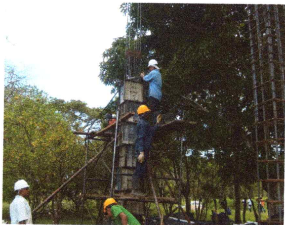
Imagen 11. Detalle amarre de aceros y encofrado columnas en concreto para tanque elevado en vereda Matalarga.
