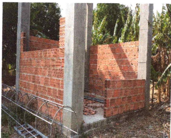
Imagen 29. Detalle estado de muros para caseta, escalera de acceso a tanque sin instalar en vereda San isidro. Obsérvese que no se terminó caseta ni se instaló la escalera de acceso al tanque.
