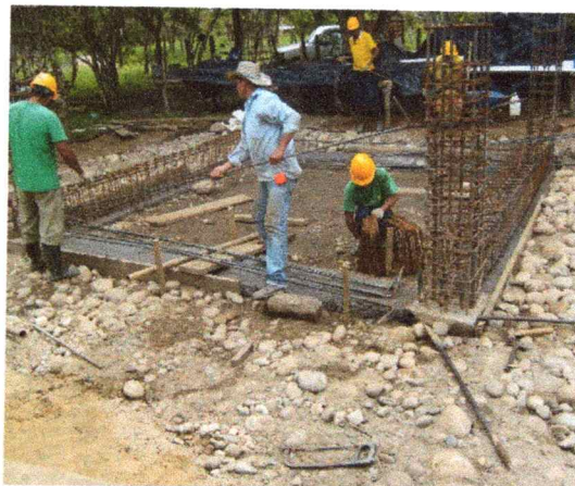
Imagen 10. Detalle amarre de aceros de viga de cimentación y columnas tanque de almacenamiento. Vereda Matalarga.
