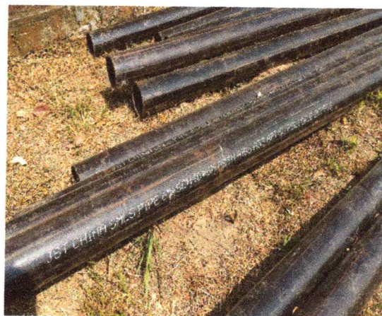
Imagen 24. Detalle acopio de materiales para proceso de construcción de pozo profundo en vereda San isidro. Obsérvese tubería de revestimiento.
