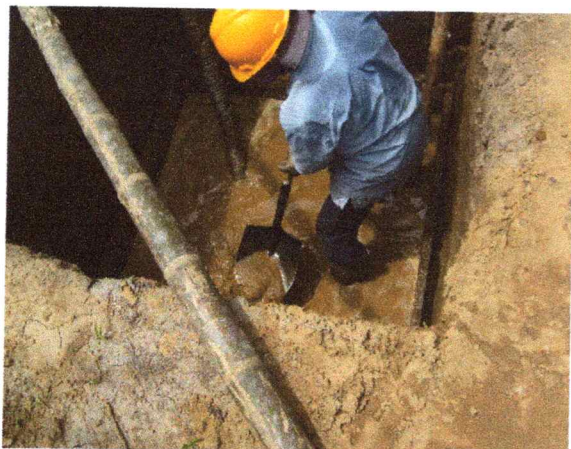
Imagen 09. Detalle excavación zanja para localización de zapatas en concreto. Obsérvese altos niveles freáticos en vereda Matalarga.
