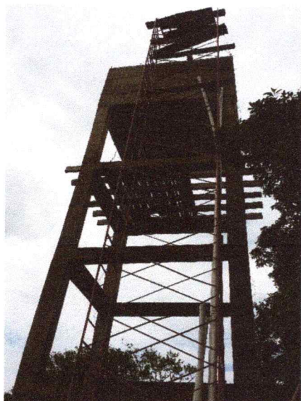
Imagen 13. Detalle infraestructura tanque elevado construido en Matalarga. Obsérvese tuberías hidráulicas sin conexión y sin escalera de acceso al tanque.
