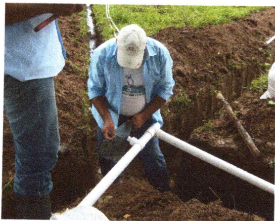
Imagen 11. Detalle conexiones de collarines y tees y emplame redes de 2". Vereda Agualinda
