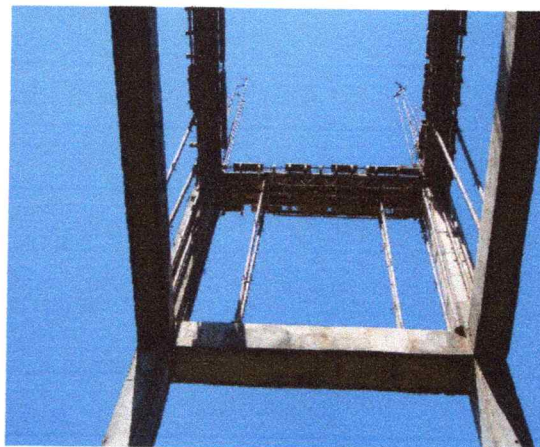
Imagen 12. Detalle amarre de aceros y encofrado columnas y vigas en concreto para tanque elevado en vereda Matalarga.
