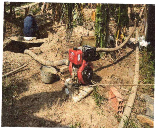
Imagen 27. Detalle recirculación de lodos para proceso de perforación de pozo profundo en vereda San isidro.
