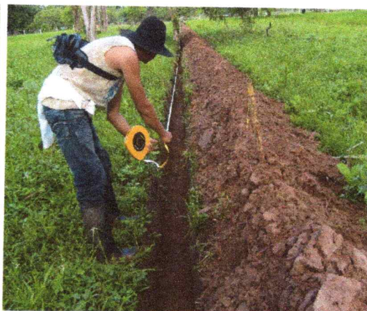
Imagen 06. Detalle medición cantidades componente redes de distribución. Vereda Agualinda.
