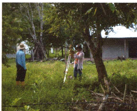
Imagen 02. Detalle proceso de replanteo y localización de redes de acuerdo en vereda Matalarga.
