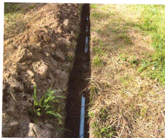
Imagen 08. Detalle etapa de relleno en arena, encamados y atraques de tubería. Vereda Agualinda
