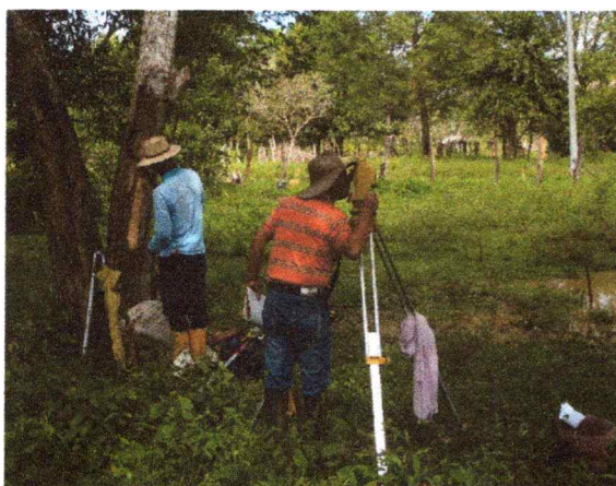
Imagen 01. Detalle proceso de replanteo y localización de redes de acueducto en vereda Matalarga.
