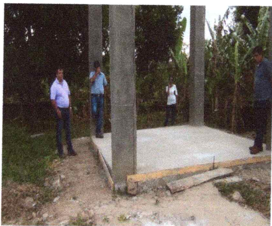
Imagen 21. Detalle placa fundida para emplazamiento de las casetas, en vereda San isidro.
