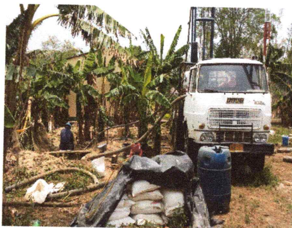
Imagen 28. Detalle frente de perforación pozo profundo en vereda San isidro.
