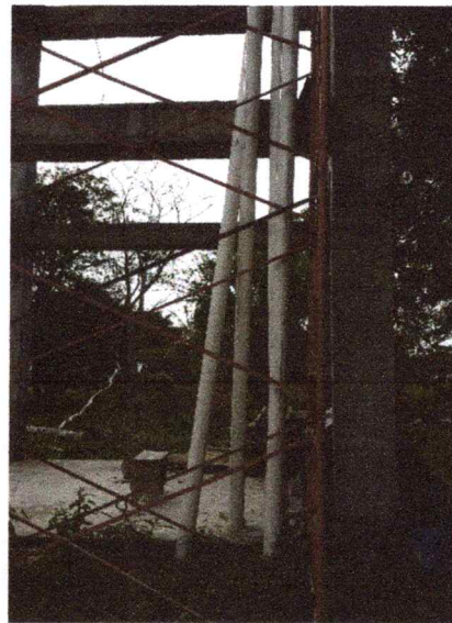
Imagen 14. Detalle infraestructura tanque elevado construido en Matalarga. Obsérvese tuberías hidráulicas sin conexión y sin escalera de acceso al tanque.
