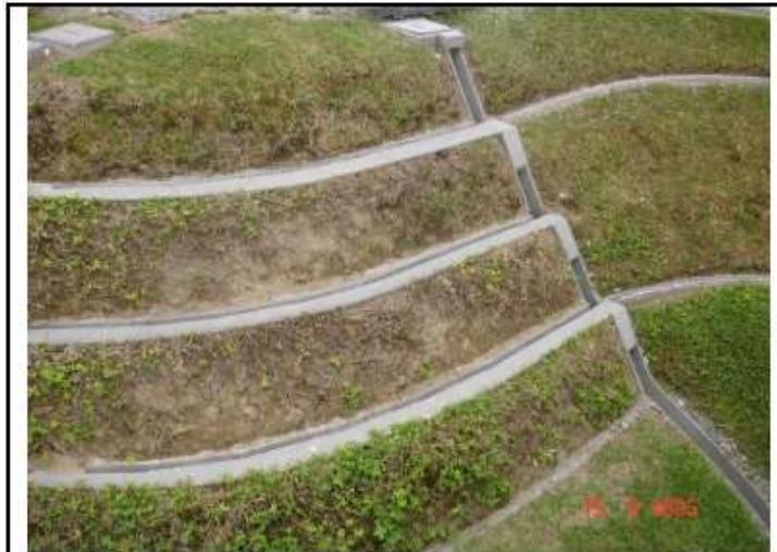
**Figura 6.1** El tratamiento de una ladera con taludes separados por canales que permiten el ordenamiento de las aguas de escorrentía y freáticas. (Fotografía Carlos E. Escobar P.)
