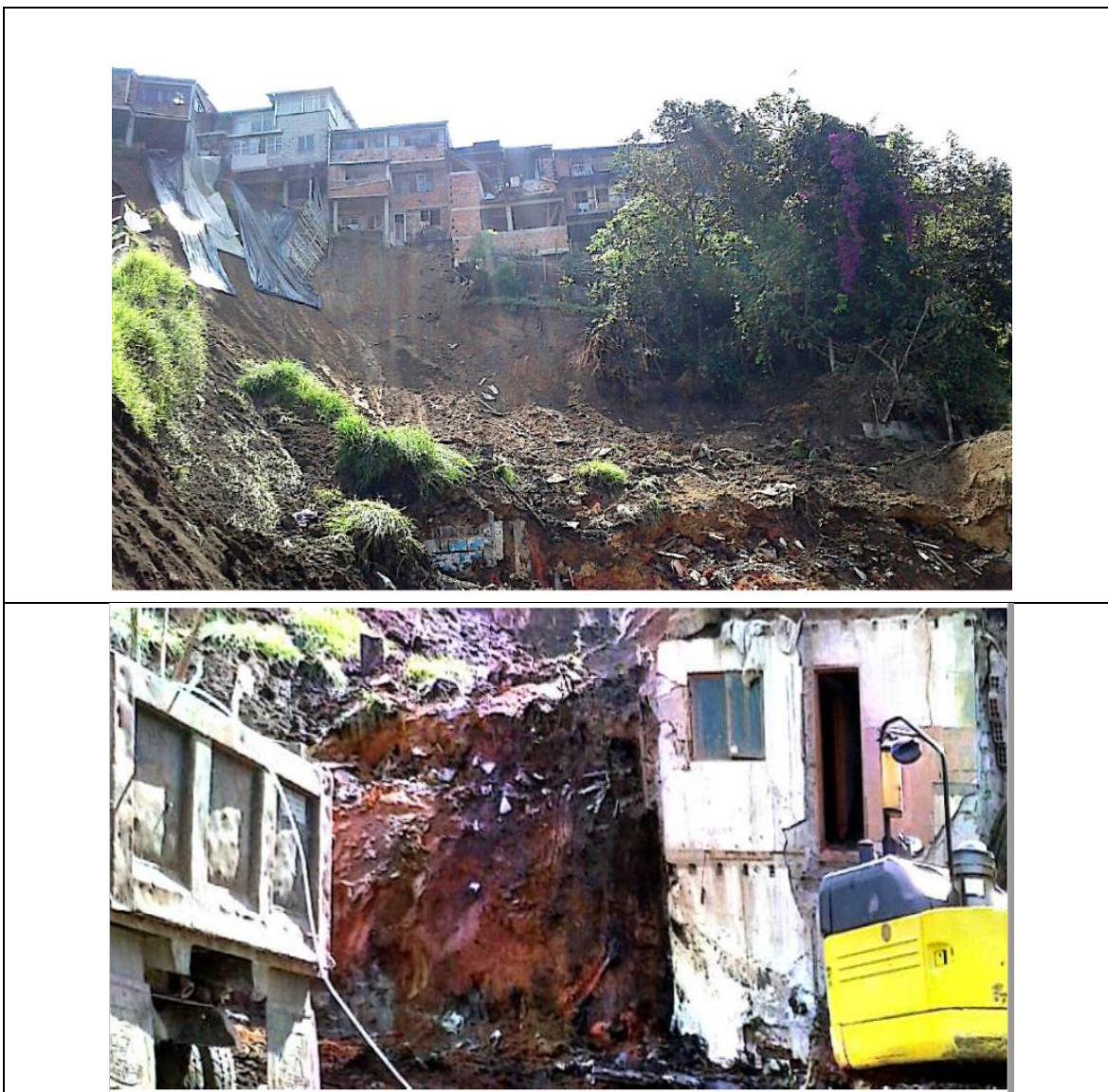
Ilustración 4. Registro fotográfico del deslizamiento de la ladera en el barrio González. Fuente: Recopilación fotográfica por parte de los afectados.
