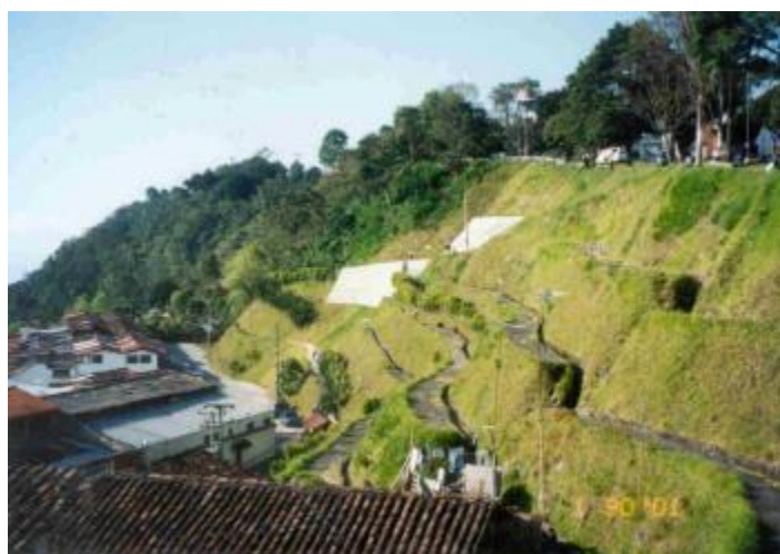
Ilustración 37. Tratamiento típico con zanjas colectoras. Fuente: Carlos E. Escobar P.
