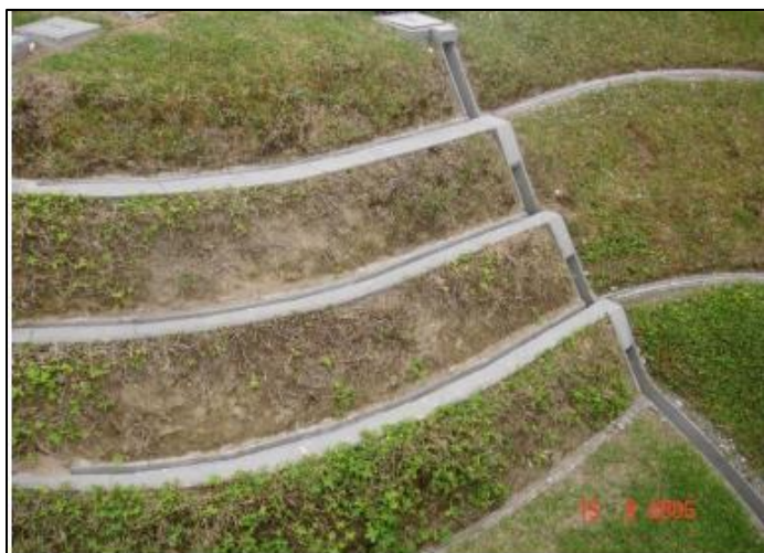
Ilustración 36. El tratamiento de una ladera con taludes separados por canales que permiten el ordenamiento de las de escorrentía y freáticas. Fuente: Carlos E. Escobar P.
