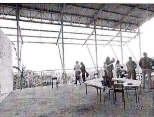
Centro cultural La Paz. Nivel C, Salón auditorio central, pisos en concreto
