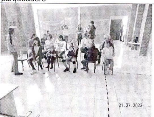
Centro cultural La Paz. Nivel C. salón principal con pisos acabados en cerámica. Mampostería de ladrillo
