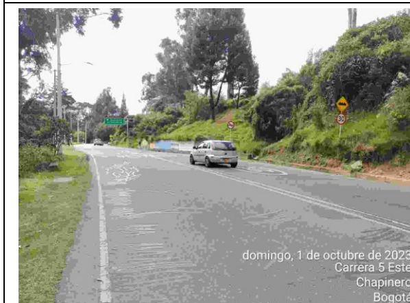
Foto 3. Panorámica Av. Circunvalar a la altura de la Diagonal 38. Vista al Norte.
