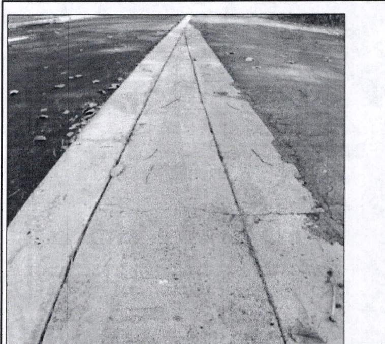
Foto No. 6 No se realiza la corrección de la fisura en sendero peatonal k0+340. No se recibe el tramo de andén.
