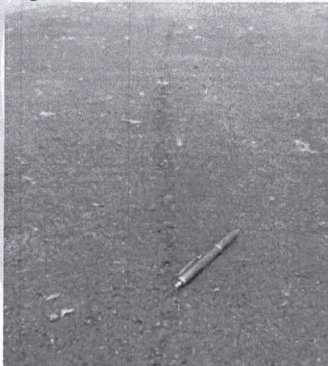
Foto No.25 Fisuramiento de construcción longitudinal
