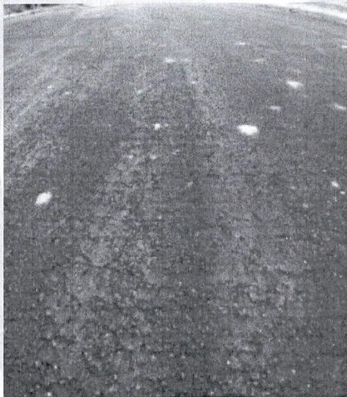
Foto No.21 Fisuramiento superficial
