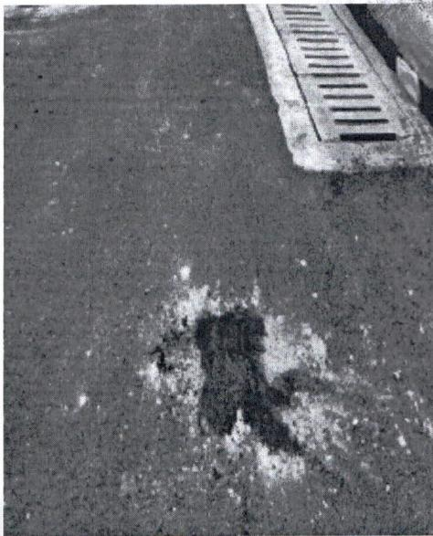
Foto No.27 Contaminación fluido maquinarias
