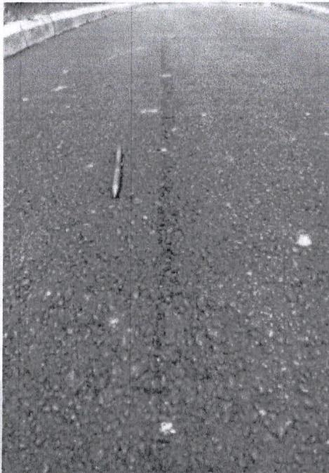
Foto No.23 Fisuramiento de construcción longitudinal
