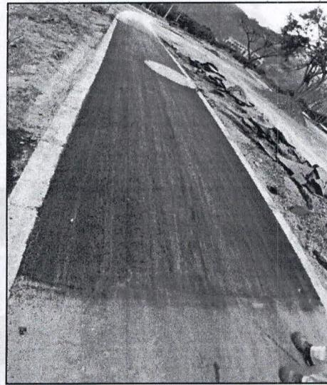
*Foto No.16 Arreglo de capa rodadura
