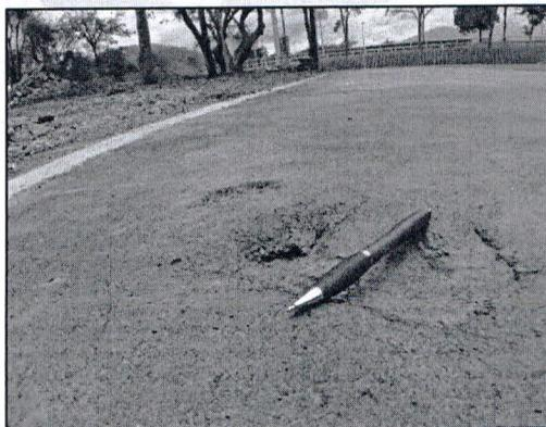
Foto No. 14 Arreglo de capa rodadura cicloruta tramo 3 Abscisa ko+240
