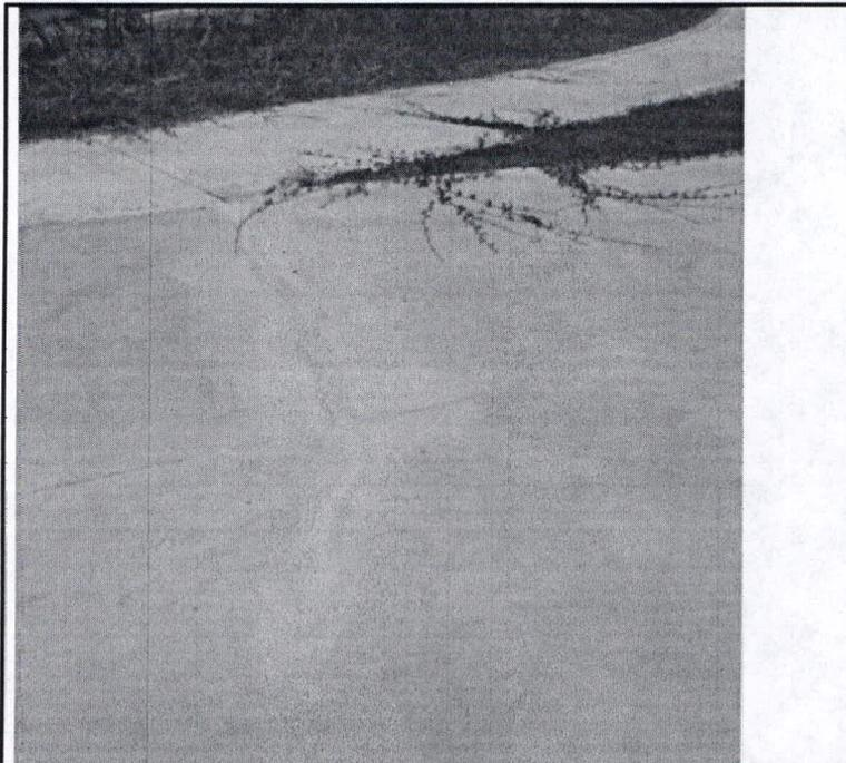
Foto No. 4 arreglo de fisura de manera NO CONFORME. Esta reparación no es aceptada.
