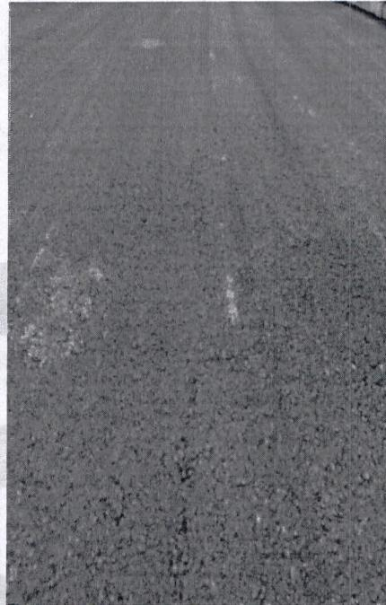
Foto No.24 Fisuramiento de construcción longitudinal
