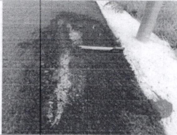
Superficie de asfalto presenta descaramiento y fisuramientos. Ubicación: Ciclo ruta # 2 k0+140 -150
