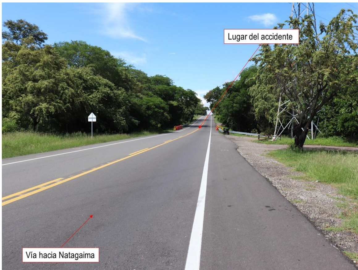
Fotografía No.7 GENERAL : Fotografía tomada en sentido hacia Natagaima, sobre el kilómetro 76+670, donde se observan las características generales del tramo de vía, morfología, estado, demarcación y señalización. En este sentido se desplazaba el vehículo tipo bus.
