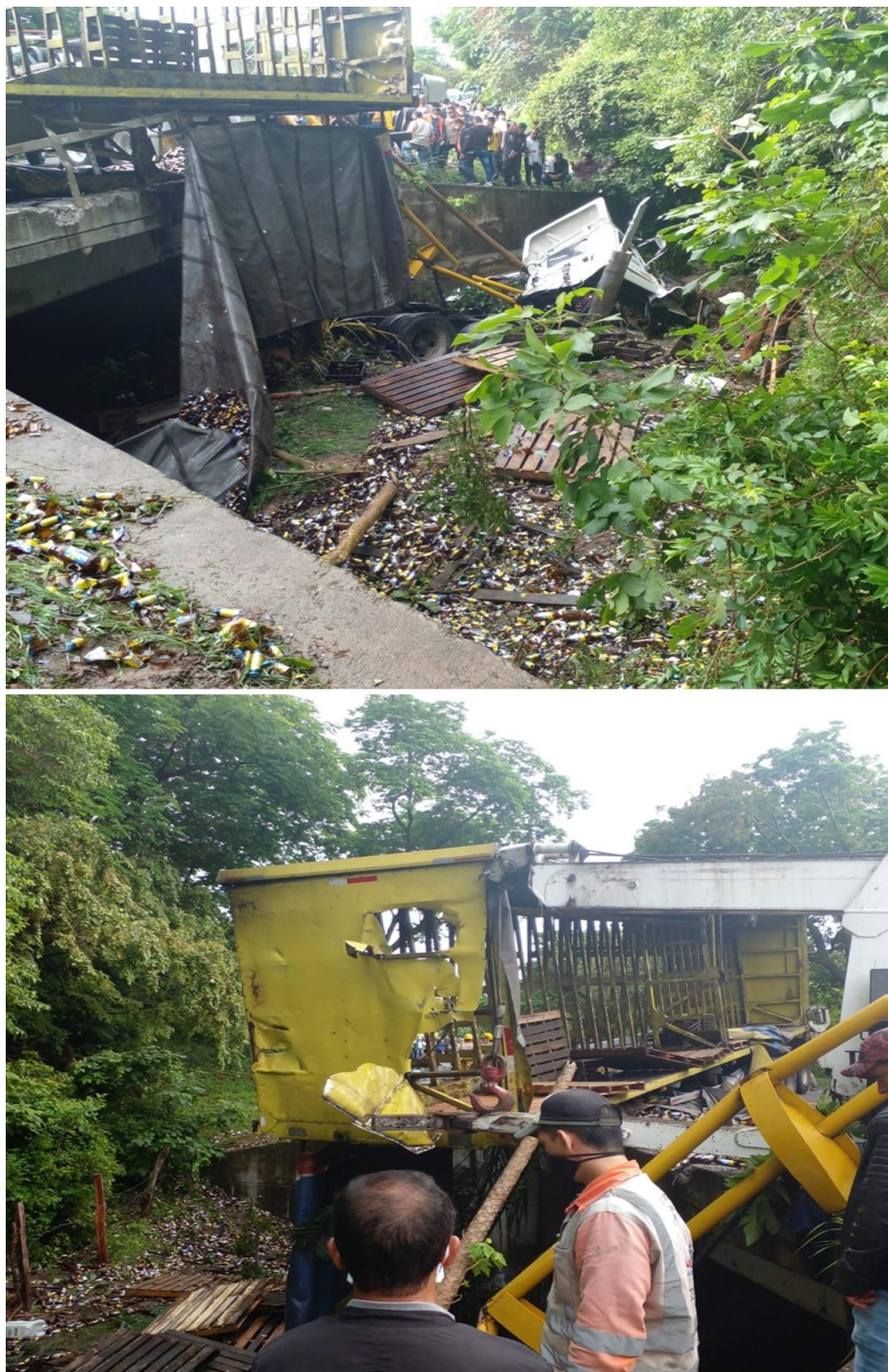
Fotografías No.21 y 22: Se observa la posición final del semirremolque y de la unidad tractor, involucrados en el accidente de tránsito.
