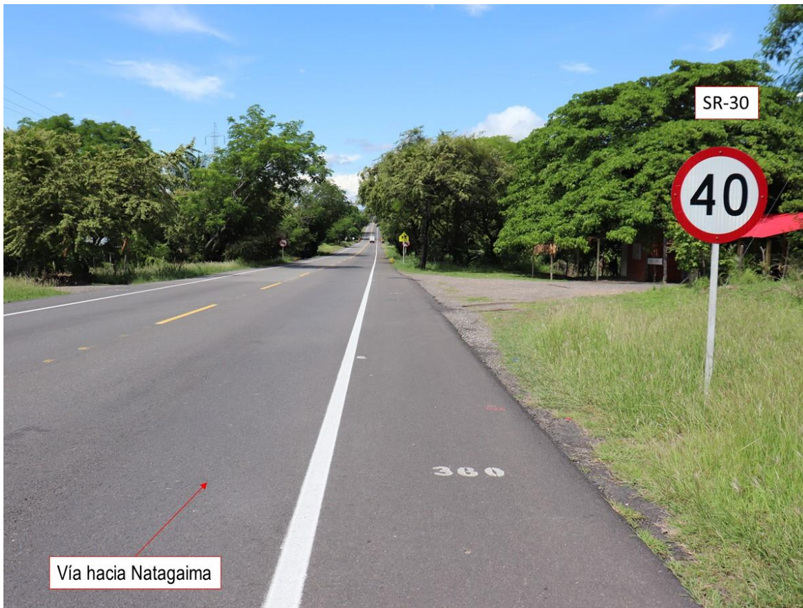
Fotografía No.5 GENERAL : Fotografía tomada en sentido hacia Natagaima, sobre el kilómetro 76+360, donde se observan las características generales del tramo de vía, morfología, estado, demarcación y señalización. En este sentido se desplazaba el vehículo tipo bus.
