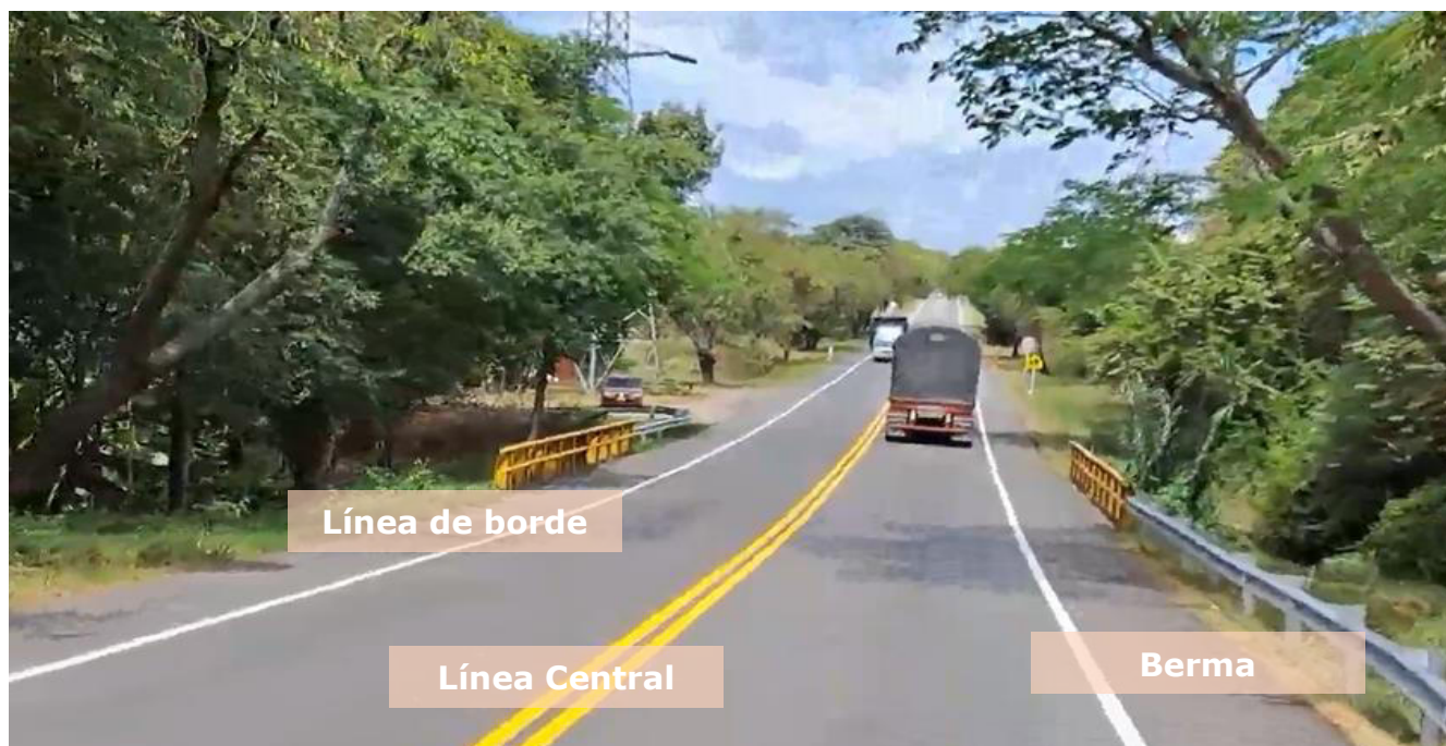
Imagen No. 16. Kilómetro 76+740 (lugar de los hechos o zona de conflicto) en el sentido vial Castilla - Neiva donde podemos evidenciar la señalización horizontal que posee el tramo de vía en sus dos carriles como lo son las líneas centrales, línea de borde y berma.
