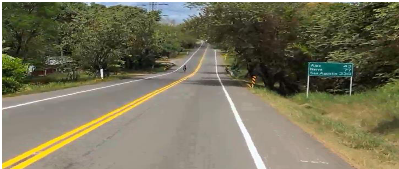
Imagen No. 15. Kilómetro 76+850 (110 mts antes del lugar de los hechos o zona de conflicto) en el sentido vial Castilla – Neiva donde podemos identificar la Señal informativa SI-06 señales de confirmación informando al usuario que el destino elegido se encuentra en la ruta.( fotografía propia ).
