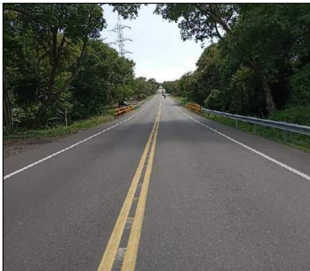
Imagen No. 04. Tomada el día de la inspección pericial de campo en sentido Castilla – Neiva.
