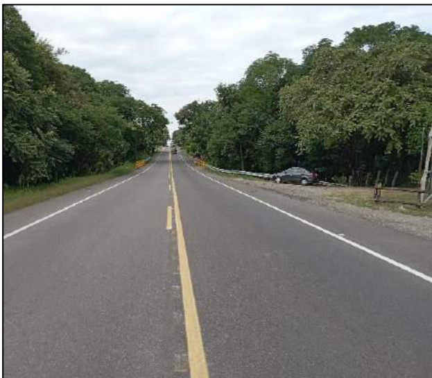
Imagen No. 05. Tomada el día de la inspección pericial de campo en sentido Neiva – Castilla.
