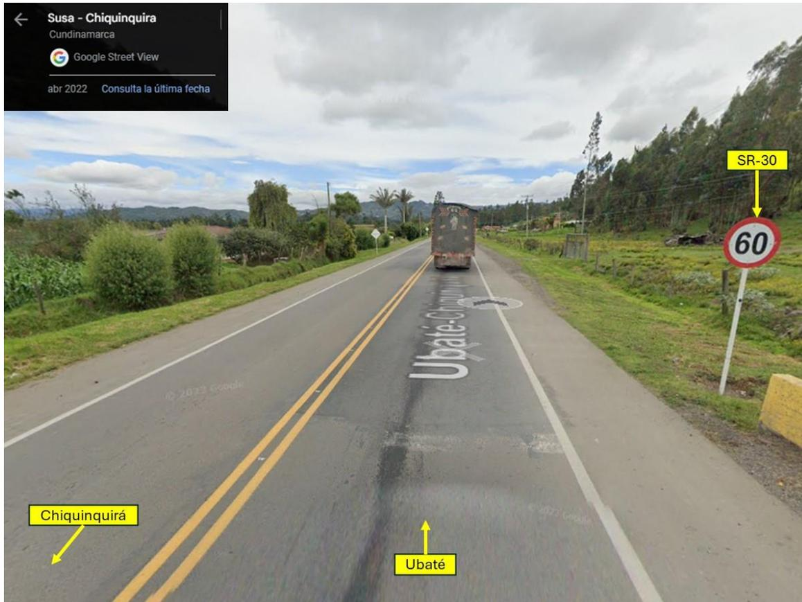
**Fotografía No. 1 Panorámica:** En esta fotografía sustraída de Google Street View (abril 2022) en sentido Chiquinquirá – Ubaté a la altura del km 34 + 700 m, se aprecian las características generales de la vía, en la cual se encuentra demarcación de línea amarilla doble continua y líneas de borde, con señalización vertical SR-30 (Velocidad máxima 60 km/h); en este sentido se desplazaban los vehículos.
