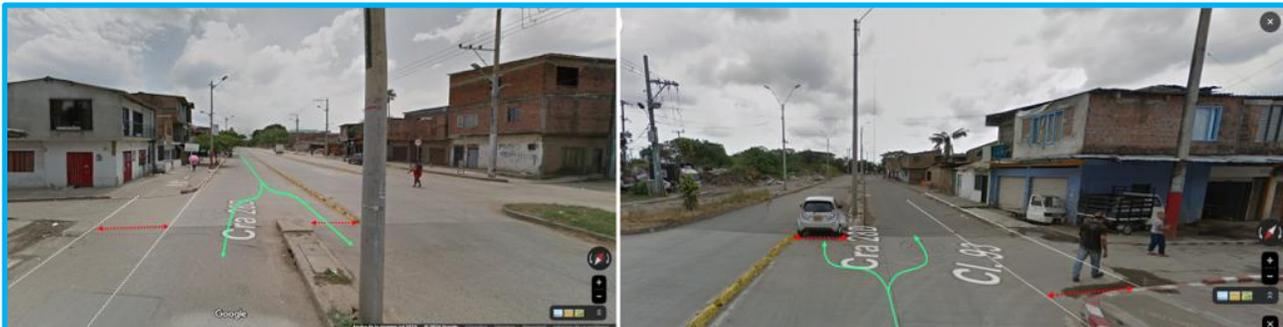
Imagen 15 CARRERA 28D calle 93. Finalización abrupta de separadores bifurcando la calzada occidente-orientado y dejando el separador como un obstáculo sobre la calzada. (Imagen Google Maps enero-julio de 2019)
