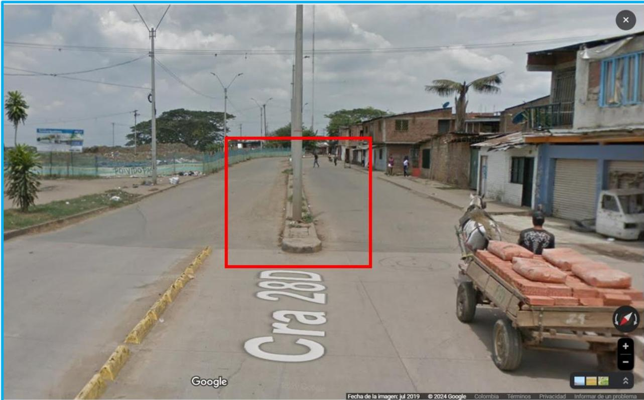
Imagen 14 CARRERA 28D calle 93. Separador y poste dentro de la calzada derecha de la carrera 28D sin pintura reflectiva de prevención, ni señalización (Imagen Google Maps julio de 2019)
