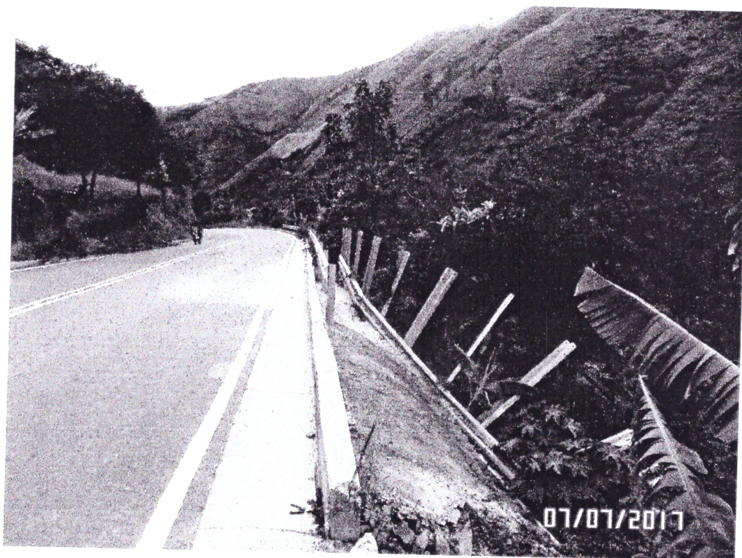
Fotografía 6. PR 33+840 Estabilidad de cuneta vial. Vía Túquerres – Samaniego, MD.
