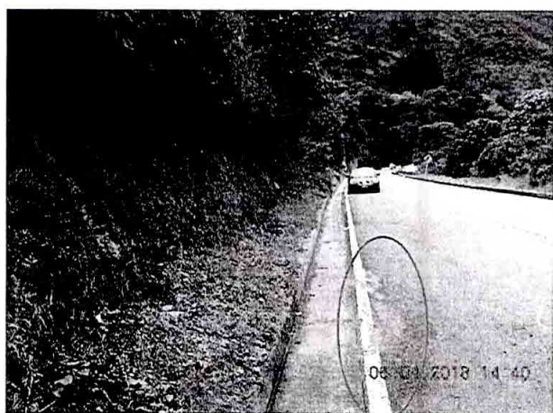
Ilustración 50 En la cuneta y carpeta asfáltica se evidencio constante material de arena y agua, el cual proviene el predio aledaño, ocasionando el desgaste prematuro del pavimento
