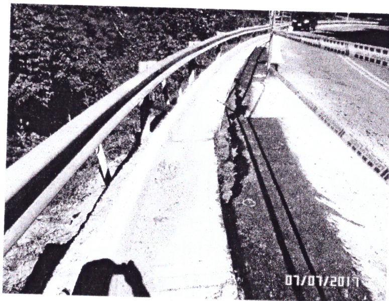
Fotografía 1. PR 22+400 Agrietamiento de Carpeta Asfáltica y Asentamiento de Cuneta Vía Túquerres – Samaniego, MD.
