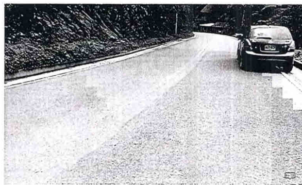
Ilustración 16 Extraída del video tomado el día 6 de abril 2018, en la cual, se evidencia la Presencia de material arcilloso sobre la carpeta asfáltica.
