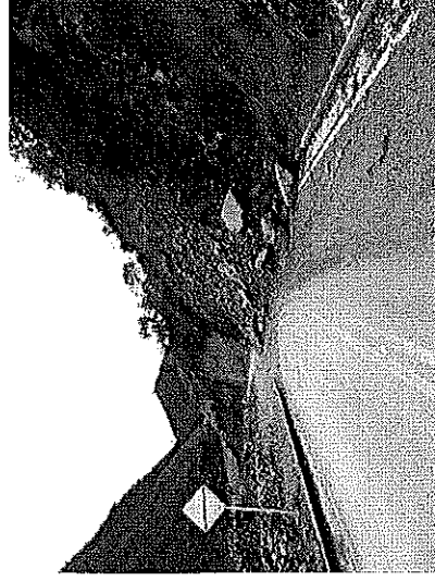
Fotografías No 19 y 20 Material de derrumbe colmatando las cunetas y desgaste prematuro de la carpeta asfáltica
