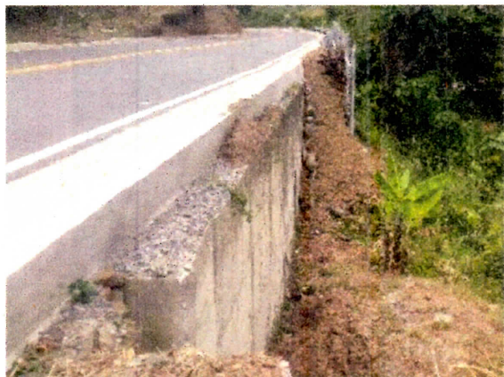
Trinchos instalados en el PR33+840 MD, Vía Tuquerres – Samaniego.
