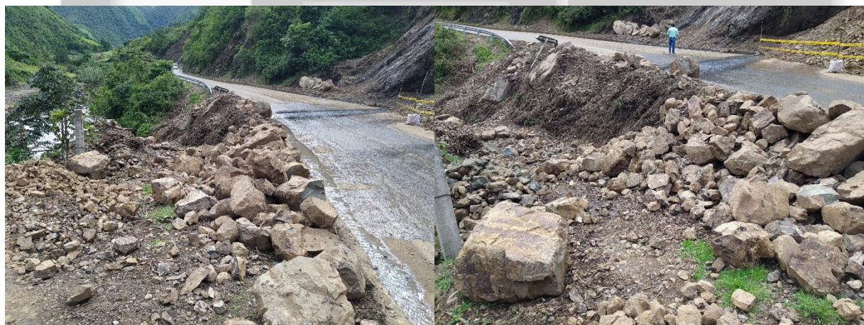
Fotografía 8.1-1 Deslizamiento traslacional PR28+300.
