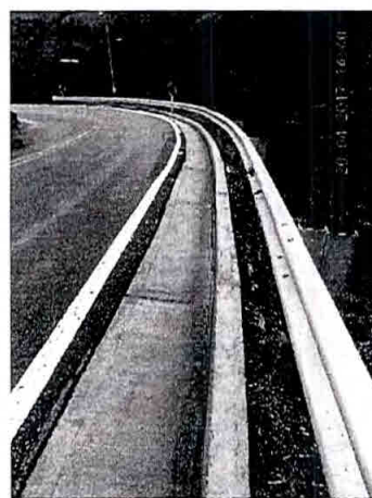
Ilustración 27 Separación de la cuneta y la carpeta asfáltica en ambos sentidos
