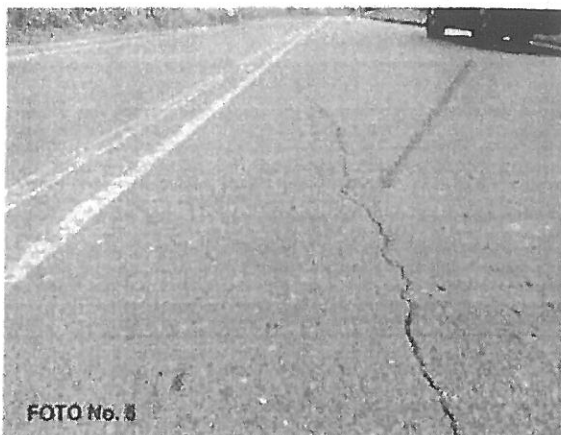
5+0551. FISURAS LONGITUDINALES
