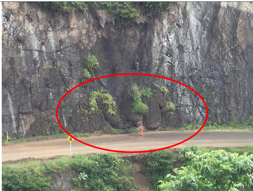
Fotografía 7. Evidencia de la presencia de deformaciones en la malla de protección presente en el talud de corte vial en el sector evaluado.
