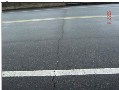
Figura 9.4-2. Fisura transversal – PR. Fuente: [3]
