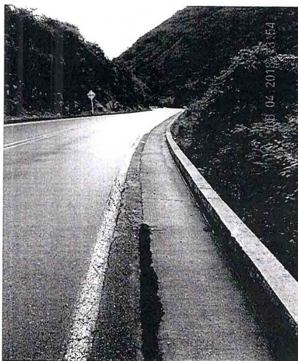
Ilustración 56 Fisura entre pavimento y cuneta en concreto, así mismo se presenta al borde de la calzada una fisura en la carpeta asfáltica, debido al asentamiento del muro en gavión.
