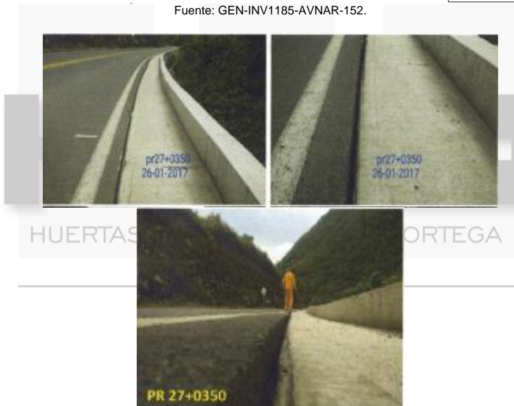
Fotografía 12.3-1. Separación de cuneta y carpeta asfáltica en PR27+0350
