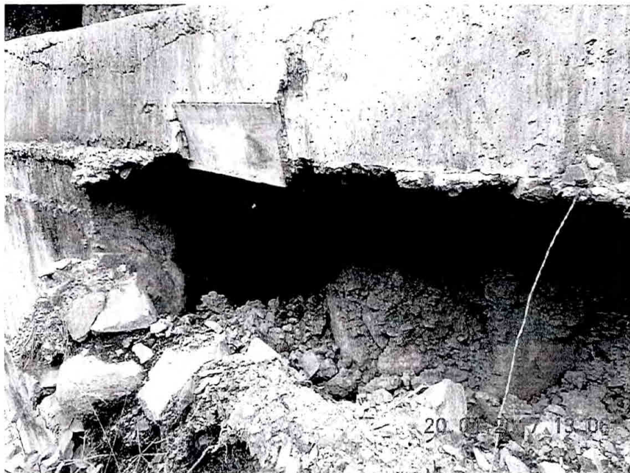
Ilustración 63 Estructura granular totalmente saturada de agua y presencia de des confinamiento de la misma
