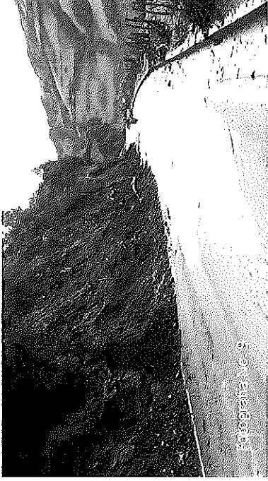
Fotografía No 9 Material de derrumbe colmatando las cunetas y desgaste prematuro de la carpeta asfáltica
