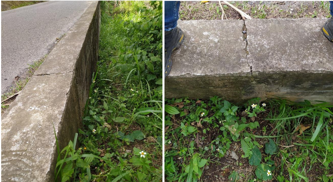
Fotografía 8.3-1 Daño en muro de contención K36+200.
