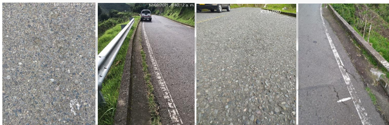
Fotografía 8.5-1 a) Pérdida de agregado K42+325 - b) Separación bermas K14+400 – c) Desgaste superficial K13+980 – d) Fisuras de borde K14+320
