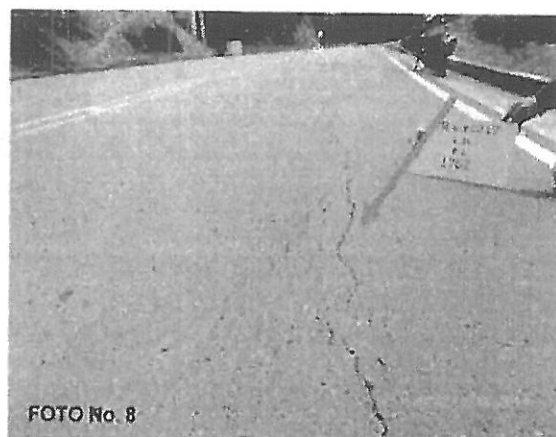
6+0217. FISURAS LONGITUDINALES
