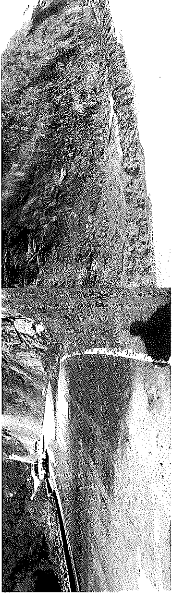
Fotografía No 15 Material arcilloso de derrumbe colmatando las cunetas y desgaste prematuro de la carpeta asfáltica por flujo de agua y material arcilloso sobre la misma
