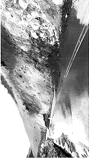
Fotografía No 6 Material de derrumbe colmatando las cunetas y desgaste prematuro de la carpeta asfáltica por flujo de agua sobre vía
