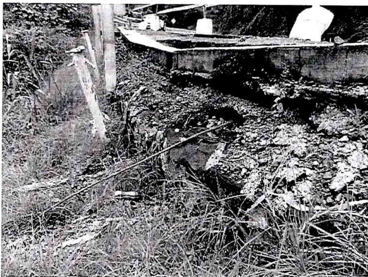
Ilustración 33 tomada el 6 de abril de 2018, se muestra la inclinación del muro de gaviones, desplazamiento de la cuneta y fracturación de la misma, debido al movimiento del muro en gavión.
