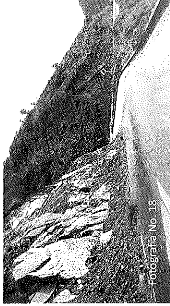
Fotografías No 18 y 19 Material de derrumbe colmatando las cunetas obstruyendo la vía y afectando la carpeta asfáltica, desgaste prematuro de la misma. Presencia de flujo de agua y material de derrumbe sobre la carpeta asfáltica, generando desgaste prematuro de la misma
