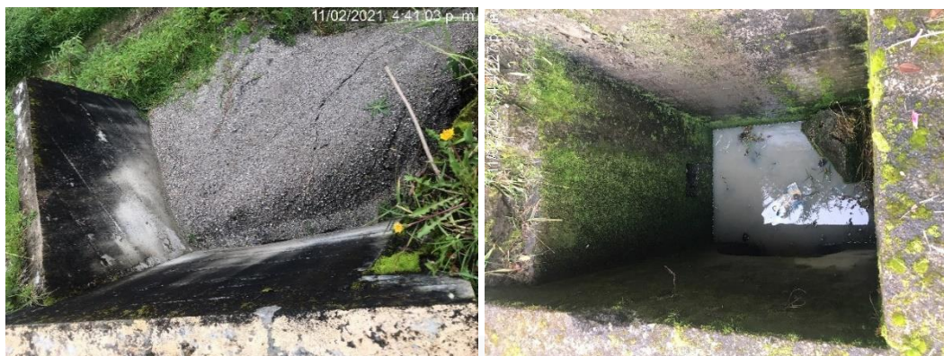
Fotografía 8.4-2 Obras de drenaje con obstrucciones PR14+900.
