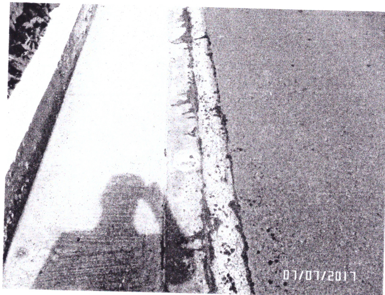
Fotografía 4. PR 27+350 Agrietamiento en Sellado vial-Vía Túquerres – Samaniego, MD.
