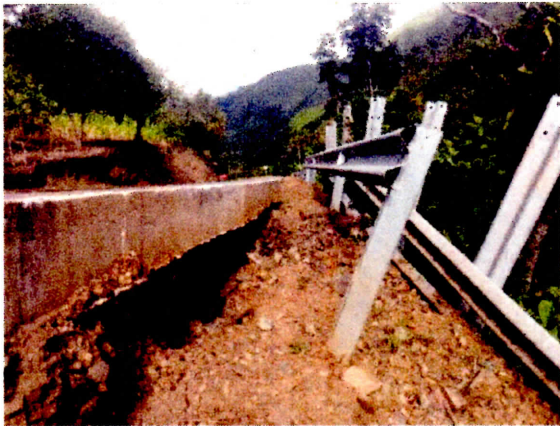
Socavación presentada en la cuneta. PR33+840 MD, Vía Túquerres – Samaniego.
