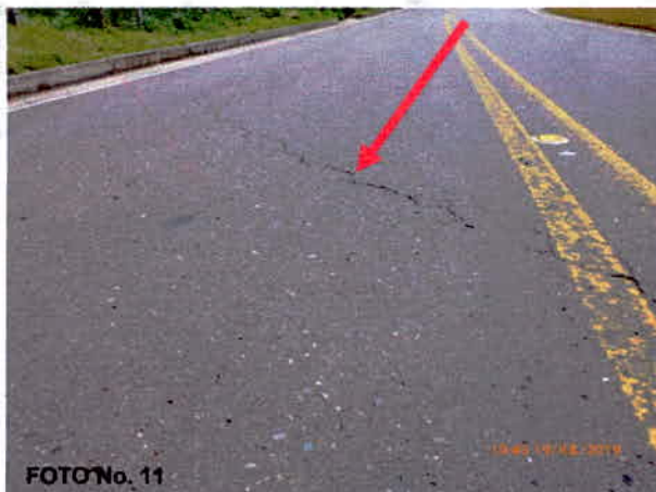
6+0752. FISURAS TRANSVERSALES.
