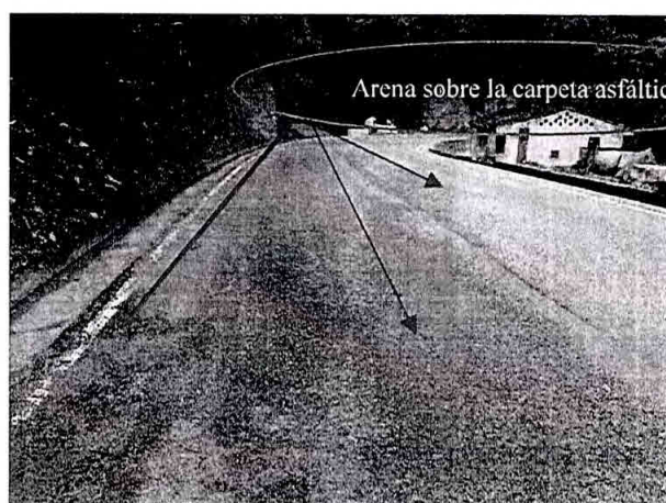
Ilustración 51 En la carpeta asfáltica se evidencio constante material de arena el cual proviene el predio que se muestra en la ilustración 22, el cual ocasionando el desgaste prematuro del pavimento
