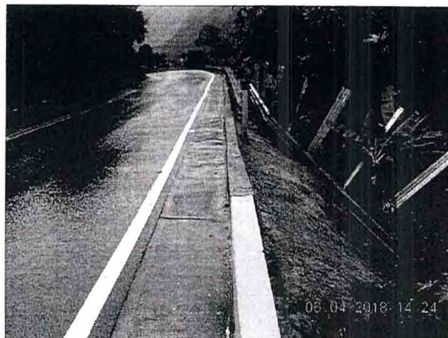
Ilustración 59 Cuneta en concreto en buen estado, concreto de protección de talud en buen estado.
