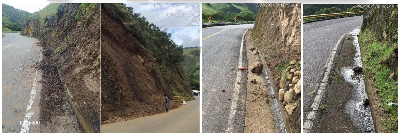
Fotografía 8.4-1 Obras de drenaje con obstrucciones a) PR13+700 – b) PR22+200 – c) PR14+150 – d) PR14+300.
