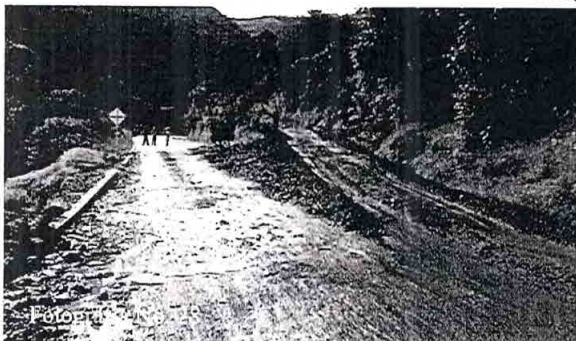
Fotografías No 28 Material de derrumbe colmatando las cunetas y la totalidad de la vía, originado desgaste total de la carpeta asfáltica
