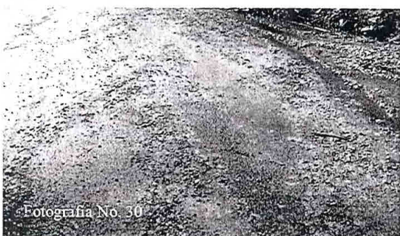
Fotografías No 30 Material de derrumbe sobre la carpeta asfáltica Fotografías No 31 Evidencia de desgaste prematuro de la carpeta asfáltica por presencia de agua y material de derrumbe
