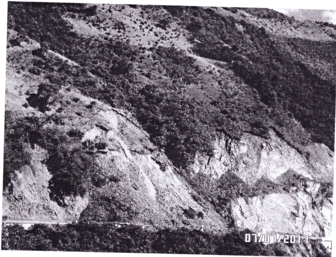
Fotografía 10. PR 19+800 Panorámica Deslizamiento Vial - Sector Guasy Vía Túquerres – Samaniego.
