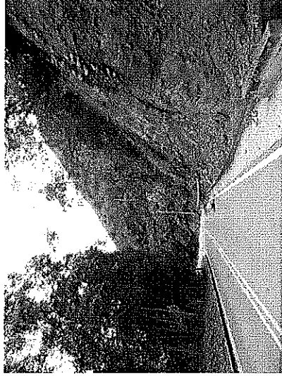
Fotografías No 19 y 20 Material de derrumbe colmatando las cunetas y desgaste prematuro de la carpeta asfáltica
