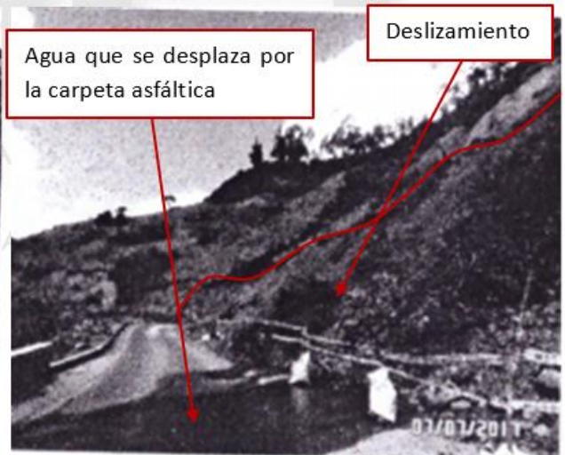
Fotografía 10.1-12. Obstrucción de cuneta, contaminación y agua desplazándose sobre la carpeta a) PR19+800 y b) PR27+840.
