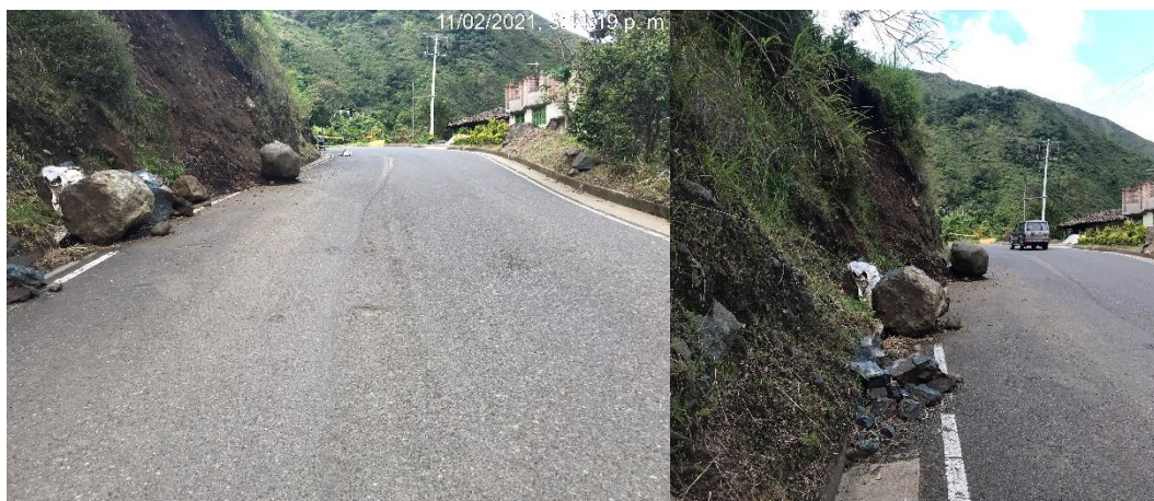
Fotografía 8.1-2 Caída de bloques PR32+600.
