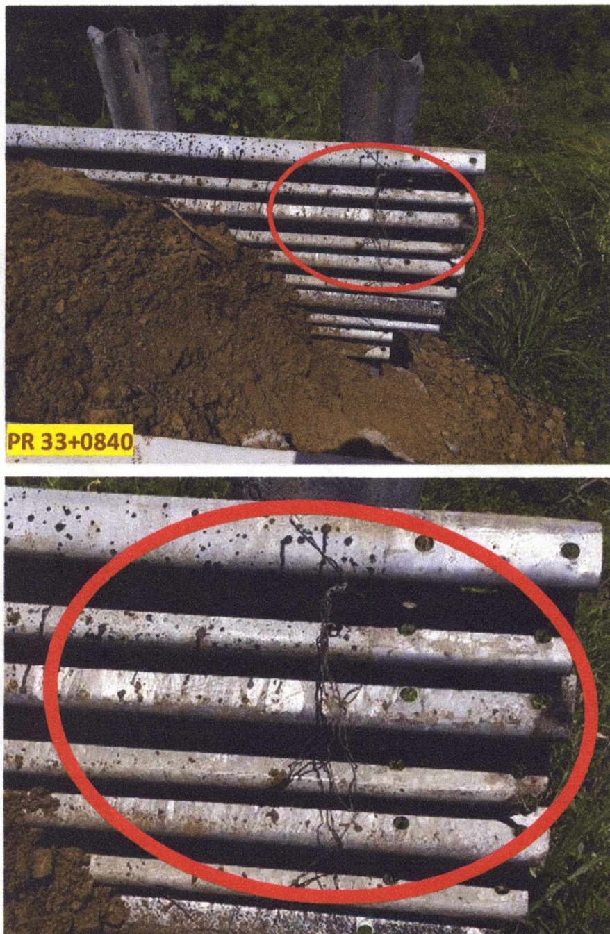
PR 33+0840, sistema de sujeción de los elementos metálicos, empleado en la construcción de la obra
