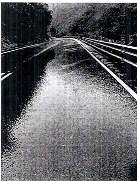
Ilustración 63 fisura longitudinal en Carpeta Asfáltica
