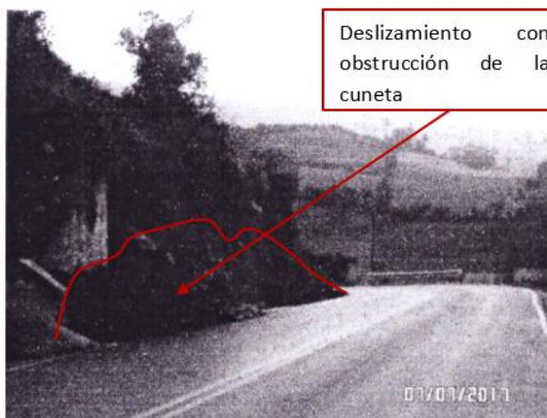
Fotografía 10.1-13. Obstrucción de cuneta y contaminación de la carpeta a) PR05+380 y b) PR09+190.
