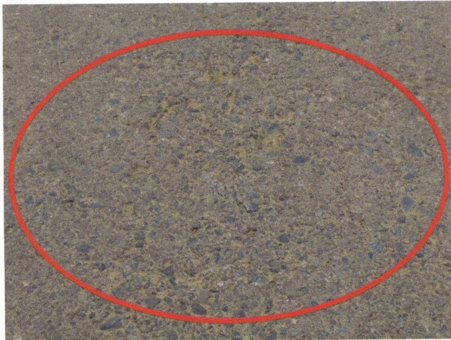
PR 19+0200, se observa en la superficie el agregado expuesto
