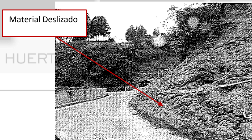
Fotografía 10.1-2. Obstrucción de cuneta y contaminación carpeta.
