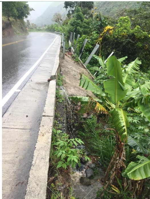
Fotografía 6. Evidencia de la pérdida de verticalidad de los elementos verticales que conforman la estructura tipo trincho metálico.
