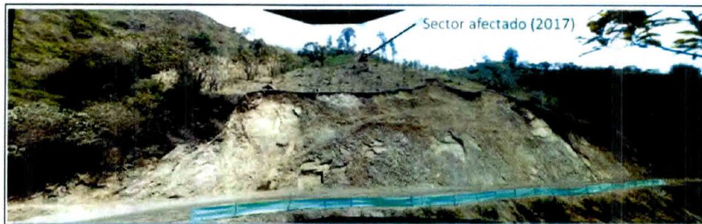
Fotografía 2. Tramo en ampliación en donde se aprecia la roca fracturada. Fuente: Propia. 20-ago-15.
