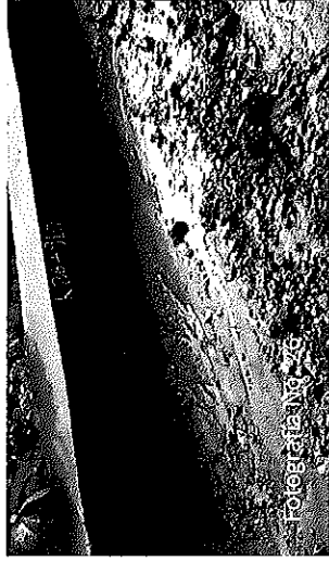
Fotografía No 25 Carpeta asfáltica con desgaste prematuro por efectos del constante flujo de agua sobre la misma, producto de la obstrucción de la cuneta
