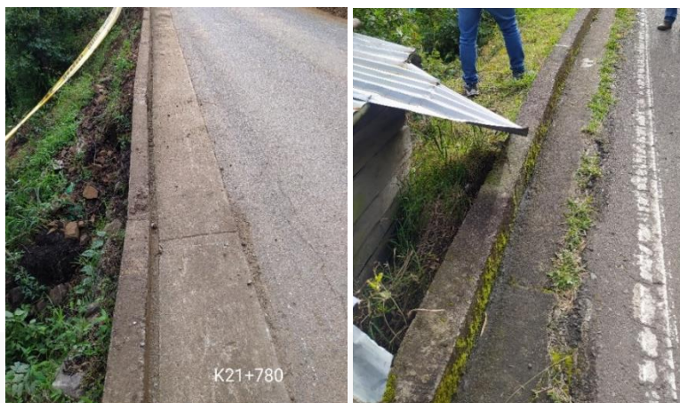
Fotografía 8.3-3 a) Hundimiento cuneta K21+780 – b) Separación de cuneta K14+400.
