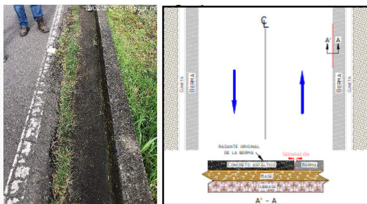
Figura 9.4-8. Separación de la berma PR16+300.
