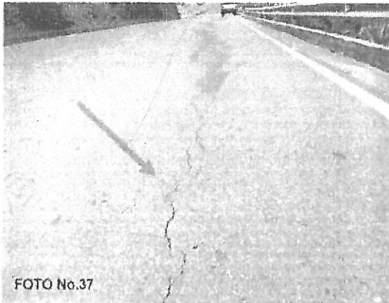
33+0740 FISURAS LONGITUDINALES (ANTERIORMENTE SELLADAS)
