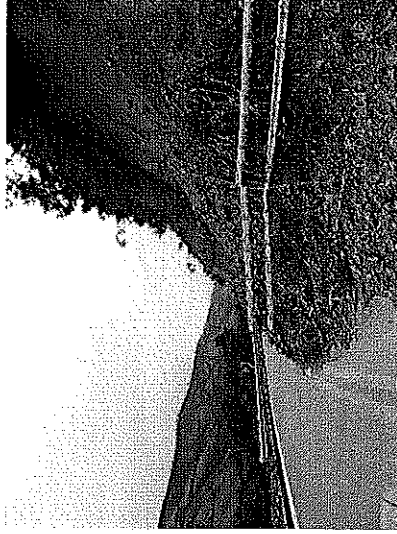
Fotografías No 13 y 14 Material de derrumbe colmatando las cunetas y desgaste prematuro de la carpeta asfáltica
