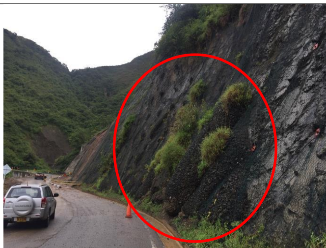
Fotografía 8. Evidencia de la presencia de deformaciones en la malla de protección presente en el talud de corte vial en el sector evaluado.
