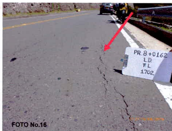
8+0162. FISURA LONGITUDINAL
