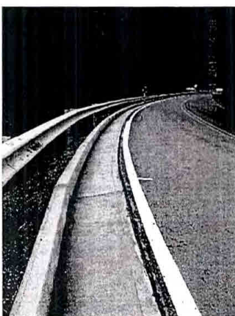
Ilustración 25 Junta entre la carpeta asfáltica y la cuneta
