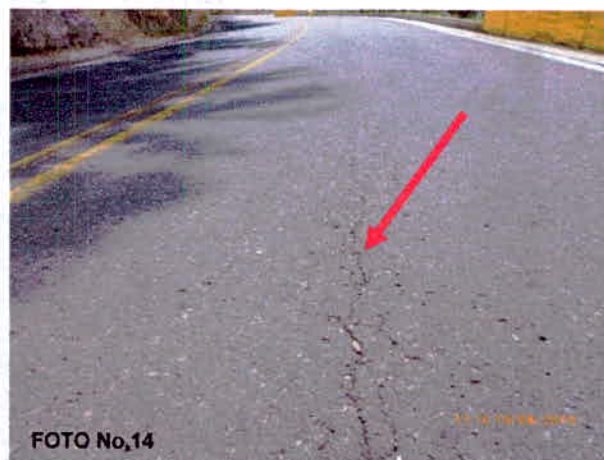
7+0656. FISURA LONGITUDINAL
