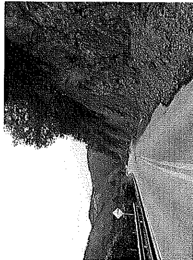
Fotografías No 17 y 18 Material de derrumbe colmatando las cunetas obstruyendo la vía y afectando la carpeta asfáltica, desgaste prematuro de la misma
