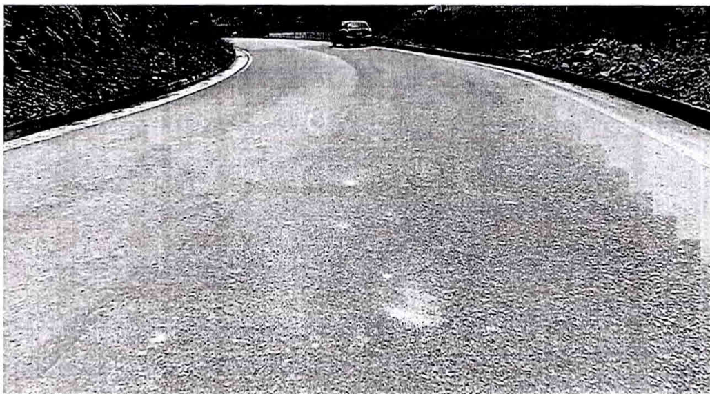
Ilustración 17 Extraída del video tomado el día 6 de abril 2018. en la cual. se evidencia la Presencia de material arcilloso sobre la carpeta asfáltica.
