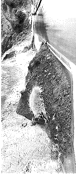
Fotografía No 6 Material de derrumbe colmatando las cunetas y desgaste prematuro de la carpeta asfáltica por flujo de agua sobre vía
