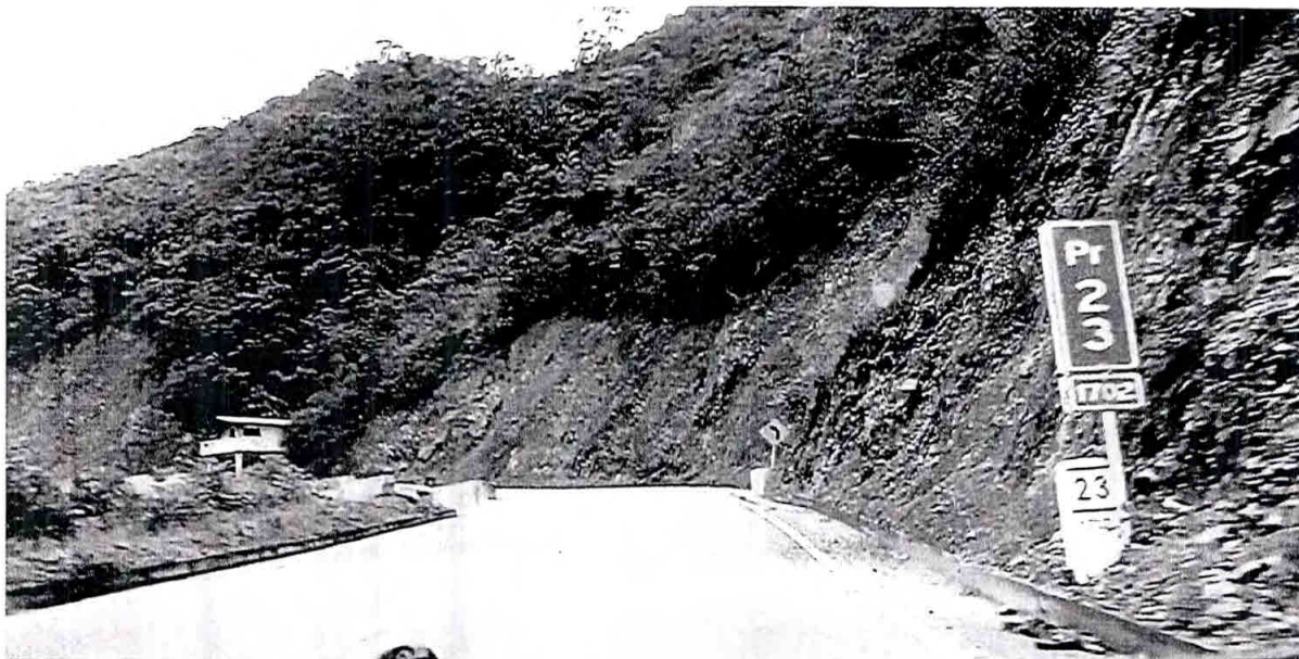
Ilustración 35 tomada el día 6 de abril de 2018 y en la cual se muestra el Desgaste superficial prematuro de la carpeta asfáltica, así mismo sobre ella se evidencia material suelto proveniente del talud
