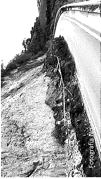
Fotografías No 4 Material de derrumbe colmatando las cunetas obstruyendo la vía y afectando la carpeta asfáltica
