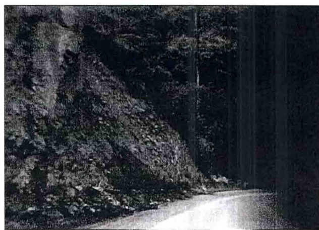
Ilustración 8 Extraída del video tomado el día 4 de mayo 2017, en la cual, se evidencia la Presencia de material arcilloso sobre la carpeta asfáltica, a lo ancho de toda la vía.
