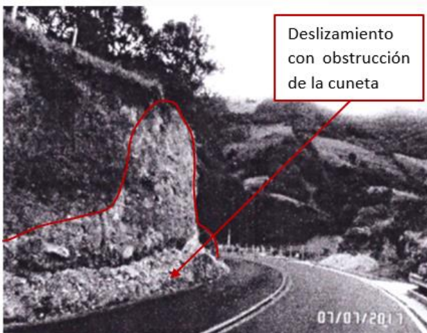
Fotografía 10.1-14. Obstrucción de cuneta y contaminación de la carpeta a) PR11+390 y b) PR26+890.
