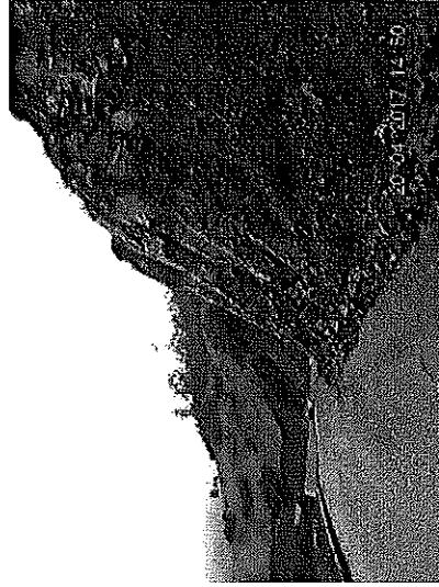
Fotografías No 7 y 8 Material de derrumbe colmatando las cunetas y afectando la carpeta asfáltica
