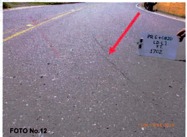
6+0820. FISURAS LONGITUDINALES
