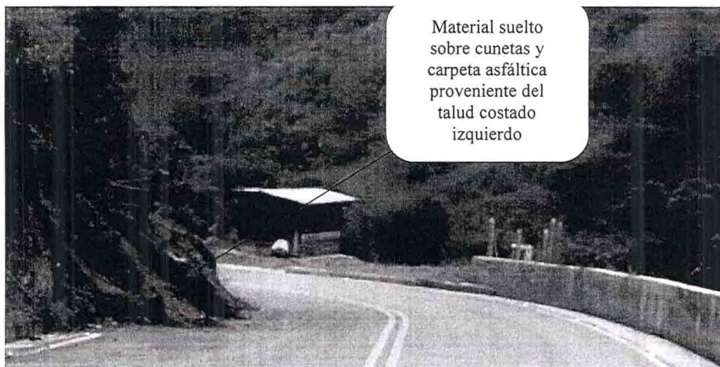
Ilustración 21 PR 21+ 400 Presencia de material suelto sobre las cunetas y a lo ancho de la vía. proveniente del talud
