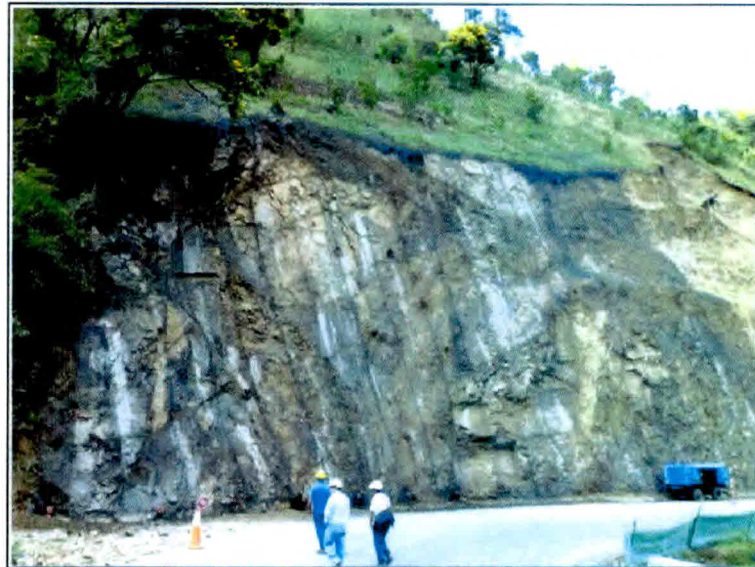
Fotografía 4. Tratamiento con malla y pernos de anclaje al inicio del tramo. Fuente: Propia. 19-ene-16
