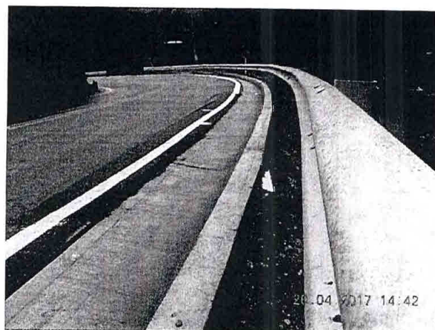
Ilustración 29 inclinación del muro en gavión y la cuneta en concreto
