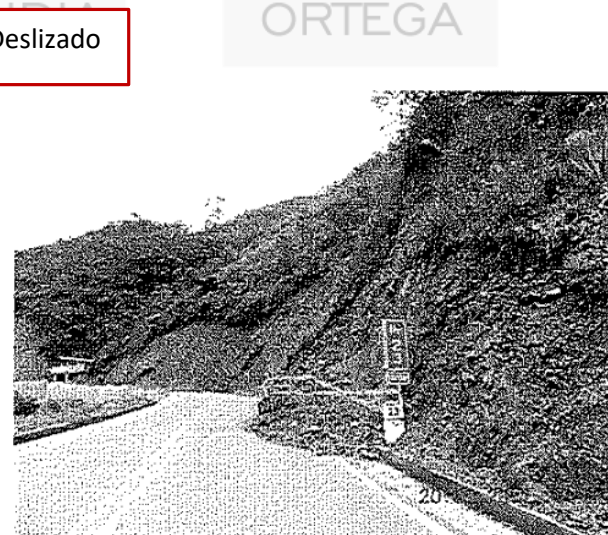
Fotografía 10.1-4. Obstrucción de cuneta y contaminación de la carpeta.
