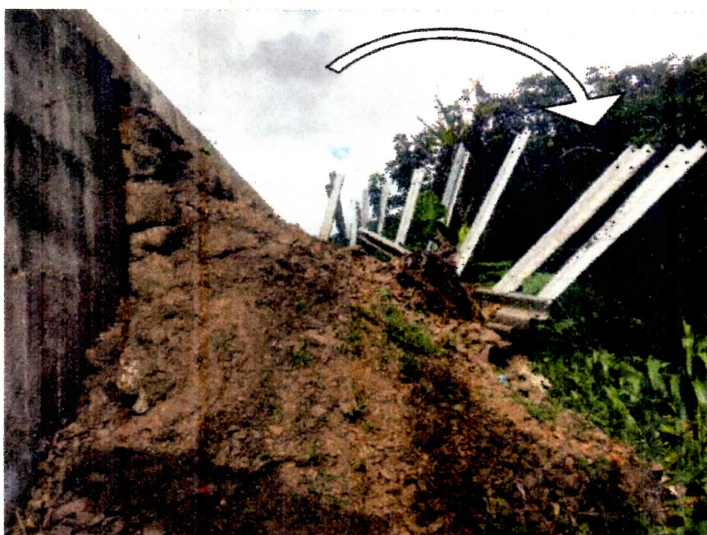
Desplazamiento de los elementos verticales PR33+840 MD, Vía Túquerres – Samaniego.
