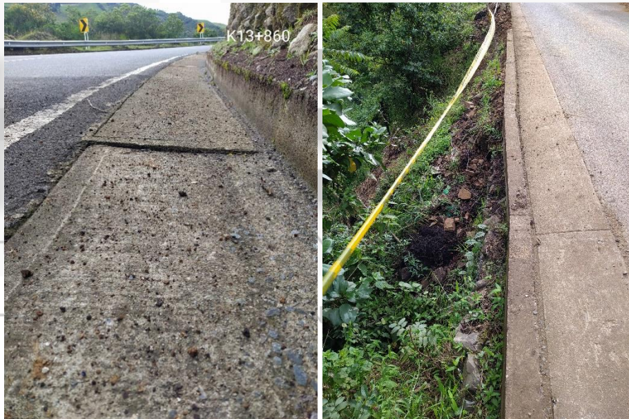
Fotografía 8.3-2 a) Berma cuneta dislocada PR14+500 – b) Daño en muro de contención PR22+200.
