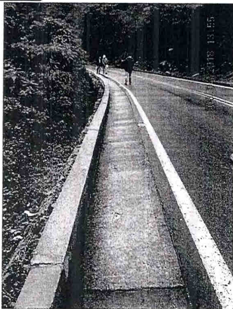
Ilustración 54 Cuneta en concreto en buen estado
