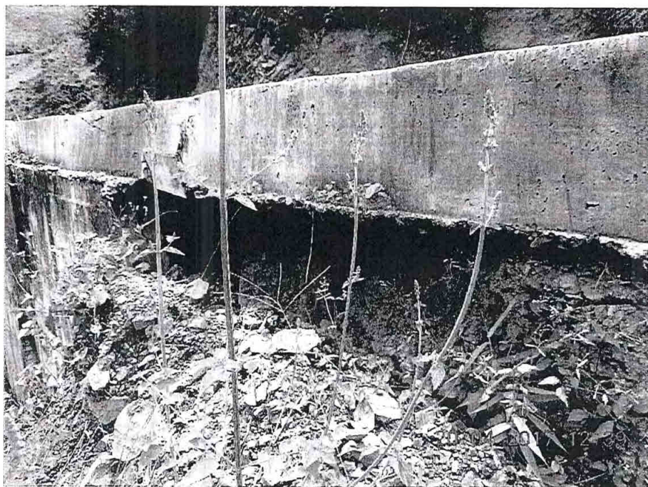
Ilustración 62 Estructura Granular totalmente saturada
