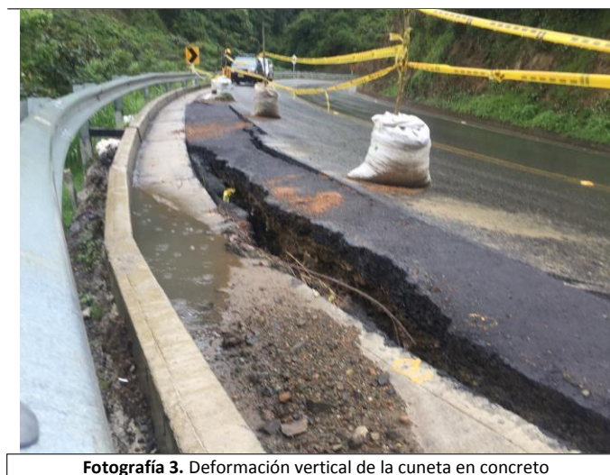
Fotografía 3. Deformación vertical de la cuneta en concreto
