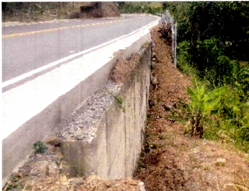
Mala conformación del relleno - PR33+840 MD, Vía Túquerres – Samaniego.
