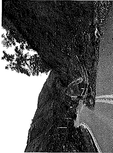
Fotografías No 21 y 22 Material de derrumbe colmatando las cunetas y desgaste prematuro de la carpeta asfáltica
