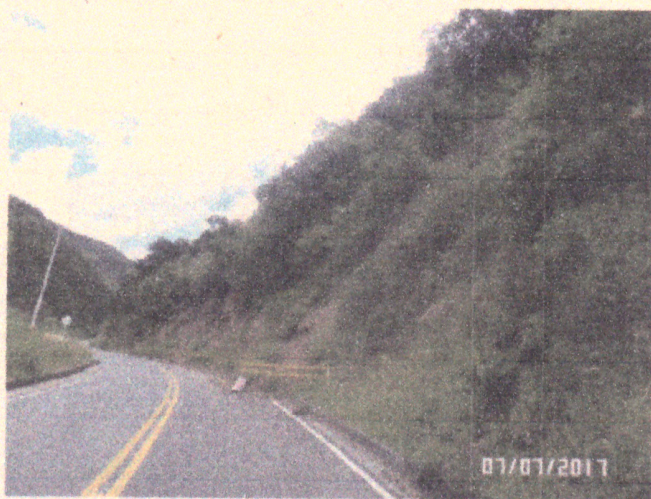
Fotografía 18. PR 33+840 Deslizamiento Vial - Vía Túquerres – Samaniego.
