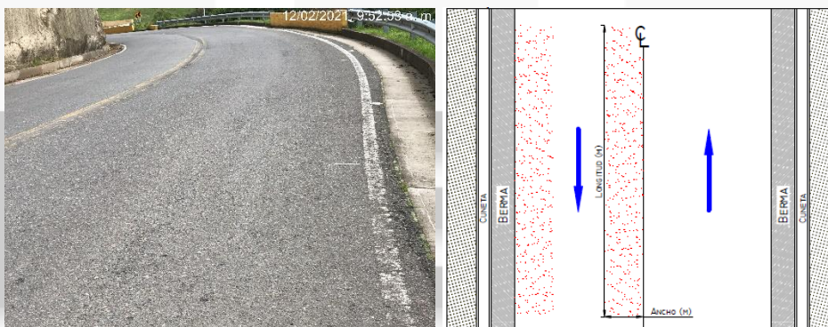
Figura 9.4-4. Desgaste superficial – PR 7+700.
