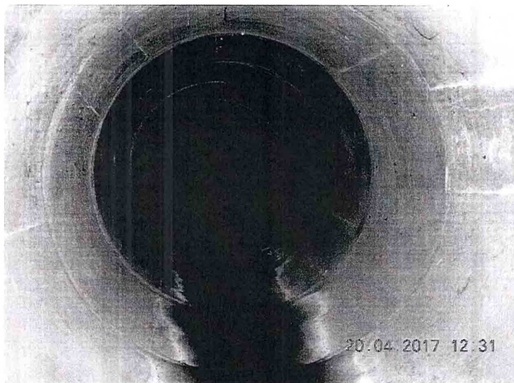
Ilustración 60 PR33+ 840 Alcantarilla y caja colectora colmatada con material de derrumbe
