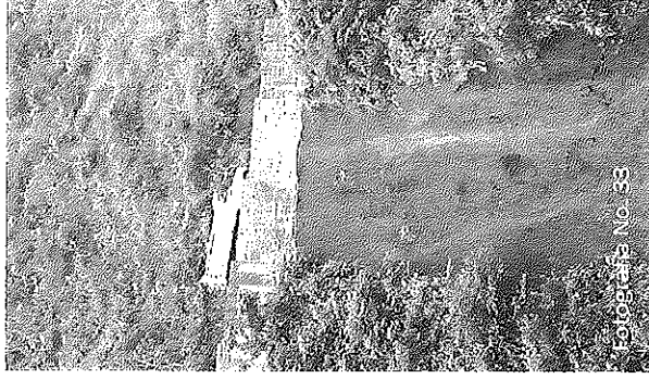
Fotografías No 32 y 33 Pr. 19+200 MD Derrumbe ocasionado por el invierno afectando el talud donde está ubicado el muro en concreto reforzado y a futuro puede ocasionar la desestabilización del mismo y daños a la estructura pavimento
