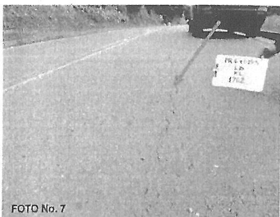
6+0193. FISURAS LONGITUDINALES
