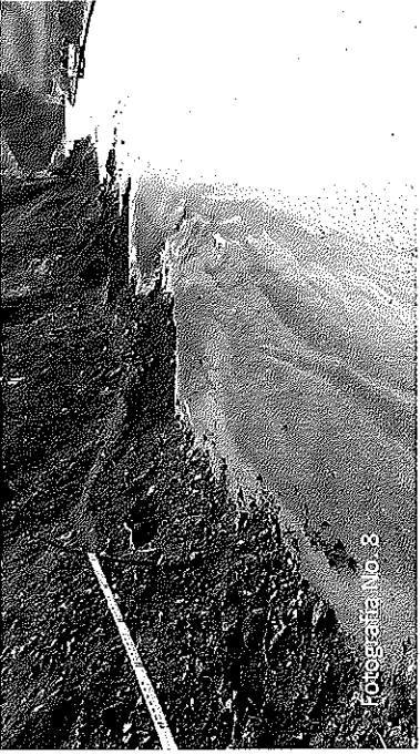
Fotografía No 8 Material de derrumbe colmatando las cunetas y desgaste prematuro de la carpeta asfáltica por flujo de agua sobre la misma
