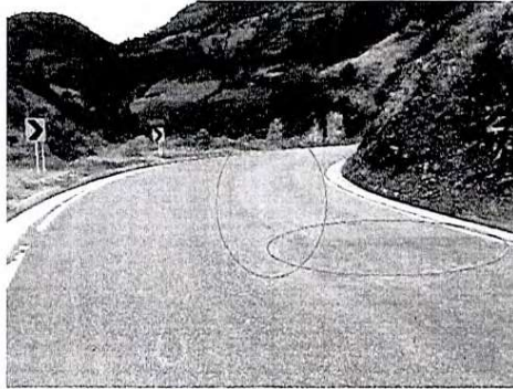
Figura 3.6. PR 18+980 (2): áreas diferenciadas con y sin desgaste superficial
