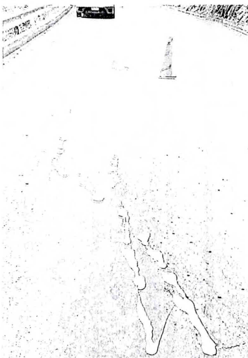
PR 33+750 Sello de fisura con liga asfáltica
