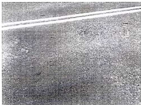
Desgastes de alta profundidad cerca de la junta en el carril derecho.
