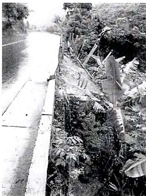
Figura 3.24. PR 33+750: Trincho metálico con inclinación
