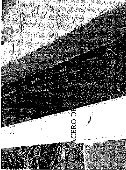
Fotografía No. 13 Armado de hierro para soporte de cuneta
