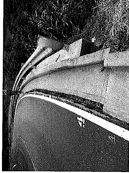
Fotografía No.1 Junta entre la cuneta y la carpeta asfáltica
