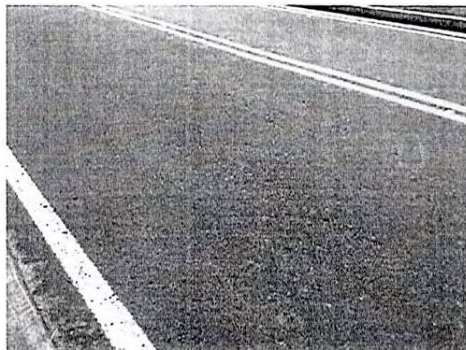
Ojos de pescado en superficie con bajo desgaste (carril izquierdo)
