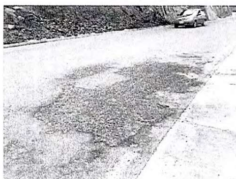
Figura 3.11. PR 19+600 (2): pérdida de ligante por posible riego de combustible
