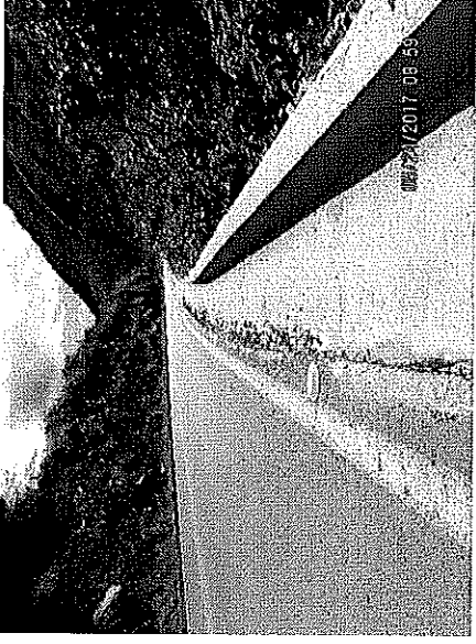
Fotografía No. 10 Cuneta sobre Muro de Gaviones, sellada con liga asfáltica
