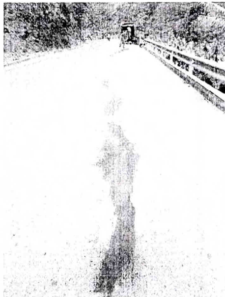
PR 33+750 sello de fisuras con arena y emulsión
