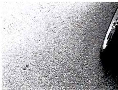
Figura 3.5. PR 18+980 (1): desconchamientos en la superficie de la capa de rodadura
