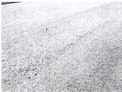
Figura 3.16. PR 21+400 (2): pérdida de agregados en el carril izquierdo
