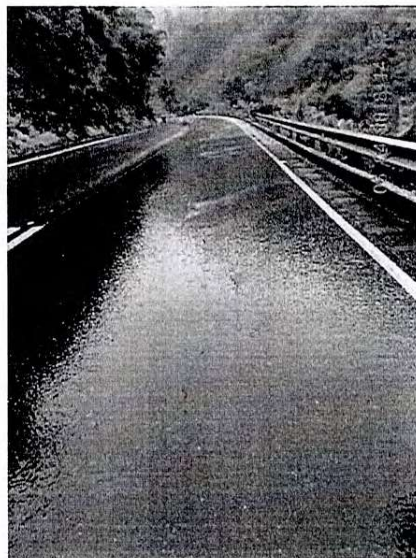
Figura 3.26. Fisura longitudinal en Carpeta Asfáltica
