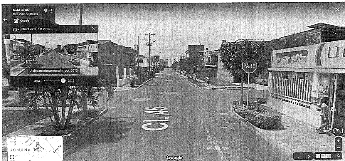
Figura 2. Señal vertical SR-01 instalada en la intersección de la calle 45 con carrera 67, sentido norte-sur, año de instalación 2009.
