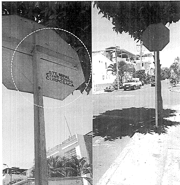
Figura 1. Señal vertical SR-01 instalada en la intersección de la calle 45 con carrera 67, sentido norte-sur, año de instalación 2009.
